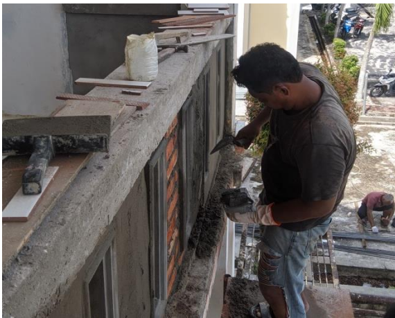
Gambar 3.15 Plesteran Dinding Pagar Balkon (Sumber : Dokumentasi Pribadi, 2023)
