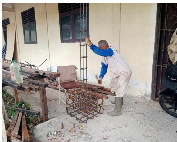
Gambar 3.25 Penggabungan Tulangan Kolom dan Tulangan Pondasi (Sumber : Dokumentasi Pribadi, 2023)
