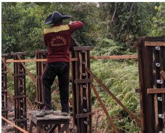
Gambar 3.30 Pengecoran Kolom / Tiang Pagar (Sumber : Dokumentasi Pribadi, 2023)
