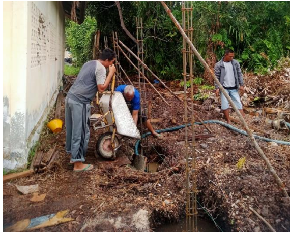
Gambar 3.29 Pengecoran Pondasi Pagar (Sumber : Dokumentasi Pribadi, 2023)
