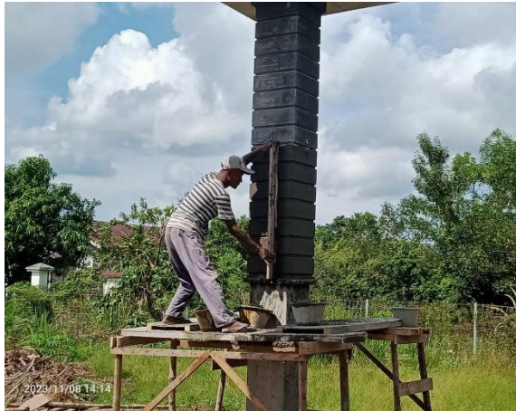
Gambar 3.42 Pembuatan Relief Kolom (Sumber : Dokumentasi Pribadi, 2023)
