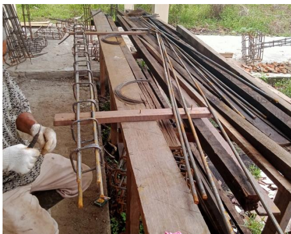
Gambar 3.24 Perakitan Besi Tulangan (Sumber : Dokumentasi Pribadi, 2023)
