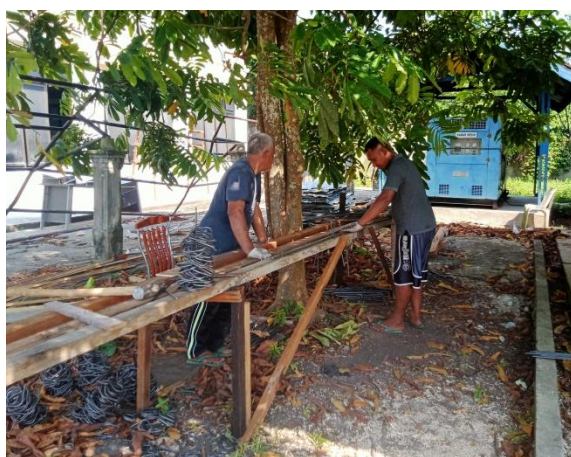
Gambar 3.23 Pembengkokan Besi Tulangan (Sumber : Dokumentasi Pribadi, 2023)
