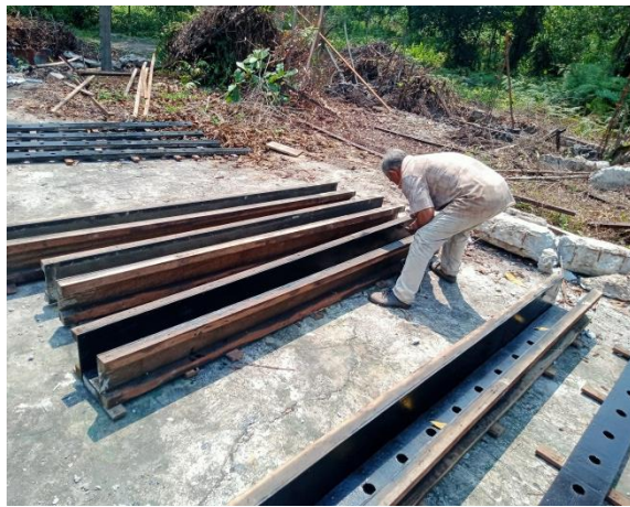
Gambar 3.27 Pengolesan Minyak Pada Bekisting (Sumber : Dokumentasi Pribadi, 2023)
