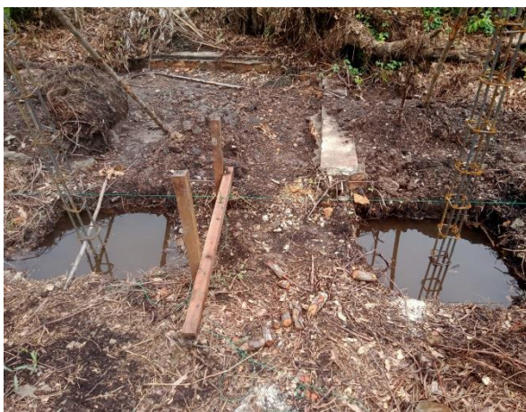
Gambar 3.26 Peletakan Besi Tulangan (Sumber : Dokumentasi Pribadi, 2023)
