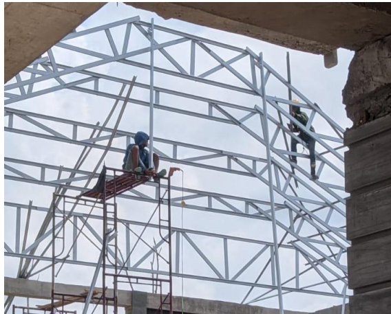
Gambar 3.58 Pemasangan Rangka Atap (Sumber : Dokumentasi Pribadi, 2023)
