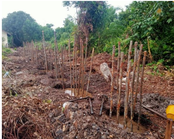
Gambar 3.22 Pemasangan Cerucuk (Sumber : Dokumentasi Pribadi, 2023)
