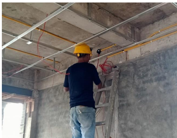
Gambar 3.62 Pemasangan Instalasi Stop Kontak AC (Sumber : Dokumentasi Pribadi, 2023)
