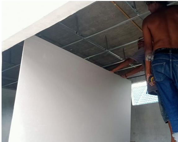
Gambar 3.57 Pemasangan Plafond (Sumber : Dokumentasi Pribadi, 2023)
