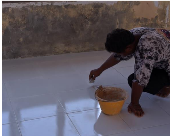
Gambar 3.12 Pendempulan Keramik Lantai (Sumber : Dokumentasi Pribadi, 2023)
