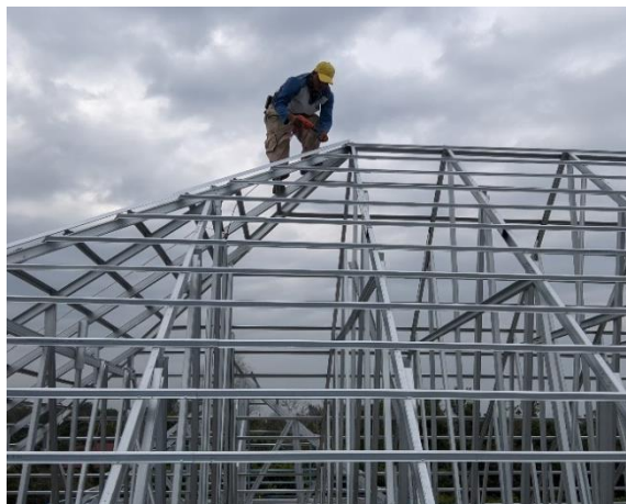
Gambar 3.1 Pemasangan Rangka Atap (Sumber : Dokumentasi Pribadi, 2023)
