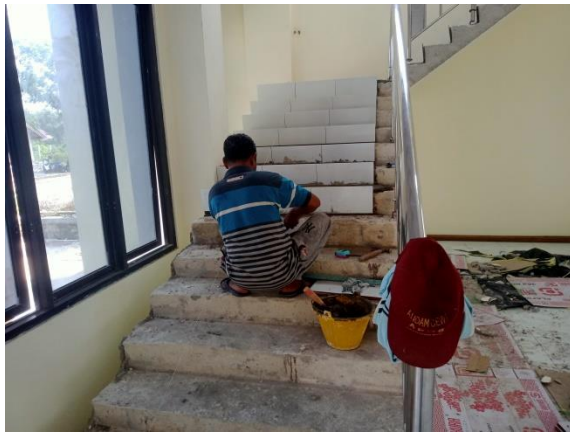
Gambar 3.11 Pemasangan Keramik Tangga (Sumber : Dokumentasi Pribadi, 2023)
