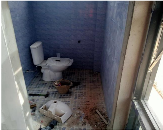
Gambar 3.64 Pemasangan Kloset dan Wastafel (Sumber : Dokumentasi Pribadi, 2023)
