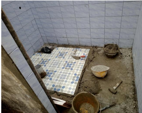
Gambar 3.49 Pemasangan Keramik Lantai Kamar Mandi (Sumber : Dokumentasi Pribadi, 2023)
