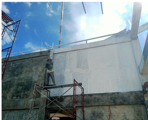
Gambar 3.60 Pengecatan Dasar Tembok (Sumber : Dokumentasi Pribadi, 2023)
