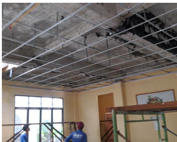
Gambar 3.3 Pemasangan Rangka Plafond (Sumber : Dokumentasi Pribadi, 2023)
