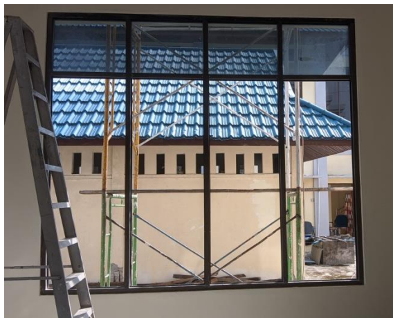
Gambar 3.19 Pembongkaran Jendela (Sumber : Dokumentasi Pribadi, 2023)
