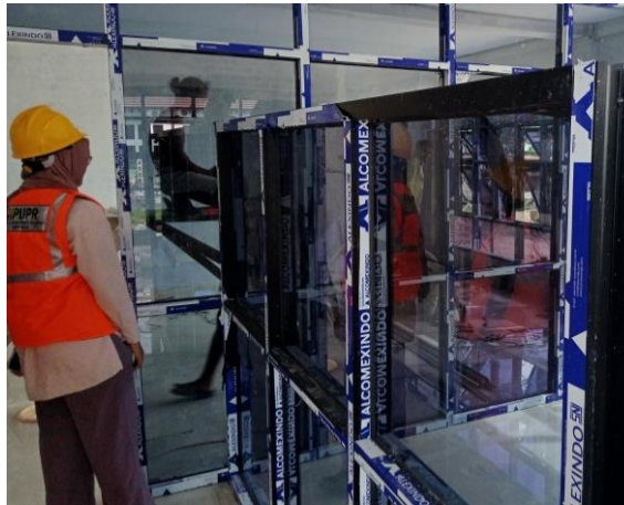
Gambar 3.55 Pemasangan Dinding Partisi Alumunium (Sumber : Dokumentasi Pribadi, 2023)
