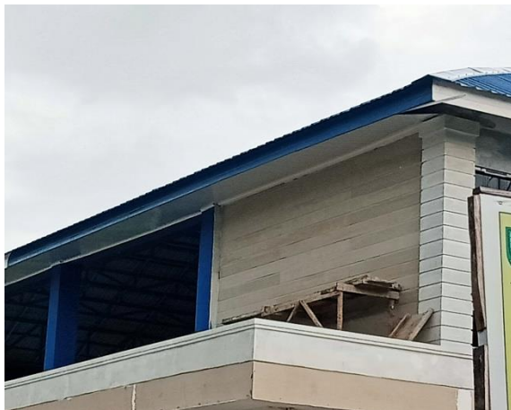
Gambar 3.45 Pemasangan Papan Conwood (Sumber : Dokumentasi Pribadi, 2023)
