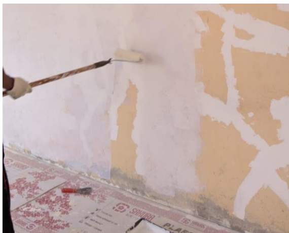
Gambar 3.17 Pengecatan Dasar Tembok (Sumber : Dokumentasi Pribadi, 2023)
