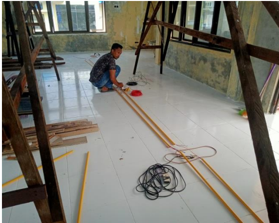
Gambar 3.36 Perbaikan Instalasi Lampu (Sumber : Dokumentasi Pribadi, 2023)
