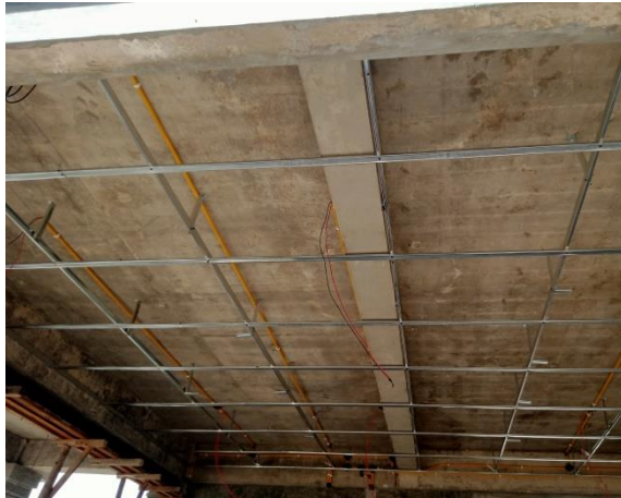
Gambar 3.56 Pemasangan Rangka Plafond (Sumber : Dokumentasi Pribadi, 2023)
