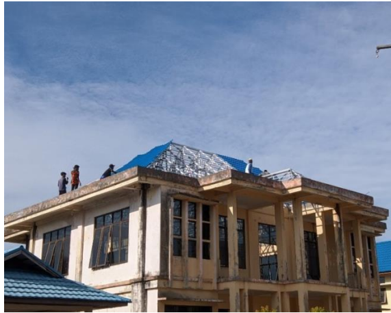
Gambar 3.2 Pemasangan Atap (Sumber : Dokumentasi Pribadi, 2023)
