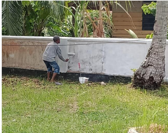
Gambar 3.34 Pengecatan Dasar Tembok Pagar (Sumber : Dokumentasi Pribadi, 2023)
