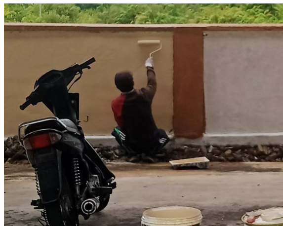
Gambar 3.35 Pengecatan Tembok Pagar (Sumber : Dokumentasi Pribadi, 2023)
