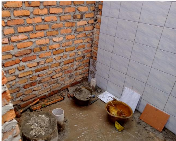
Gambar 3.44 Pemasangan Keramik Dinding Kamar Mandi (Sumber : Dokumentasi Pribadi, 2023)
