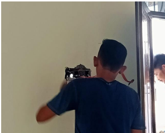
Gambar 3.37 Perbaikan Saklar Lampu (Sumber : Dokumentasi Pribadi, 2023)
