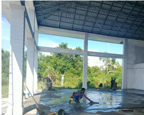
Gambar 3.47 Floor Hardener Lapangan Lantai Workshop (Sumber : Dokumentasi Pribadi, 2023)
