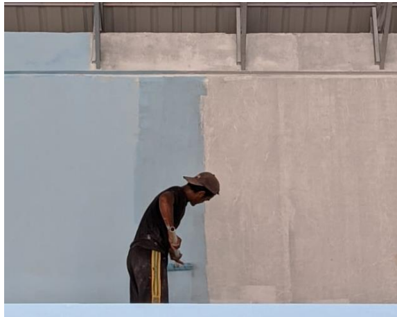
Gambar 3.61 Pengecatan Tembok (Sumber : Dokumentasi Pribadi, 2023)
