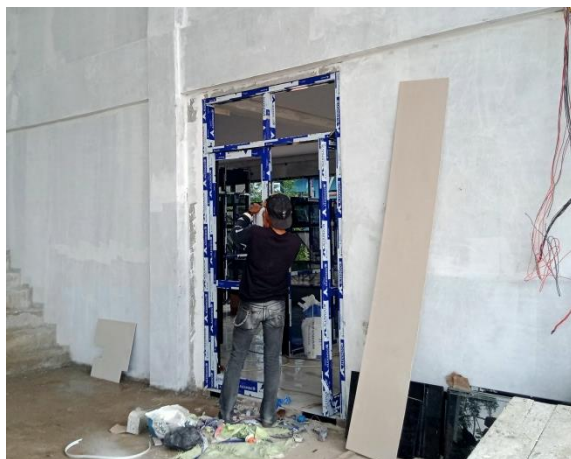
Gambar 3.52 Pemasangan Pintu Alumunium (Sumber : Dokumentasi Pribadi, 2023)
