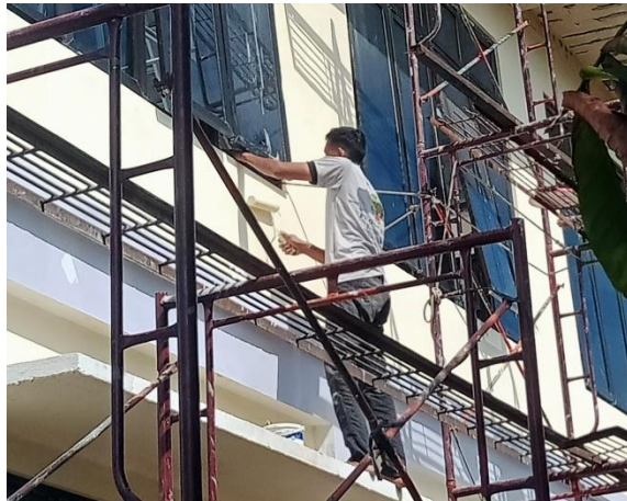
Gambar 3.18 Pengecatan Tembok (Sumber : Dokumentasi Pribadi, 2023)
