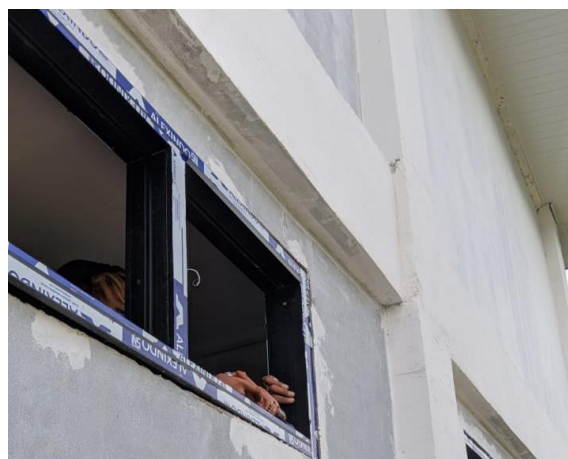
Gambar 3.54 Pemasangan Ventilasi Alumunium (Sumber : Dokumentasi Pribadi, 2023)
