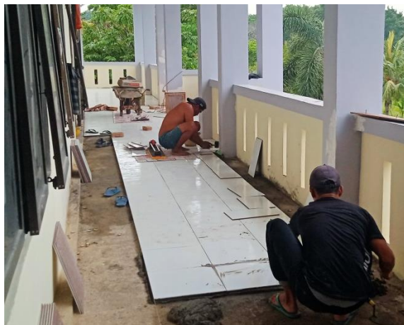
Gambar 3.9 Pemasangan Keramik Balkon (Sumber : Dokumentasi Pribadi, 2023)
