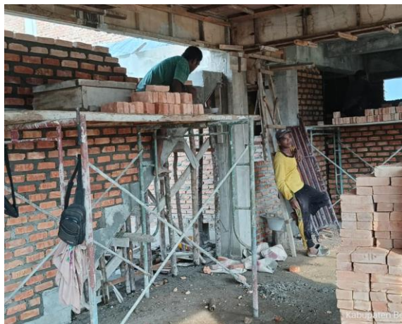
Gambar 3.38 Pemasangan Bata (Sumber : Dokumentasi Pribadi, 2023)
