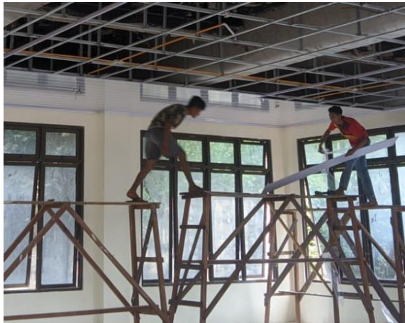
Gambar 3.4 Pemasangan Plafond (Sumber : Dokumentasi Pribadi, 2023)
