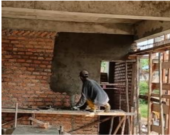
Gambar 3.39 Plesteran Dinding (Sumber : Dokumentasi Pribadi, 2023)
