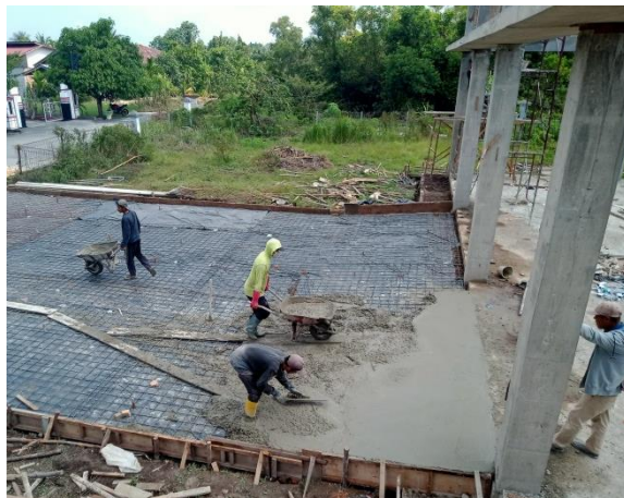
Gambar 3.46 Pengecoran Lantai Beton (Sumber : Dokumentasi Pribadi, 2023)
