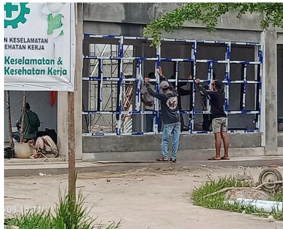
Gambar 3.53 Pemasangan Jendela Alumunium (Sumber : Dokumentasi Pribadi, 2023)
