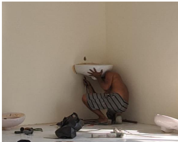
Gambar 3.33 Pemasangan Wastafel (Sumber : Dokumentasi Pribadi, 2023)
