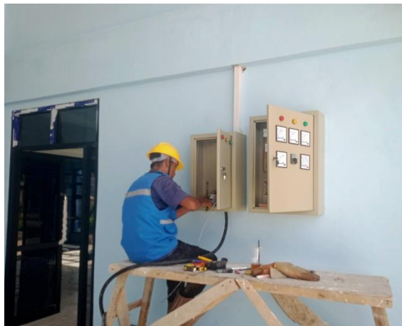
Gambar 3.63 Pemasangan Panel Listrik (Sumber : Dokumentasi Pribadi, 2023)
