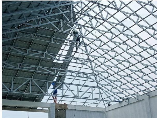
Gambar 3.59 Pemasangan Atap (Sumber : Dokumentasi Pribadi, 2023)
