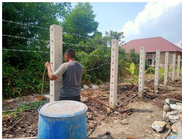
Gambar 3.31 Pekerjaan Pemasangan Kawat Berduri (Sumber : Dokumentasi Pribadi, 2023)
