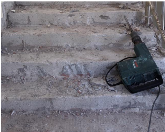
Gambar 3.7 Pembongkaran Keramik (Sumber : Dokumentasi Pribadi, 2023)
