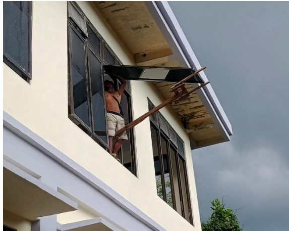
Gambar 3.20 Pemasangan Jendela (Sumber : Dokumentasi Pribadi, 2023)
