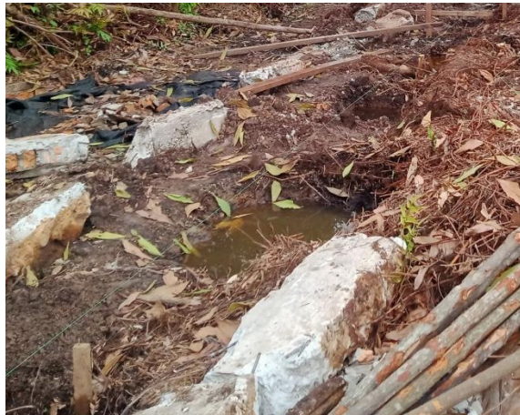
Gambar 3.21 Penggalian Pondasi Pagar (Sumber : Dokumentasi Pribadi, 2023)
