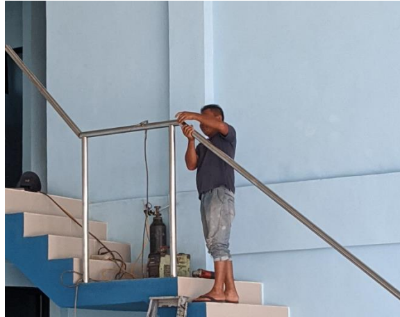
Gambar 3.66 Pemasangan Railing Tangga (Sumber : Dokumentasi Pribadi, 2023)
