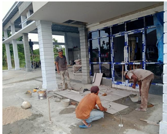
Gambar 3.50 Pemasangan Keramik Teras (Sumber : Dokumentasi Pribadi, 2023)
