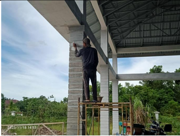
Pengecatan kolom
