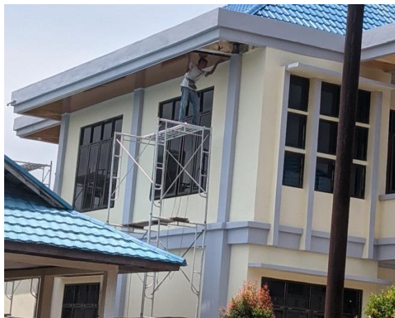
Gambar 3.5 Pemasangan Plafond Pada Piri-piri (Sumber : Dokumentasi Pribadi, 2023)
