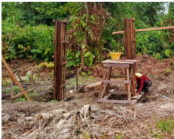
Gambar 3.28 Pemasangan Bekisting (Sumber : Dokumentasi Pribadi, 2023)
