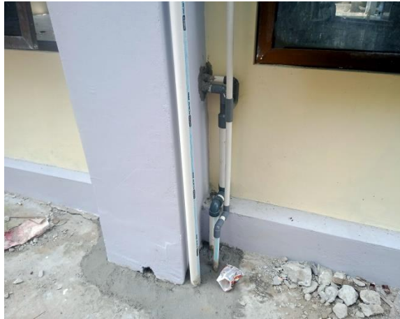
Gambar 3.32 Pemasangan Instalasi Air Bersih dan Air Kotor (Sumber : Dokumentasi Pribadi, 2023)
