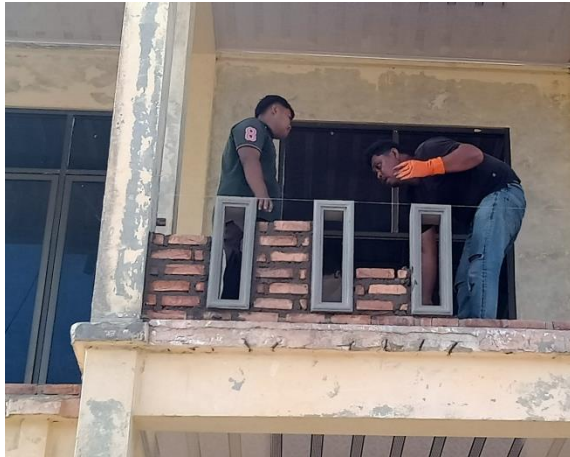
Gambar 3.14 Pemasangan Batu Kerawang (Sumber : Dokumentasi Pribadi, 2023)
