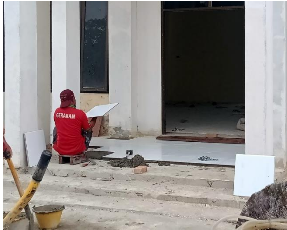
Gambar 3.10 Pemasangan Keramik Teras (Sumber : Dokumentasi Pribadi, 2023)
