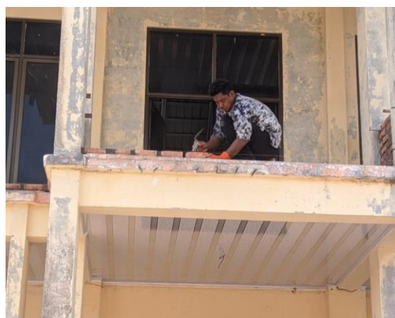
Gambar 3.13 Pemasangan Dinding Pagar Balkon (Sumber : Dokumentasi Pribadi, 2023)
