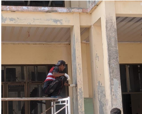
Gambar 3.16 Pengikisan Cat (Sumber : Dokumentasi Pribadi, 2023)
