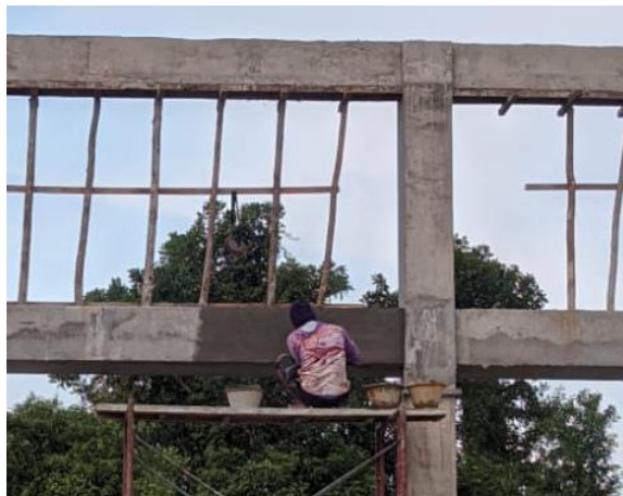
Gambar 3.40 Pengacian Pada Balok (Sumber : Dokumentasi Pribadi, 2023)
