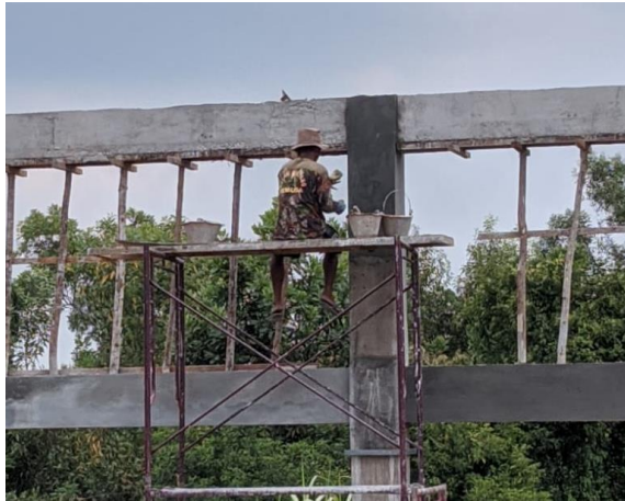
Gambar 3.41 Pengacian Pada Kolom (Sumber : Dokumentasi Pribadi, 2023)
