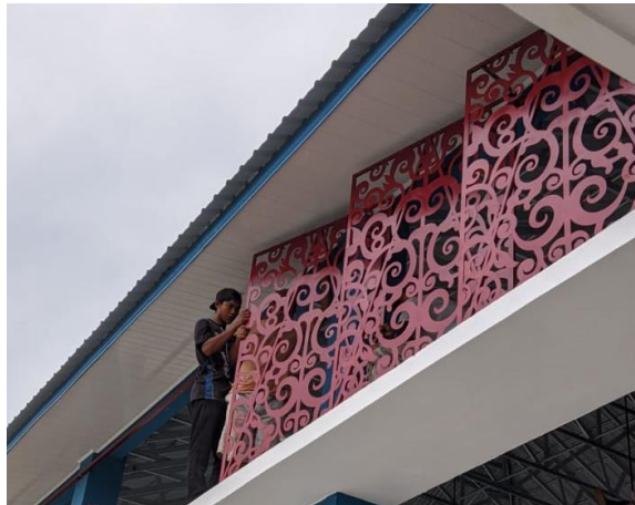
Gambar 3.43 Pemasangan Plat Cutting (Sumber : Dokumentasi Pribadi, 2023)
