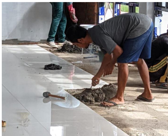
Gambar 3.48 Pemasangan Keramik Lantai (Sumber : Dokumentasi Pribadi, 2023)
