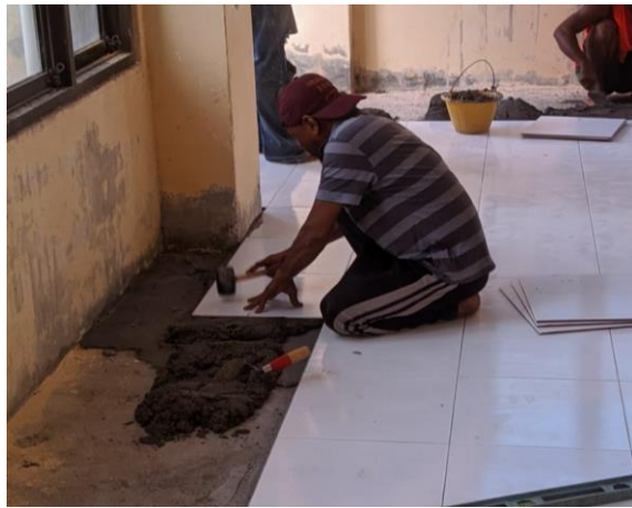
Gambar 3.8 Pemasangan Keramik Lantai (Sumber : Dokumentasi Pribadi, 2023)
