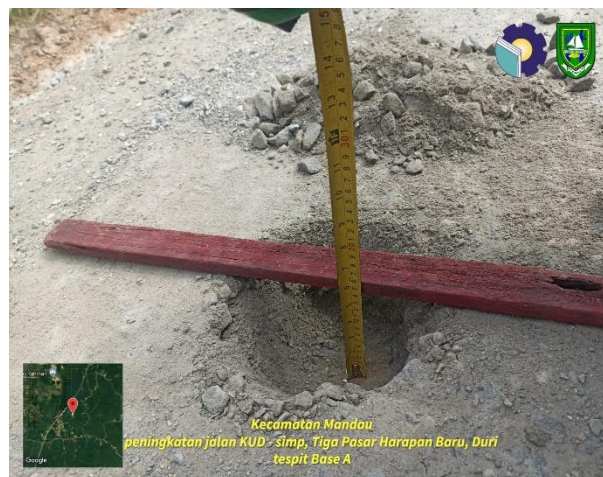
Gambar 3.21 Test Pit Pada Agregat Kelas A
