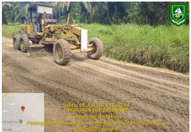
Gambar 3.14 Perkerjaan Penghamparan Agregat Kelas B (Sumber: Dokumentasi KP, 2023)
