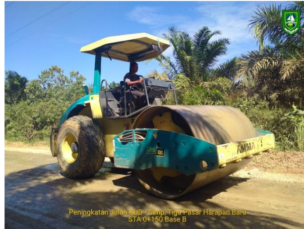
Gambar 4.2 Vibratory Roller ( Sumber : Dokumentasi KP, 2023)
