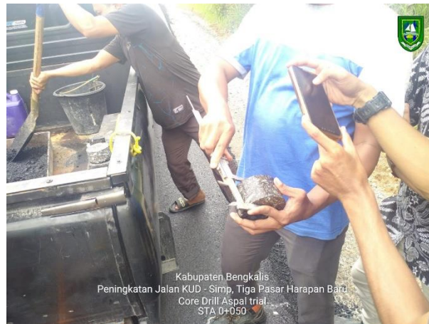
Gambar 3.34 Pengujian Core Drill (Sumber: Dokumentasi KP, 2023)
