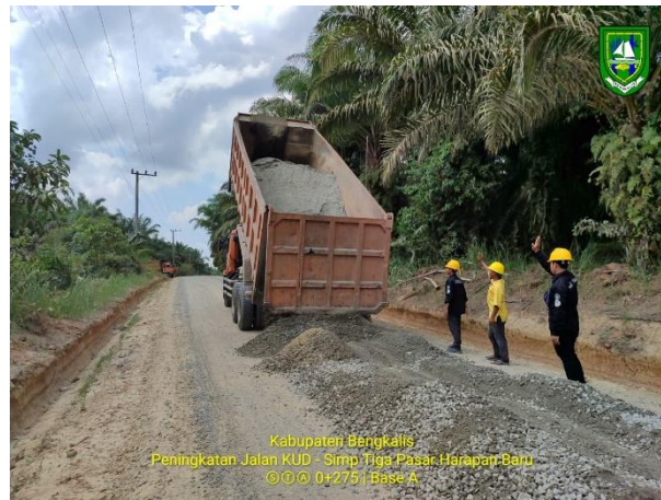
Gambar 3.18 Base A diturunkan dari Dump Truk (Sumber: Dokumentasi KP, 2023)
