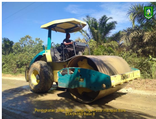
Gambar 3.4 Vibratory Roller ( Sumber: Dokumentasi KP, 2023 )
