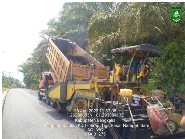
Gambar 3.9 Asphalt Finisher (Sumber: Dokumentasi KP, 2023)
