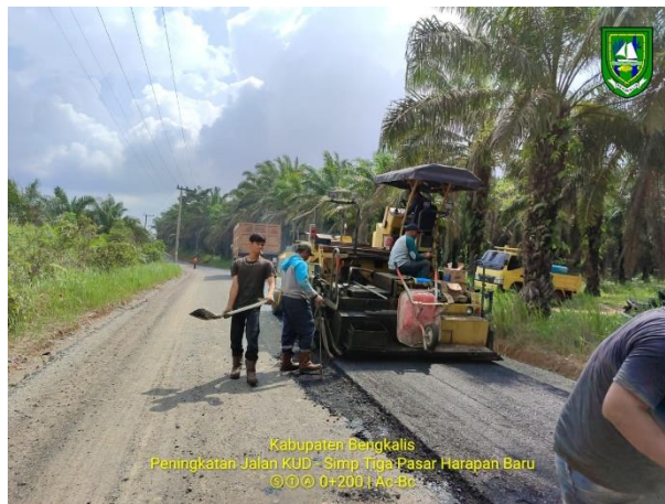
Gambar 3.30 Pekerjaan Penghamparan Campuran Hotmix (Sumber: Dokumentasi KP, 2023)
