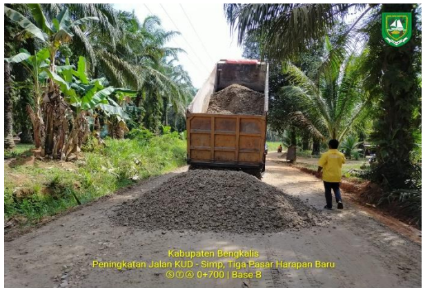
Gambar 3.13 Base B diturunkan dari Dump Truk (Sumber: Dokumentasi KP, 2023)
