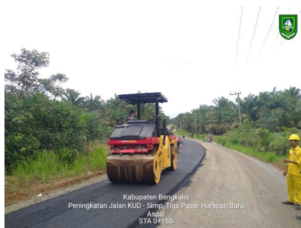
Gambar 3.32 Pekerjaan Pematatan Menggunakan Tandaem Roller (Sumber: Dokumentasi KP, 2023)
