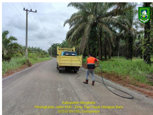
Gambar 3.26 Pekerjaan Air Kompresor (Sumber: Dokumentasi KP, 2023)
