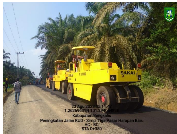
Gambar 3.33 Pekerjaan Pemadatan Menggunakan PTR
