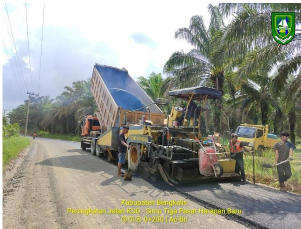
Gambar 3.29 Pekerjaan Mobilisasi Campuran Hotmix (Sumber: Dokumentasi KP, 2023)
