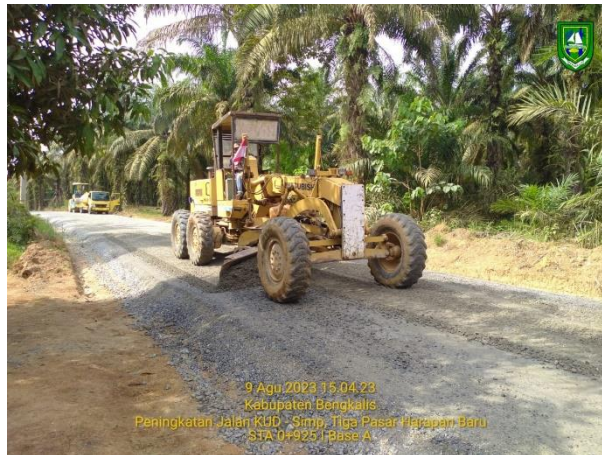
Gambar 4.1 Motor Grader ( Sumber : Dokumentasi KP, 2023)
