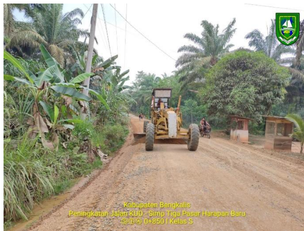
Gambar 3.24 Pekerjaan Penghamparan Agregat Kelas S (Sumber: Dokumentasi KP, 2023)
