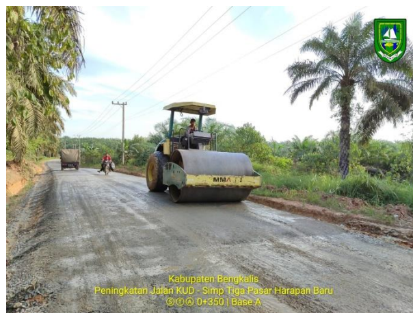
Gambar 3.20 Perkerjaan Pematatan Lapis Pondasi Agregat Kelas A
