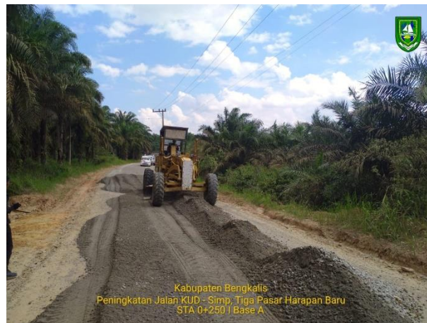
Gambar 3.18 Base A diturunkan dari Dump Truk (Sumber: Dokumentasi KP, 2023)
