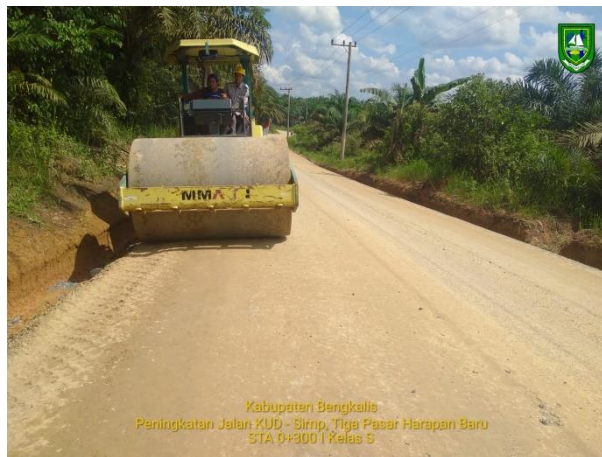
Gambar 3.25 Pekerjaan Pemasatan Agregat Kelas S
