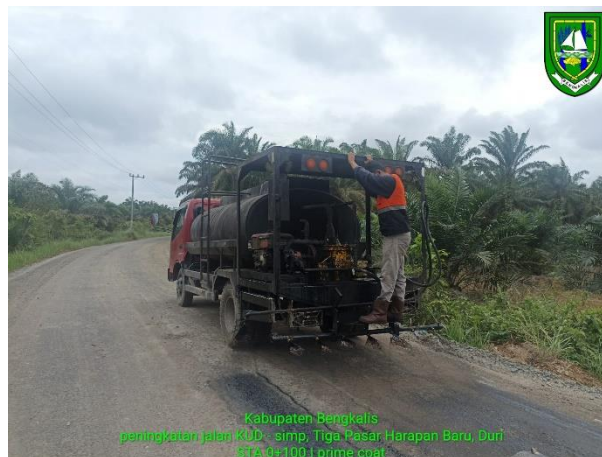
Gambar 3.27 Pekerjaan Penyiraman Prime Coat dan Tack Coat (Sumber: Dokumentasi KP, 2023)
