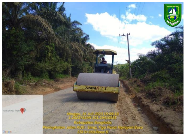
Gambar 3.15 Perkerjaan Pemasatan Lapis Pondasi Agregat Kelas B (Sumber: Dokumentasi KP, 2023)
