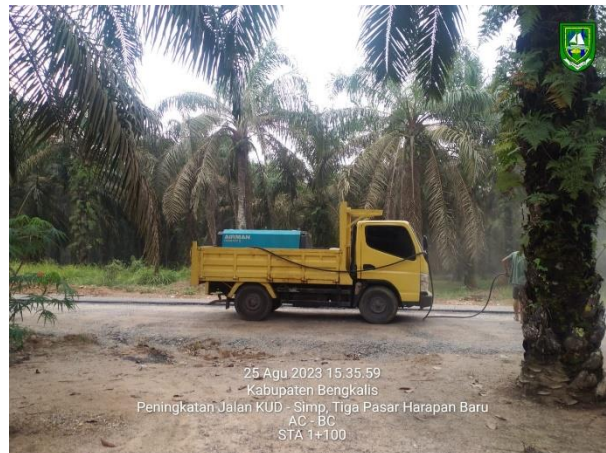
Gambar 3.8 Air Compressor (Sumber: Dokumentasi KP, 2023)
