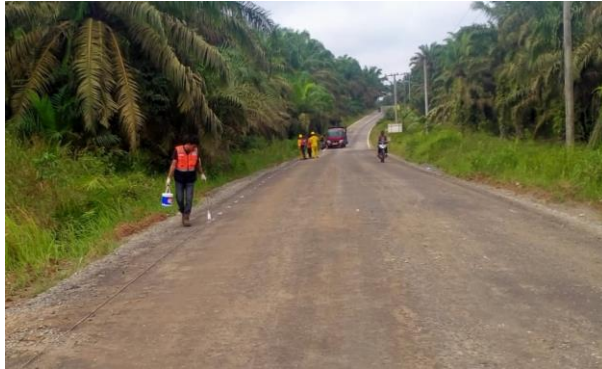
Gambar 3.28 Pekerjaan Pembuatan Marka Acuan (Sumber: Dokumentasi KP, 2023)
