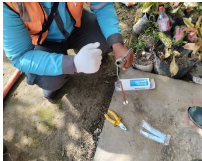
Gambar 2.21 Penggantian fuse link pada tabung holder CO
