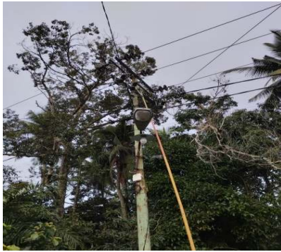
Gambar 2.24 Perbaikan fuse link pada tabung holder CO
