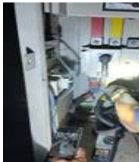
Gambar 2.35. Pengukuran PHBTR Sumber : PLN PT. Adra gemilang 2023
