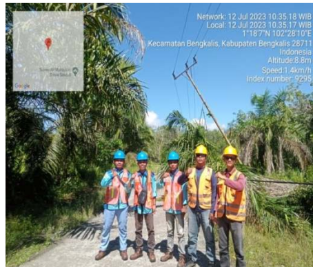
Gambar 2.2 Perbaikan tiang miring dan kabel SKU
