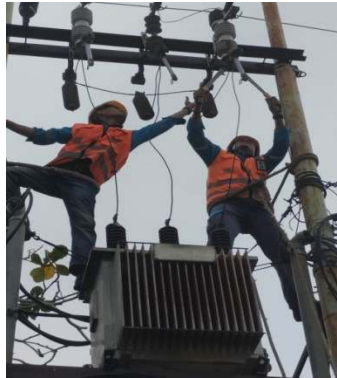
Gambar 2.22 Pelepasan kabel Arrester
