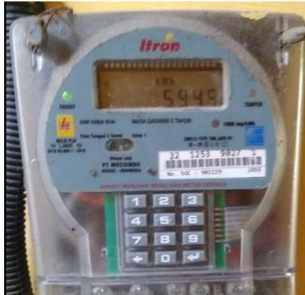
Gambar 2.34. Perbaikan KWH Meter Sumber : PLN PT. Adra gemilang 2023
