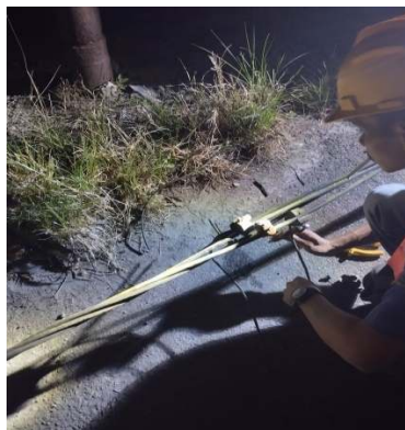
Gambar 2.17 Perbaikan Pierching SR
