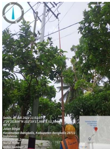
Gambar 2.5 Penggantian fush link pada tabung holder CO
