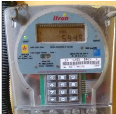
Gambar 2.7 Perbaikan KWH Meter
