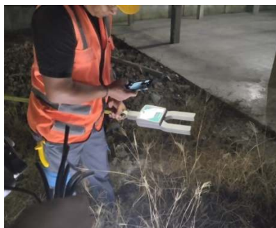
Gambar 2.23 Pengukuran kabel JTM menggunakan Ampstick
