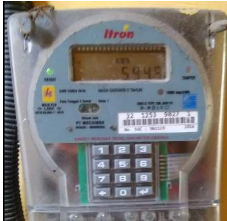
Gambar 2.26 Perbaikan KWH Meter
