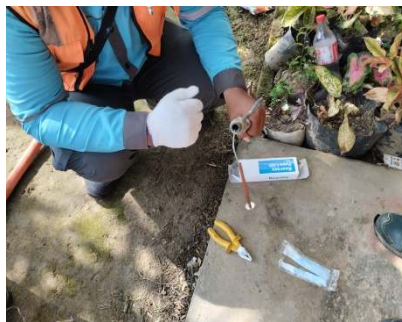
Gambar 2.31 Penggantian fuse link CO
