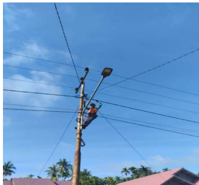
Gambar 2.25 Perbaikan pierching kabel SR
