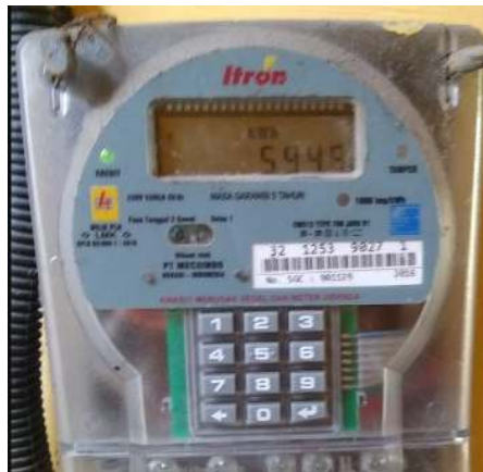
Gambar 2.19 Perbaikan KWH Meter
