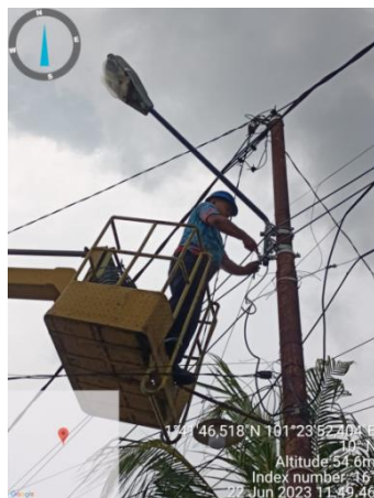
Gambar 2. 13 Pemasangan lampu penerangan jalan umum
