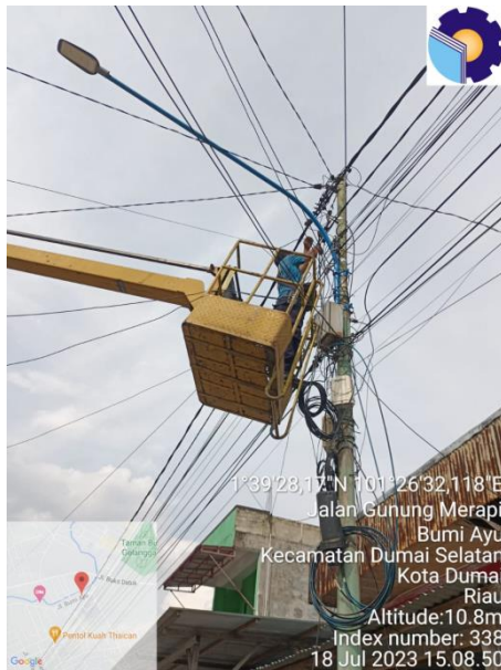
Gambar 2. 30 Memasang lampu LED pada tiang TR
