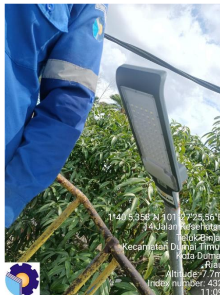
Gambar 2.45 Mengganti lampu LED
