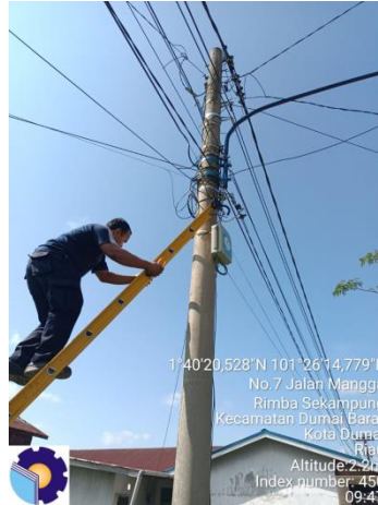
Gambar 2.54 Perbaikan lampu jalan menggunakan tangga
