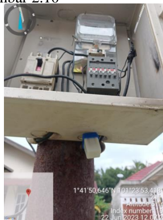
Gambar 2. 10 Pemasangan photocell pada panel box
