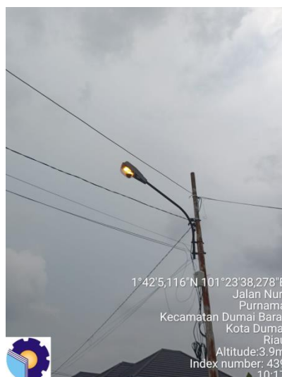
Gambar 2.47 Pemasangankan lampu SON-T
