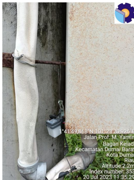
Gambar 2. 35 Memasang photocell pada phbtr PJU
