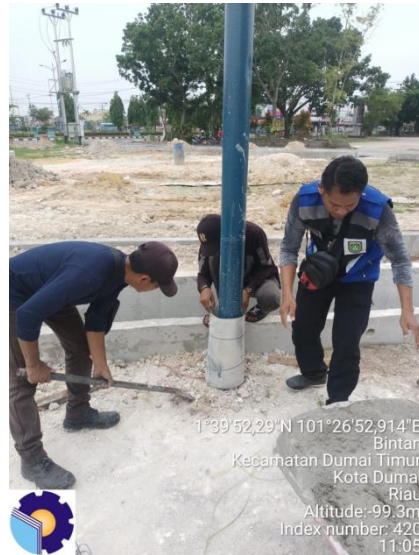
Gambar 2.42 Mengecor tiang PJU
