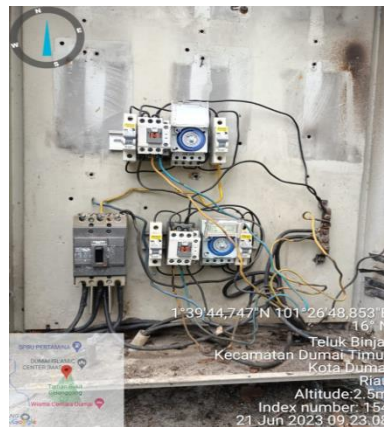
Gambar 2. 9 Menyetel timer lampu sorot
