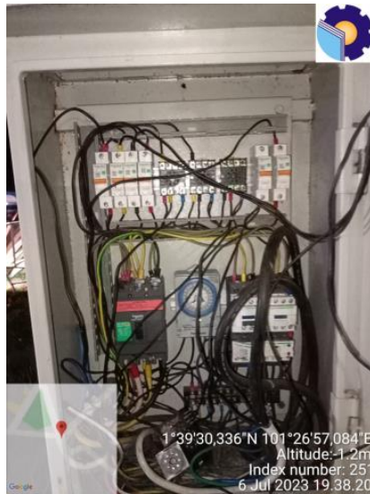
Gambar 2. 26 Menyetel timer pada panel
