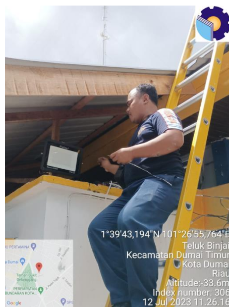
Gambar 2. 19 Pemasangan lampu sorot dibelakang kantor
