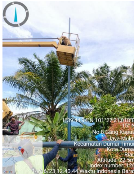
Gambar 2. 3 Proses penegakan tiang
