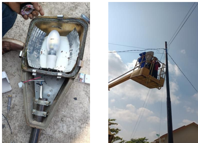
Gambar 2. 2 Mengganti lampu jalan menggunakan photocell
