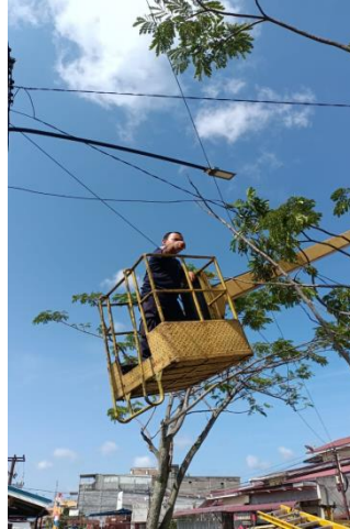
Gambar 2.52 Pengecekan lampu LED dengan mobil kren
