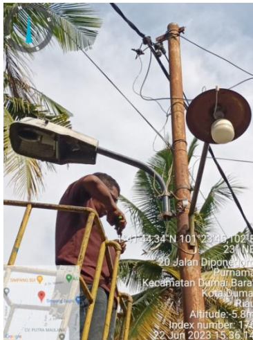
Gambar 2. 12 Jumper menggunakan photocell
