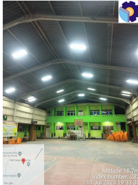
Gambar 2. 22 Menyelesaikan menggantian lampu di SMAN 1 Dumai
