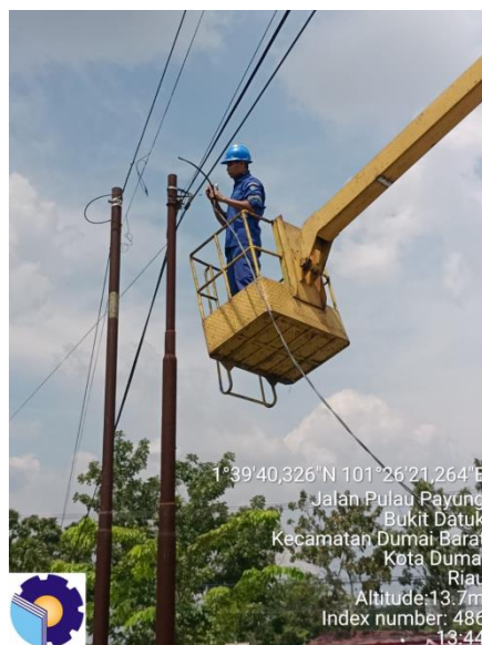
Gambar 2.59 Menegakkan kabel TR
