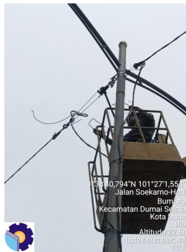
Gambar 2.50 Pemasangan piercing
