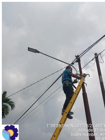
Gambar 2.51 Memasang lampu LED menggunakan tangga
