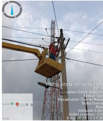
Gambar 2. 11 Pemasangan lampu SON-T pada TM
