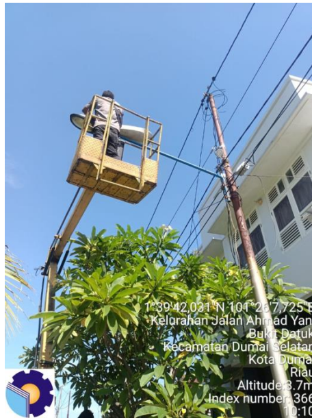
Gambar 2. 36 Pemangkasan dan perbaikan lampu jalan
