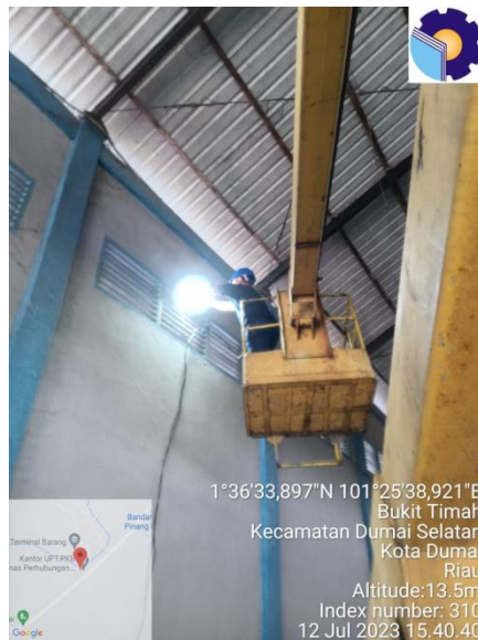
Gambar 2. 24 Pemasangan lampu sorot untuk penerangan
