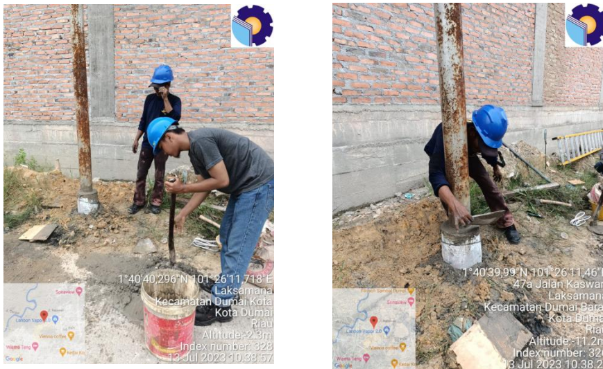
Gambar 2. 25 Pemasangan lampu sorot untuk penerangan
