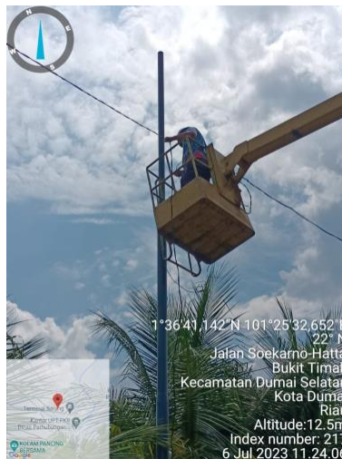
Gambar 2. 27 Pemasangan kabel pada tiang PJU
