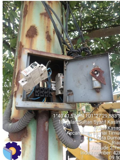
Gambar 2.44 Menjamper 2 lampu LED Hori
