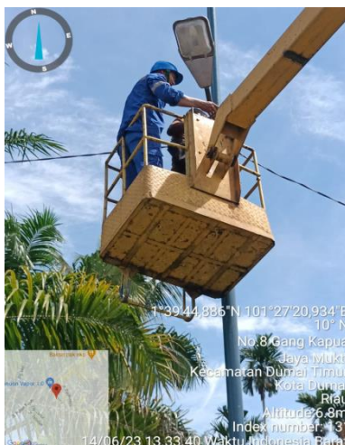
Gambar 2. 6 Pemasangan lampu beserta cupnya
