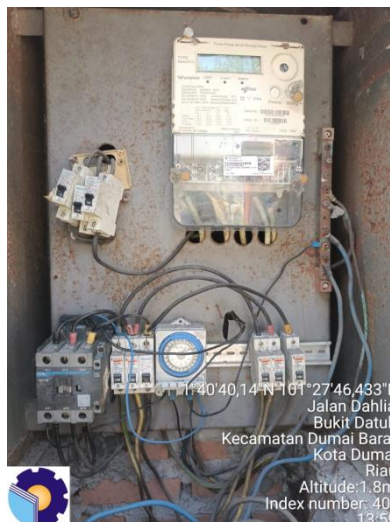
Gambar 2. 39 Mengganti kontaktor
