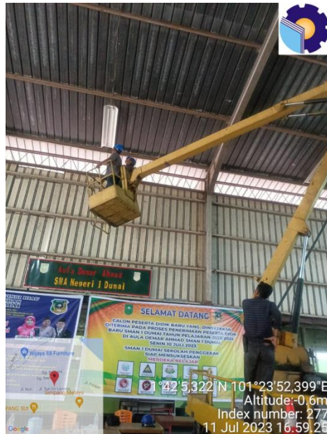
Gambar 2. 20 Penggantian lampu pada SMAN 1 Dumai
