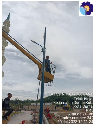
Gambar 2. 34 Penegakan kabel pada mesjid islamiq center
