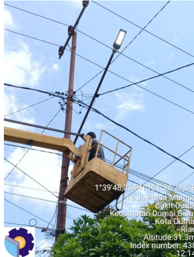
Gambar 2.48 Pemasangan lampu LED pada TM
