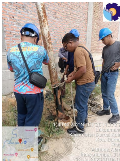
Gambar 2. 23 Meluruskan tiang yang sudah tumbang
