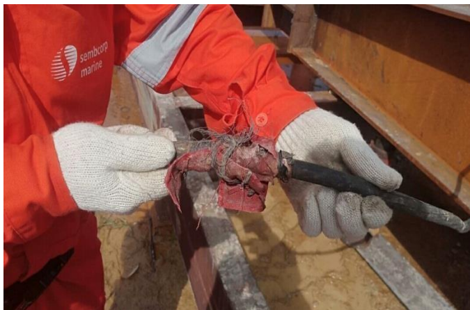
Gambar 2.17. penyambungan pada kabel las yang putus.
