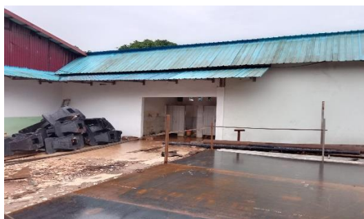
Gambar 1.12 Toilet dan Tempat Wudhu
