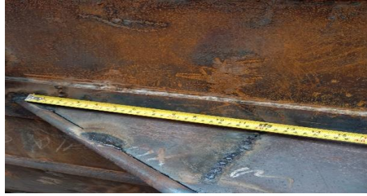
Gambar 2.65 Struktur dan Ukuran Pada Pemasangan Sirip
