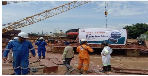
Gambar 2.89 Acara Keel Laying
