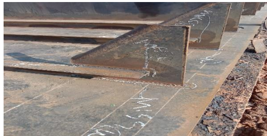
Gambar 2.61 Inspeksi Visual Welding Kontruksi
