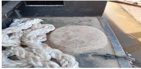
Gambar 2.84 Pengecoran pada Tutup Manhole
