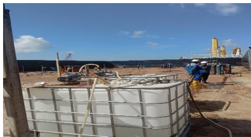
Gambar 2.25 Pengecekan Kebocoran Tangki Kapal
