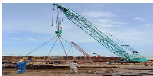
Gambar 2.80 Pemindahan Konstruksi Maindeck
