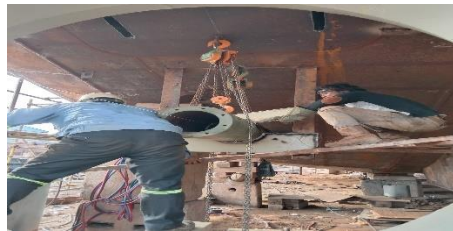
Gambar 2.53 Pemasangan Stern Tube
