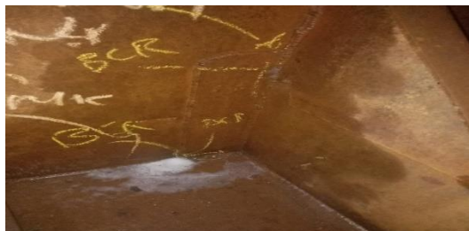
Gambar 2.23 Pengecekan Kebocoran Tangki
