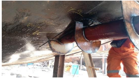
Gambar 2.71 pengecekan kebocoran external
