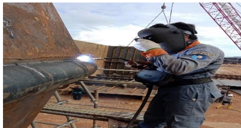
Gambar 2.74 posisi dan jarak yang benar dalam pengelasan
