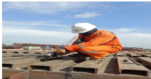
Gambar 2.60 Pengecekan dan mengamati Hasil Pengelasan Rampdoor
