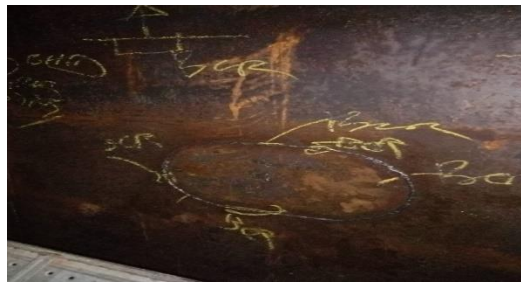
Gambar 2.38 Pengecekan Kebocoran 11,10,9,8 Hull.11
