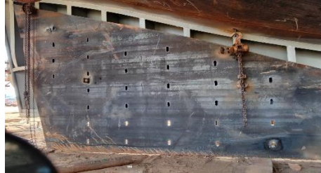
Gambar 2.81 Penutupan Plat Skeg
