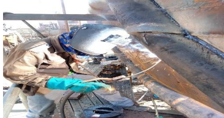
Gambar 2.72 pengelasan fender
