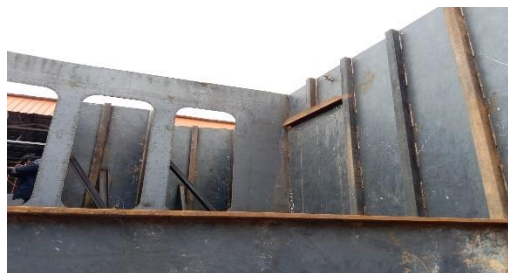
Gambar 2.66 Pembuatan Wellhouse
