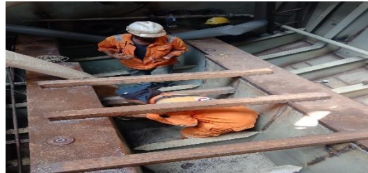
Gambar 2.90 Pengecekan dan pengamatan konstruksi Engine Girder
