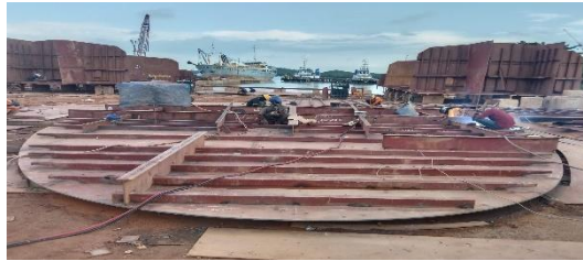
Gambar 2.111 inspeksi visual dan fitt up konstruksi dan weldingan
