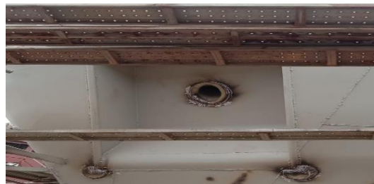
Gambar 2.91 Doubler pada Anchor Pipe
