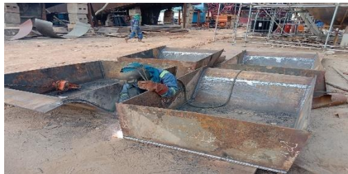
Gambar 2.49 Pembuatan Anker Pocket
