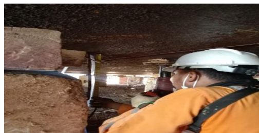
Gambar 2.59 Pengecekan Kemiringan dengan Air Dan Selang
