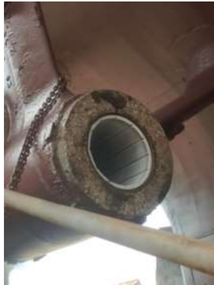
Gambar 3.25 Bantalan setelah pemasangan
