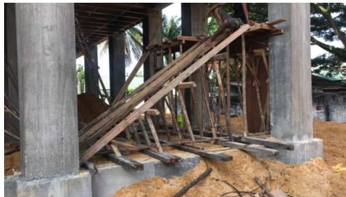
Gambar 3. 49 Pemasangan Perancah Dan Bekisting Tangga (Sumber): Dokumentasi Lapangan 2023
