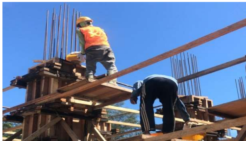
Gambar 3. 28 Pengecoran Kolom (Sumber): Dokumentasi Lapangan 2023
