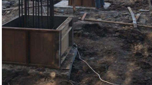
Gambar 3. 20 Bekisting Kolom Pedestal (Sumber): Dokumentasi lapangan 2023
