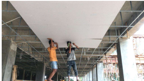
Gambar 3. 62 Pemasangan Plafond Gypsum (Sumber): Dokumentasi Lapangan 2023
