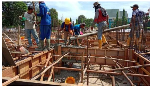
Gambar 3. 24 Pengecoran Balok Sloof (Sumber): Dokumentasi lapangan 2023
