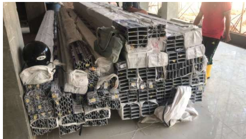
Gambar 3. 94 Aluminium (Sumber): Dokumentasi Lapangan 2023
