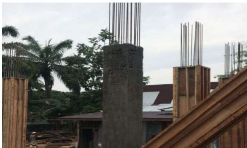
Gambar 3. 29 Pembukaan Bekisting Kolom (Sumber): Dokumentasi Lapangan, 2023
