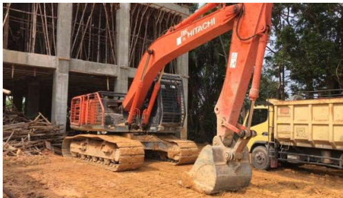
Gambar 3. 110 Excavator (Sumber): Dokumentasi Lapangan 2023
