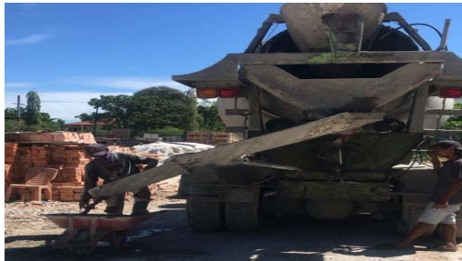
Gambar 3. 84 Beton Ready Mix (Sumber): Dokumentasi Lapangan 2023
