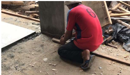
Gambar 3. 69 Pemasangan Benang Acuan (Sumber): Dokumentasi Lapangan 2023
