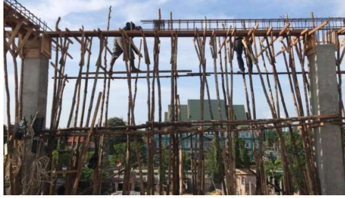
Gambar 3.42 Pemasangan Perancah Reng Balok (Sumber): Dokumentasi Lapangan 2023
