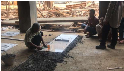
Gambar 3. 70 Pemasangan Granite (Sumber): Dokumentasi Lapangan 2023
