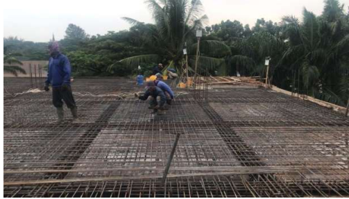
Gambar 3. 39 Pembesian (Sumber): Dokumentasi Lapangan 2023
