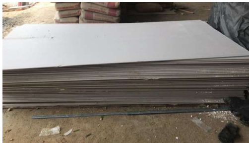
Gambar 3. 92 Gypsum Board (Sumber): Dokumentasi Lapangan 2023
