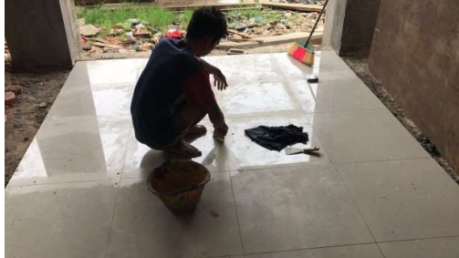
Gambar 3. 71 Pemberian Tite Grout Pada Celah Granite (Sumber): Dokumentasi Lapangan 2023
