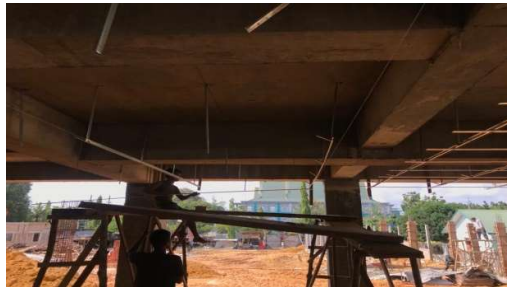
Gambar 3. 61 Pemasangan Rangka Plafond (Sumber): Dokumentasi Lapangan 2023
