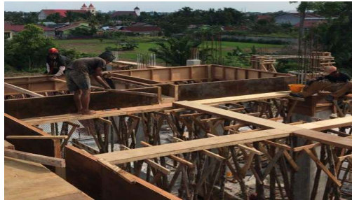
Gambar 3. 32 Pemasangan Bekisting Balok Lantai (Sumber): Dokumentasi Lapangan 2023
