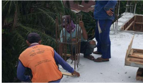
Gambar 3. 25 Menentukan As Kolom (Sumber): Dokumentasi lapangan 2023
