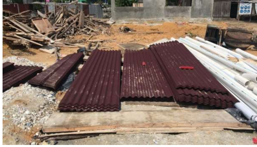
Gambar 3. 103 Atap Long Span (Sumber): Dokumentasi Lapangan 2023
