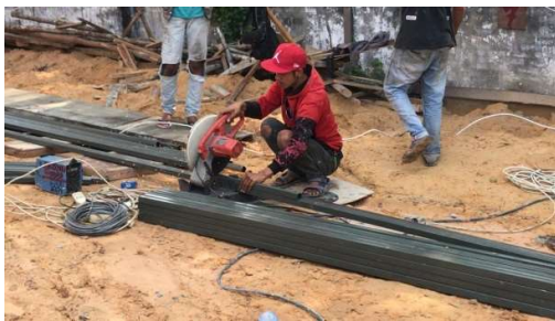
Gambar 3. 72 Proses Pembuatan Rangka Acp (Sumber): Dokumentasi Lapangan 2023
