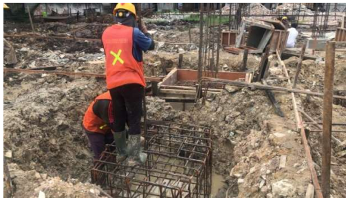
Gambar 3. 19 Pemasangan Tulangan Pile cap dan Kolom Pedestal (Sumber): Dokumentasi Lapangan, 2023
