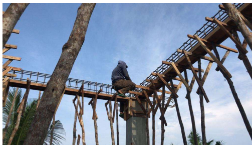
Gambar 3. 43 Pemasangan Tulangan Reng Balok (Sumber): Dokumentasi lapangan 2023
