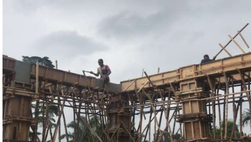
Gambar 3. 45 Pelepasan Bekisting Reng Balok (Sumber): Dokumentasi lapangan 2023
