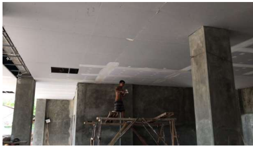
Gambar 3. 63 Pendempulan Sambungan Plafond Gypsum (Sumber): Dokumentasi Lapangan 2023
