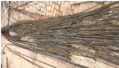
Gambar 3. 88 Besi Tulangan (Sumber): Dokumentasi Lapangan 2023
