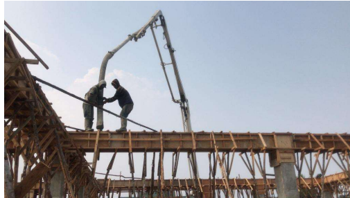
Gambar 3. 44 Pengecoran Reng Balok (Sumber): Dokumentasi lapangan 2023
