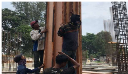
Gambar 3. 27 Pemasangan Bekisting Kolom (Sumber): Dokumentasi Lapangan 2023
