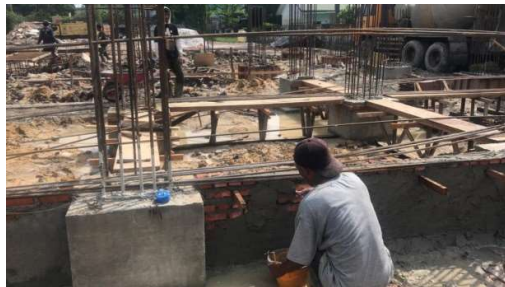
Gambar 3. 18 Pelesteran Rollag (Sumber): Dokumentasi Lapangan 2023
