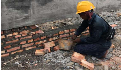
Gambar 3. 17 Pemasangan Batu Rollag (Sumber): Dokumentasi lapangan 2023
