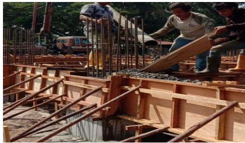
Gambar 3. 21 Pengecoran Kolom Pedestal Dan Balok Sloof (Sumber): Dokumentasi lapangan 2023
