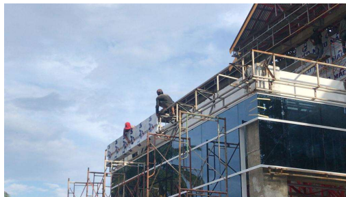
Gambar 3. 75 Proses Pemasangan Acp (Sumber): Dokumentasi Lapangan 2023
