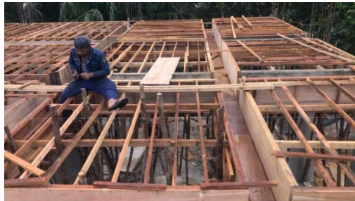
Gambar 3. 38 Pemasangan Gelagar Untuk Bekisting
