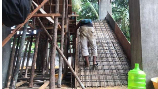
Gambar 3. 50 Pekerja Melakukan Perakitan Tulangan Tangga (Sumber): Dokumentasi Lapangan 2023
