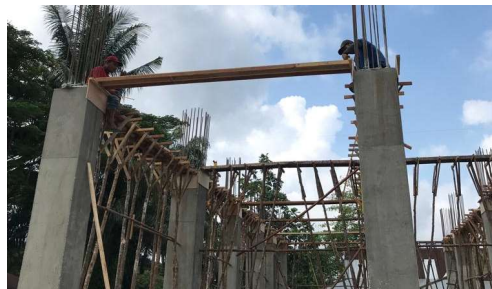
Gambar 3. 31 Pemasangan Perancah (Sumber): Dokumentasi Lapangan 2023
