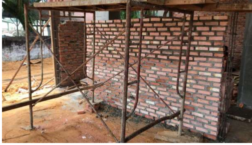
Gambar 3. 113 Scaffolding (Sumber): Dokumentasi Lapangan 2023
