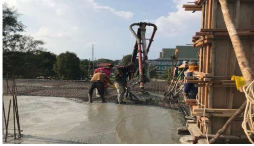
Gambar 3. 40 Pengecora menggunakan Pump Concrete (Sumber): Dokumentasi lapangan, 2023
