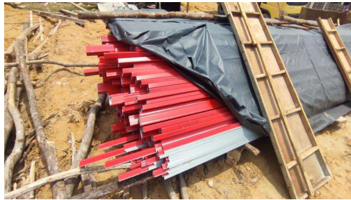
Gambar 3. 104 Baja Ringan (Sumber): Dokumentasi Lapangan 2023
