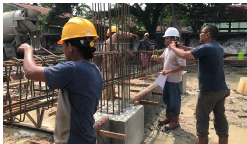
Gambar 3. 22 Penulangan Balok Sloof (Sumber): Dokumentasi lapangan 2023
