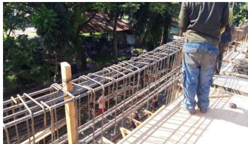
Gambar 3. 33 Penulangan Balok Lantai (Sumber): Dokumentasi Lapangan, 2023
