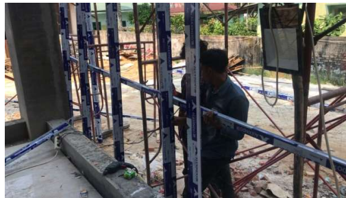
Gambar 3. 80 Pemasangan Transom (Sumber): Dokumentasi Lapangan 2023
