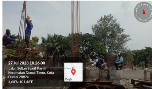
Gambar 3. 26 Penulangan Kolom (Sumber): Dokumentasi lapangan 2023
