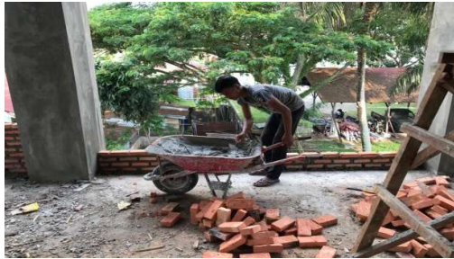
Gambar 3. 53 Pemasangan Setengah Bata (Sumber): Dokumentasi Lapangan 2023
