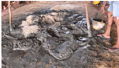
Gambar 3. 16 Adukan Spesi Pasangan Bata (Sumber): Dokumentasi Lapangan 2023
