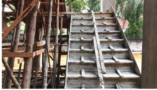
Gambar 3. 51 Hasil Setelah Pengecoran Tangga (Sumber): Dokumentasi Lapangan 2023
