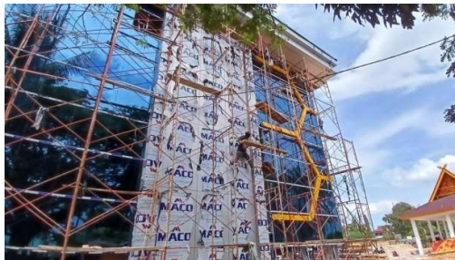
Gambar 3. 76 Finishing Acp (Sumber): Dokumentasi Lapangan 2023
