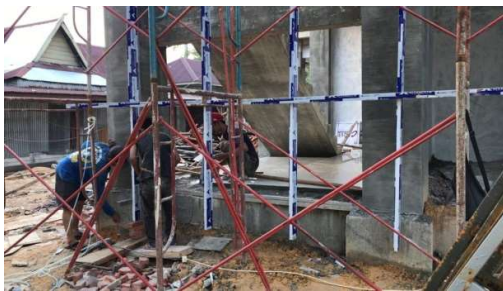
Gambar 3. 78 Pemasangan Bracket (Sumber): Dokumentasi Lapangan 2023
