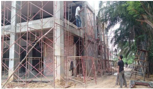
Gambar 3. 73 Pemasangan Scaffolding (Sumber): Dokumentasi Lapangan 2023
