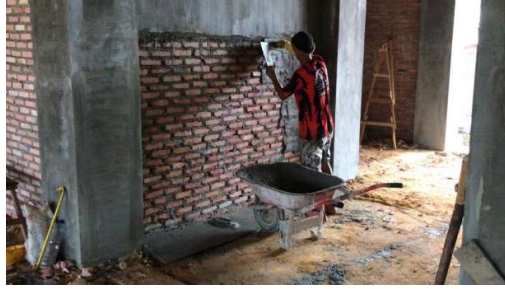
Gambar 3. 54 Pekerjaan Pelasteran Dinding Bata (Sumber): Dokumentasi Lapangan 2023
