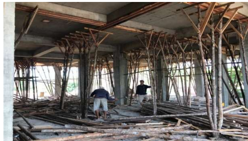
Gambar 3. 35 Pembukaan Bekisting Balok Lantai (Sumber): Dokumentasi Lapangan 2023
