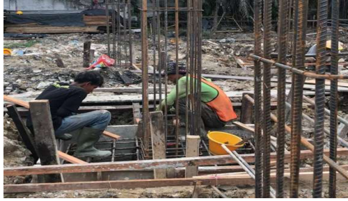
Gambar 3. 13 Pemasangan Bekisting Pile Cap (Sumber): Dokumentasi lapangan 2023
