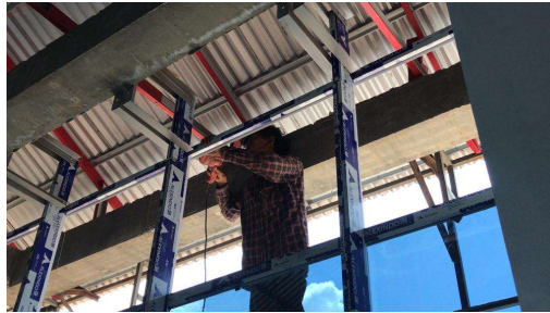
Gambar 3. 79 Pemasangan Mullion (Sumber): Dokumentasi Lapangan 2023
