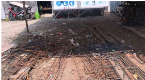
Gambar 3. 12 Lokasi Pabrikasi Tulangan Pile Cap (Sumber): Dokumentasi lapangan 2023
