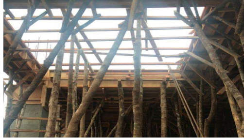
Gambar 3. 37 Pemasangan Perancah
