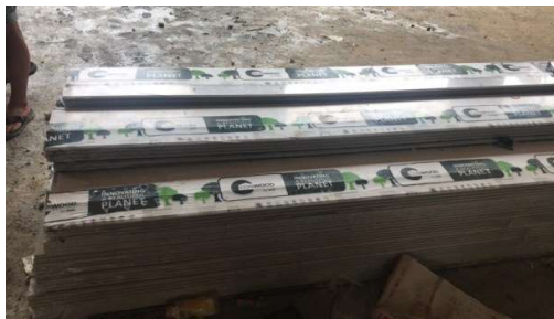
Gambar 3. 102 Lisplank Grc (Sumber): Dokumentasi Lapangan 2023
