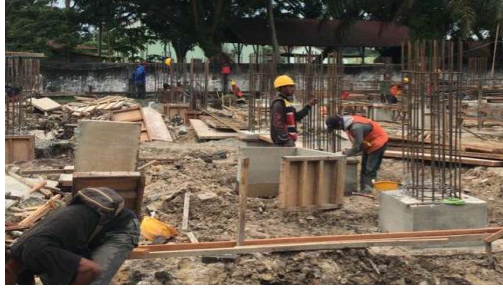
Gambar 3. 15 Pembukaan Bekisting Pile Cap (Sumber): Dokumentasi Lapangan 2023
