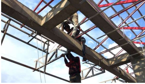
Gambar 3. 74 Pemasangan Baut Penghubung Rangka Acp (Sumber): Dokumentasi Lapangan 2023
