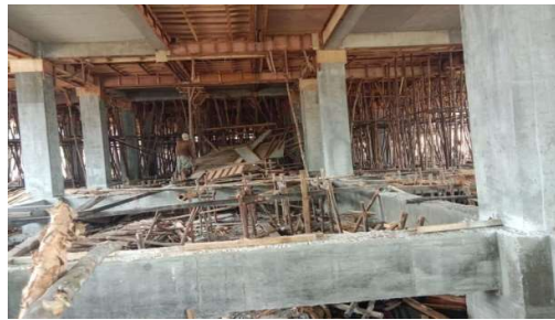
Gambar 3. 41 Pembongkaran Bekisting Pelat Lantai (Sumber): Dokumentasi Lapangan 2023
