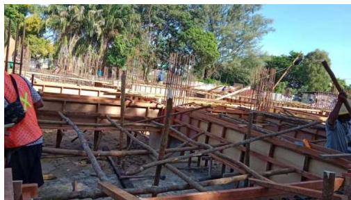
Gambar 3. 23 Pemasangan Bekisting Sloof (Sumber): Dokumentasi lapangan 2023
