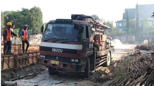
Gambar 3. 119 Pump Concrete (Sumber): Dokumentasi Lapangan 2023
