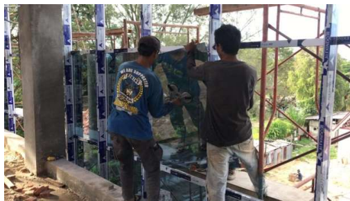
Gambar 3. 81 Pemasangan Kaca (Sumber): Dokumentasi Lapangan 2023
