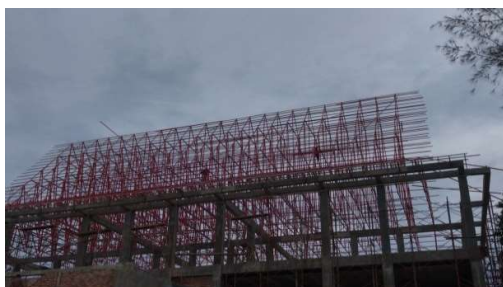
Gambar 3. 60 Finishing Pemasangan Reng Atap (Sumber): Dokumentasi Lapangan 2023
