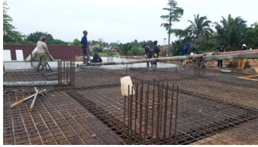
Gambar 3. 34 Pengecoran Balok Disertai Pengecoran Pelat (Sumber): Dokumentasi Lapangan, 2023
