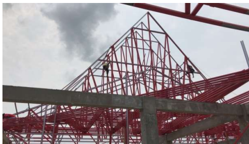
Gambar 3. 59 Pemasangan Kuda-Kuda (Sumber): Dokumentasi Lapangan 2023
