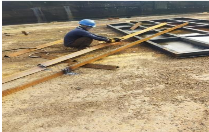
Gambar 2.6 Proses Pemotongan Plat Siku menggunakan blender
