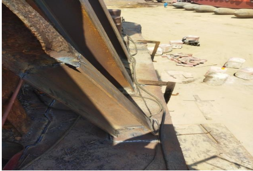
Gambar 2.22 Pengukuran plat H beam pada tongkang Stella Maris 501
