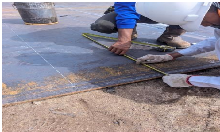
Gambar 2.3 Proses Marking Tongkang Bangunan Baru
