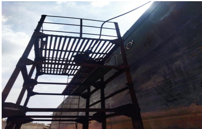
Gambar 2.19 proses replating pada tongkang OB PMT IV 110
