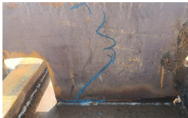
Gambar 2. 52 Pengelasan yang harus ditambah
