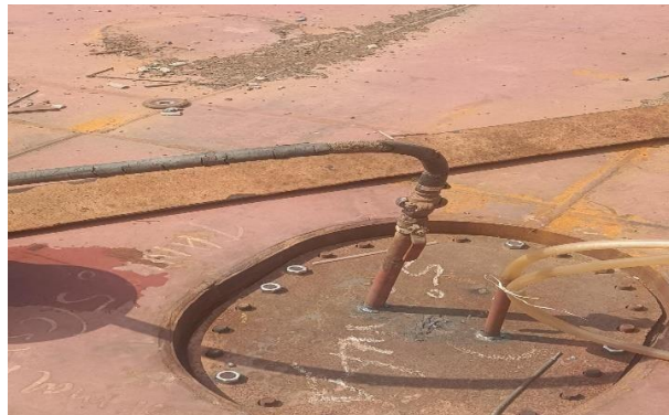
Gambar 3.11 selang dari compressor koneksi pada flens pipa
