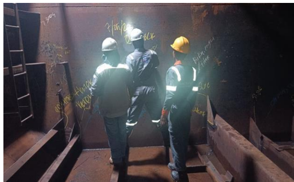
Gambar 2. 4 Inspect welding pada tangki kapal tongkang
