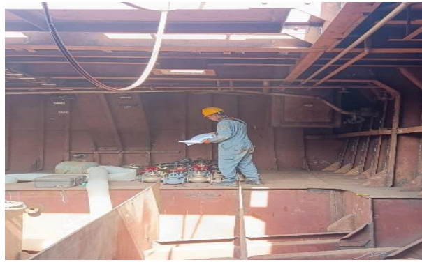
Gambar 2. 8 Pengecekan Bagian Tangki Pada Kapal Tugboat
