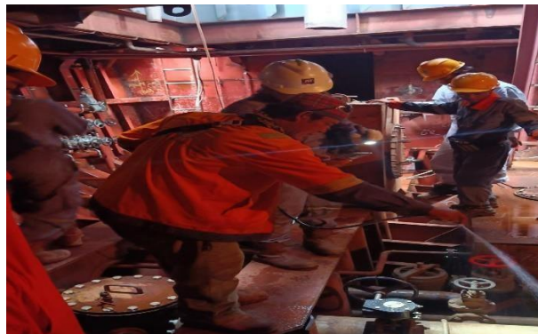
Gambar 2. 23 pengecekan kebocoran pada pipa
