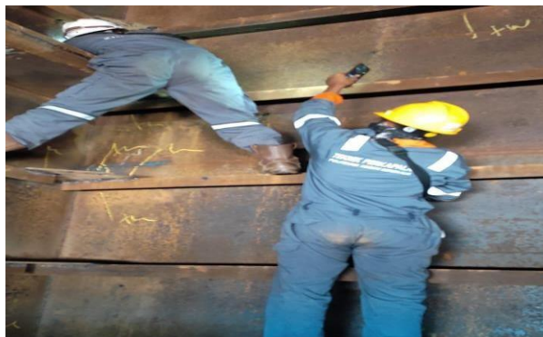
Gambar 2. 9 Inspect welding di tangki kapal Tongkang
