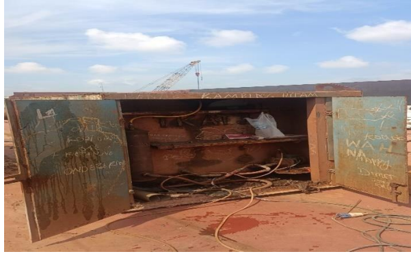
Gambar 3.4 Mesin pompa air dan tabung air
