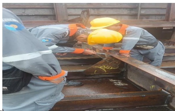
Gambar 2.21 Proses inspec welding pada bagian side shell
