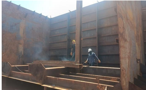
Gambar 2.59 Proses pemasangan stensen
