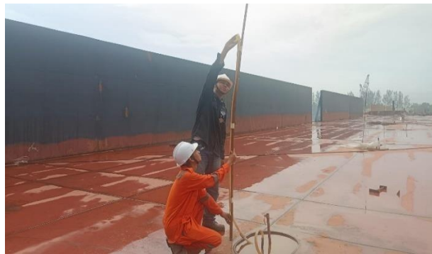
Gambar 3.13 Proses pengukuran air didalam selang
