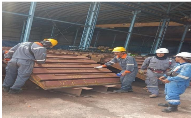
Gambar 2. 27 inspect welding terhadap ramp door
