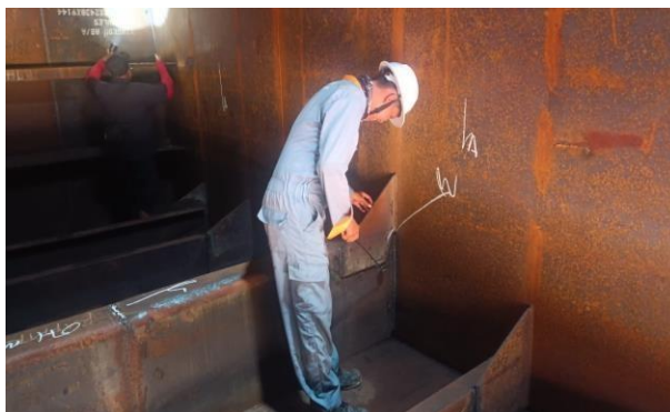
Gambar 2. 58 Inspect welding terhadap tangki
