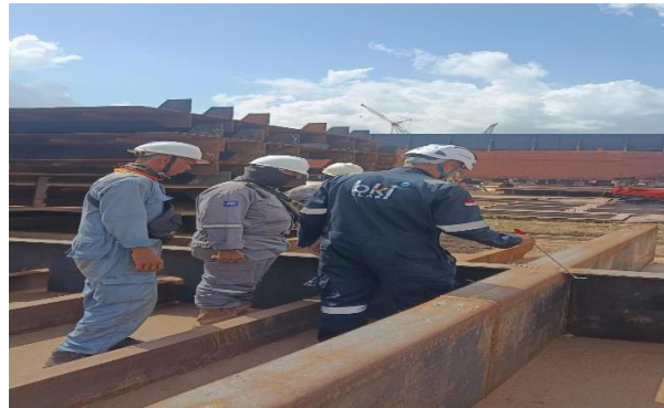
Gambar 2. 42 Inspect welding pada bagian main deck
