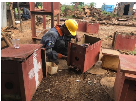
Gambar 2 10 Proses mengerinda bagian pada mesin trafo
