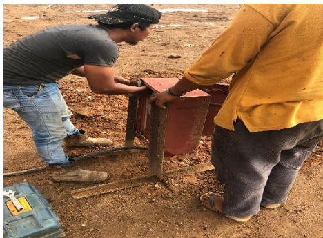
Gambar 2 37 Proses memperbaiki mesin trafo
