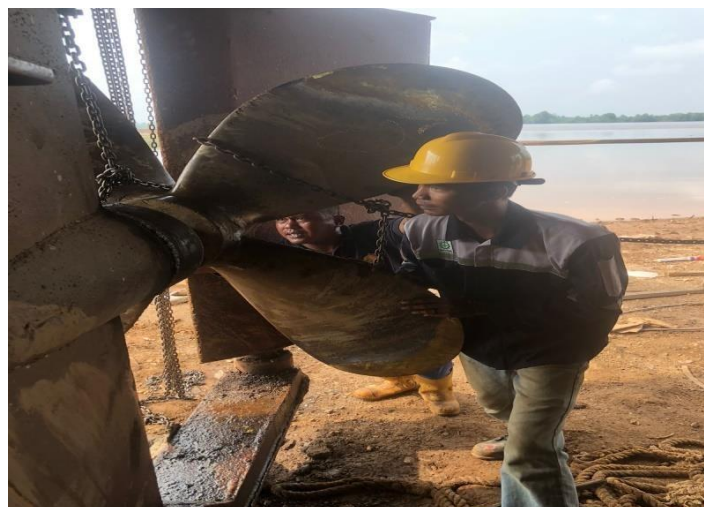
Gambar 3, 5 Proses pemasangan Propeller
