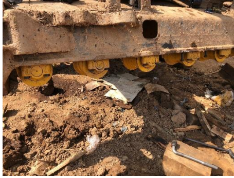
Gambar 2 34 Bagian excavator yang di perbaiki
