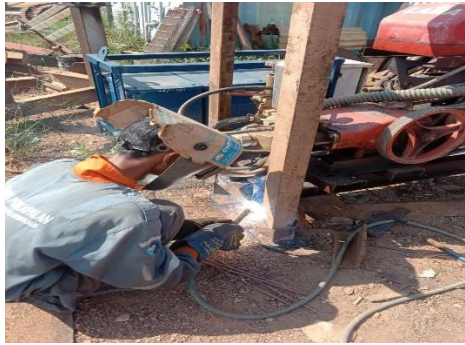
Gambar 2 21 Proses mengelas bagian pada mesin las
