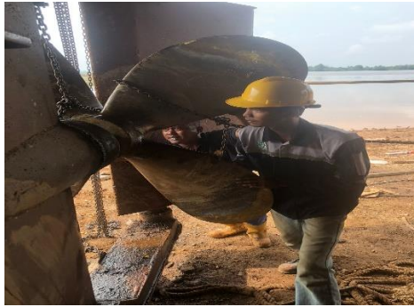
Gambar 2 28 Proses pemasangan propeller
