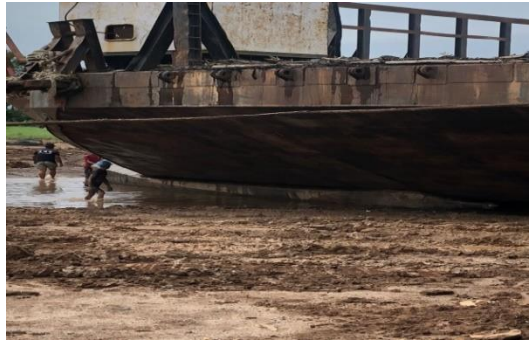
Gambar 2 1 Proses pemasangan airbag
