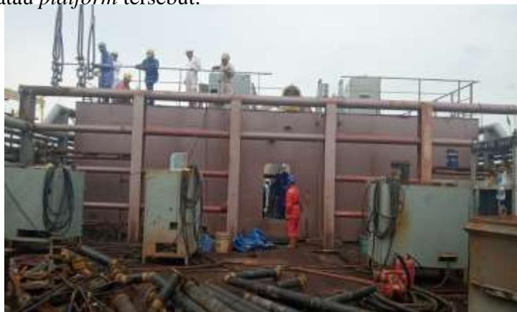
**Gambar 2.27 proses pemasangan railing**
