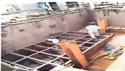
Gambar 1.3 proses fabrikasi pada tangki kapal AHTS
