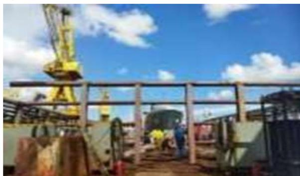
**Gambar2.20 pemasangan *Safety Rail***
