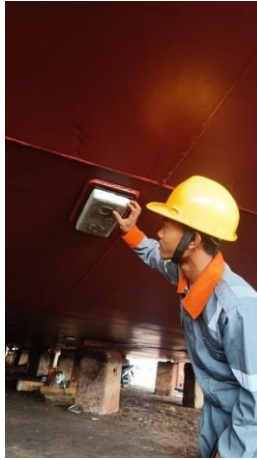
Gambar 2. 9 Pengecekan pemasangan zinc anode di kapal Crane Barge
