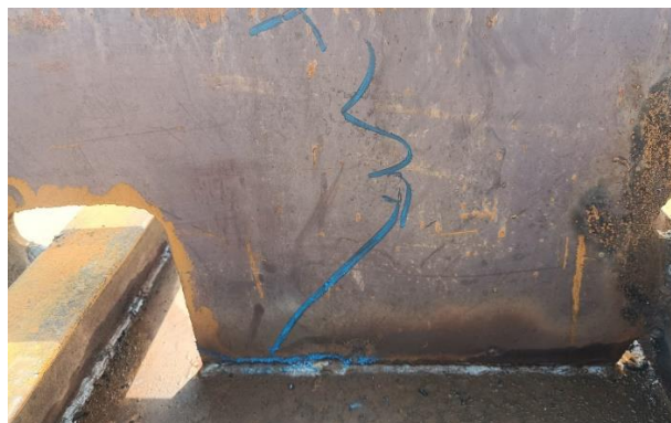
Gambar 2. 47 Pengelasan yang harus ditambah.
