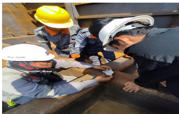
Gambar 2. 37 Belajar menggunakan Welding Gauge.
