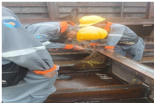
Gambar 2. 21 Proses inspec welding pada bagian side shell.
