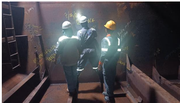
Gambar 2. 4 Inspect welding pada tangki void
