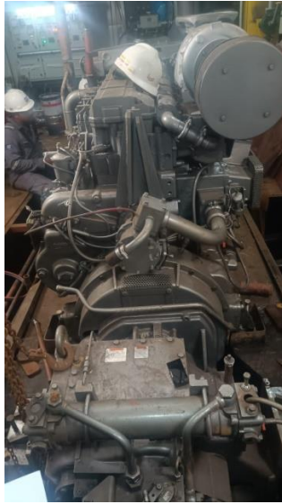
Gambar 2. 12 Pemasangan engine Mitsubishi di kapal TugBoat
