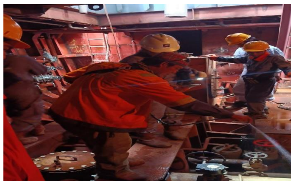
Gambar 2. 23 pengetesan kebocoran pada pipa
