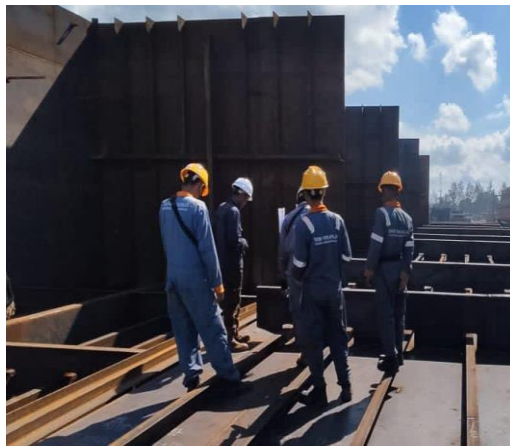
Gambar 2. 15 inspect welding bagian longitudinal bulkhed dan bottom di kapal Tongkang.
