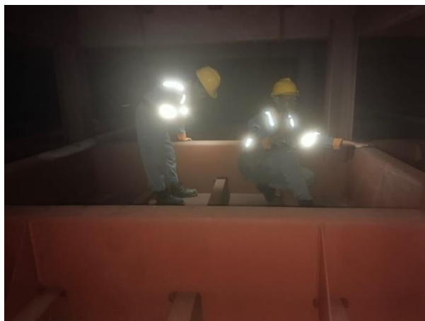
Gambar 2. 3 Proses pemeriksaan kebocoran pada tangki water tank dan double bottom
