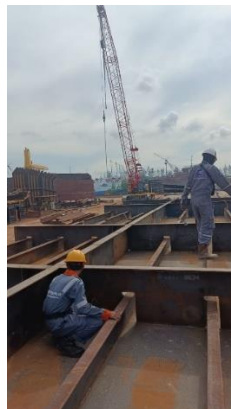
Gambar 2. 2 inspect welding terhadap double bottom dan main deck kapal tongkang.
