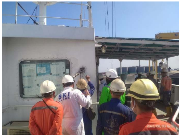
Gambar 2.28 Pengecekan Selang Pendingin Ruangan / AC
