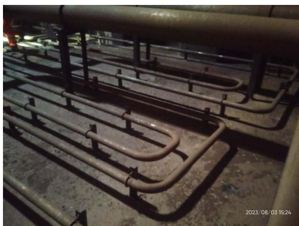
Gambar 2.26 Alat Pemanas Pada Tangki COT
