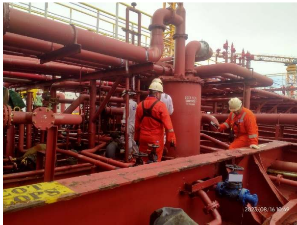
Pemeriksaan pada pipa pipa ruang muat sekaligus valve valve nya
