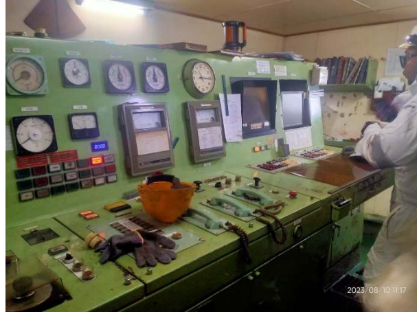
Gambar 2.44 Pemeriksaan Engine Control room
