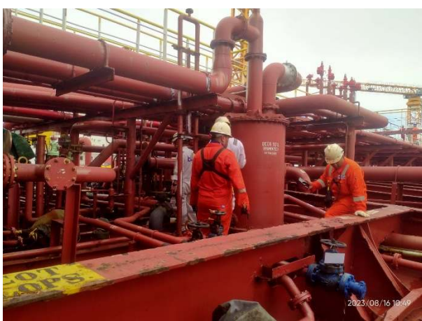
Gambar 2.50 Pemeriksaan Pada Pipa Pipa Dan Valve
