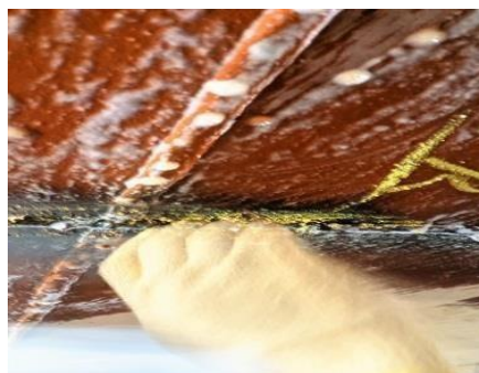
Gambar 1. 22 marker kebocoran pada bottom
