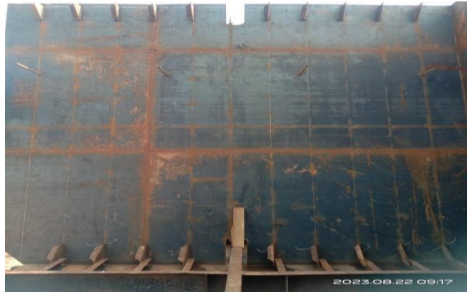
Gambar 1. 59 balikan trans bulkhead frame 6
