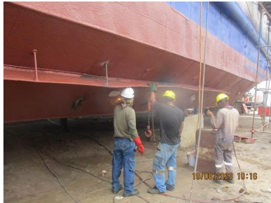
GAMBAR 2. 26 pemasangan zinc anode
