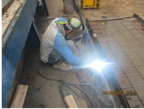
GAMBAR 2. 38 welding kupingan dapra
