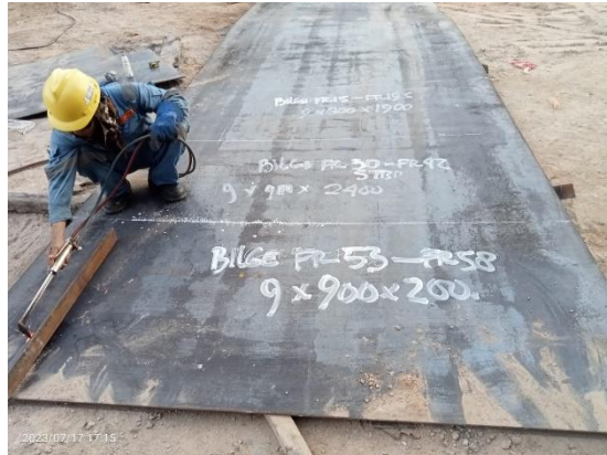
GAMBAR 2. 8 ukuran plat yang akan di fit up
