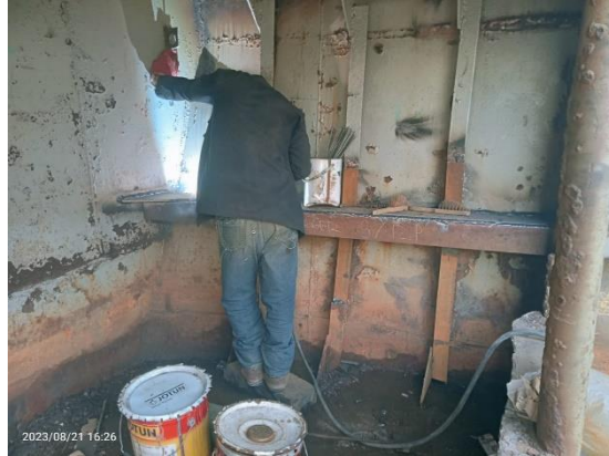
GAMBAR 2. 20 pemasangan stinger.
