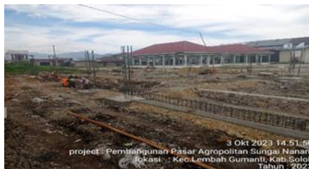
Gambar 3. 23 pekerjaan pembesian sloof (Sumber : Dokumen proyek 2023)
