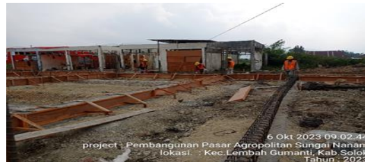
Gambar 3. 25 Pekerjaan pengecoran (Sumber : Dokumen proyek 2023)
