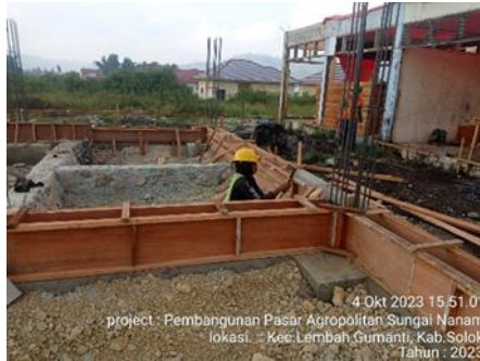
Gambar 3. 24 Pekerjaan bekisting (Sumber : Dokumen proyek 2023)
