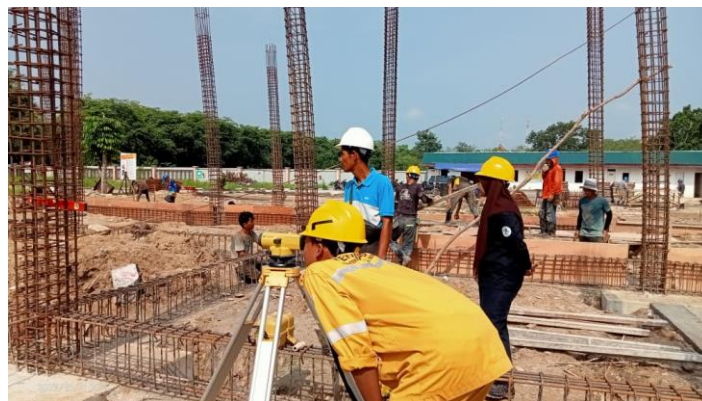
Gambar 3. 20 Pengukuran elavasi
