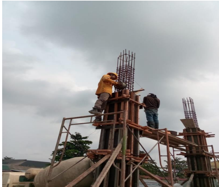
Gambar 3. 26 Pengecoran kolom
