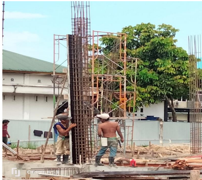
Gambar 3. 25 Pemasangan bekisting kolom
