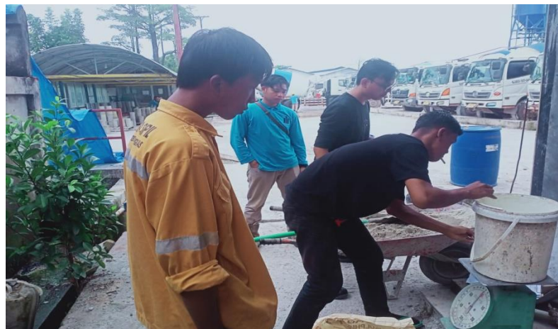
Gambar 3. 2 Pekerjaan trial mix
