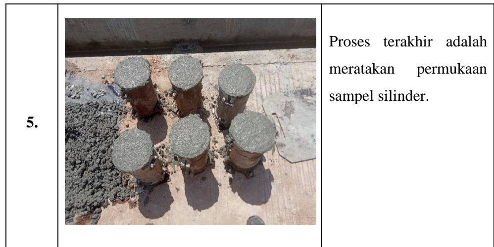
Gambar 3. 17 Pekerjaan slump test dan pembuatan sampel dilapangan
