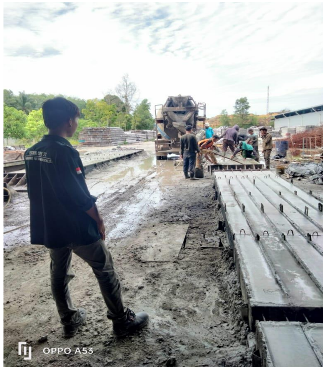
Gambar 3. 11 Pengecoran tiang pancang precast
