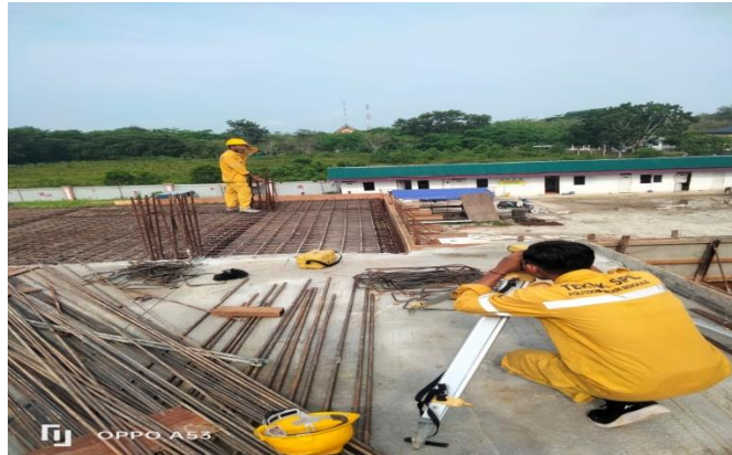
Gambar 3. 21 Pengukuran lantai 2
