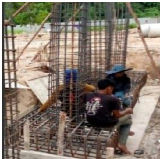
Gambar 3. 18 Pemasangan pile cap
