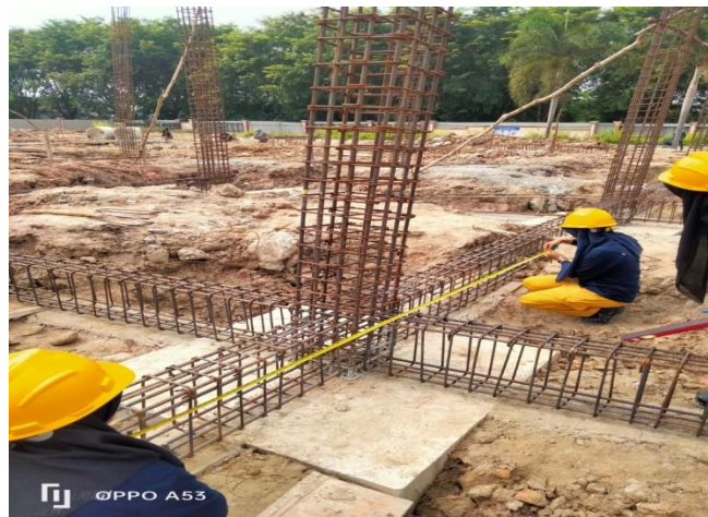
Gambar 3. 22 Pengukuran tumpuan
