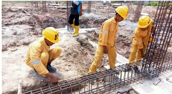
Gambar 3. 19 Pengukuran tulangan extra tumpuan dan lapangan
