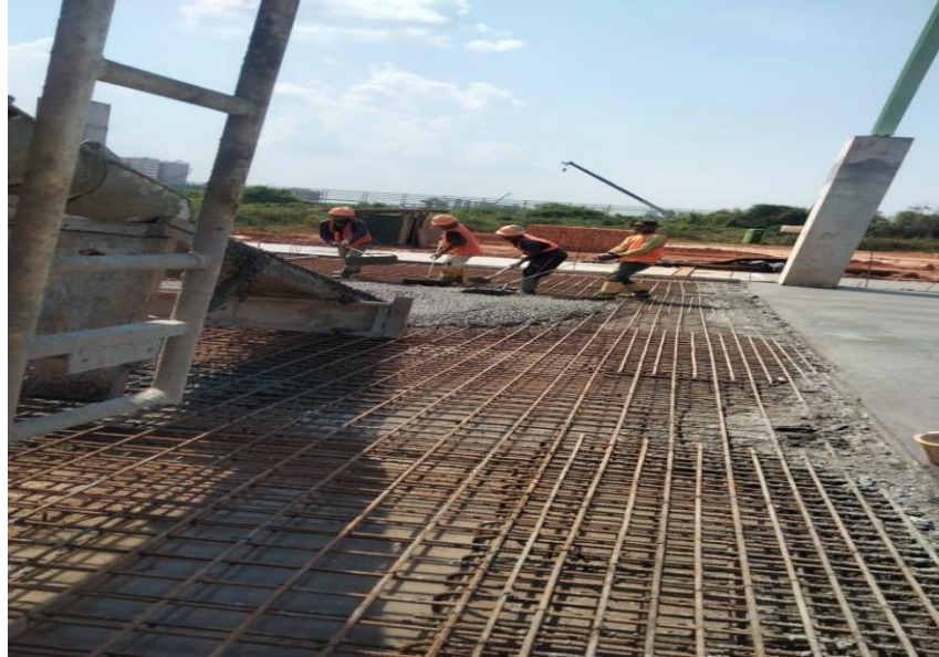
Gambar 3. 7 Cor lantai kerja
