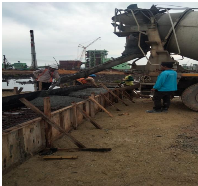
Gambar 3. 10 Pengecoran drainase
