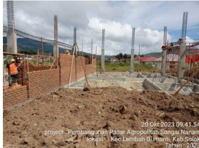
Gambar 3. 28 Pekerjaan Urugan Tanah (Sumber : Dokumentasi Pribadi, 2023 )
