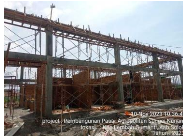
Gambar 3. 26 Pengecoran Balok B1 (Sumber : Dokumentasi Pribadi, 2023 )
