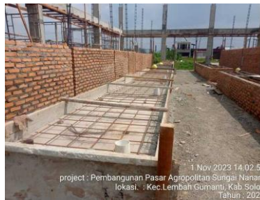
Gambar 3. 30 Pekerjaan Meja Beton (Sumber : Dokumentasi Pribadi , 2023)
