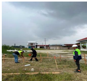
Gambar 3. 7 Pemasangan Bouwplank (Sumber : Dokumentasi Pribadi, 2023 )
