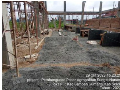
Gambar 3. 29 Pekerjaan Urugan Pasir (Sumber : Dokumentasi Pribadi, 2023 )
