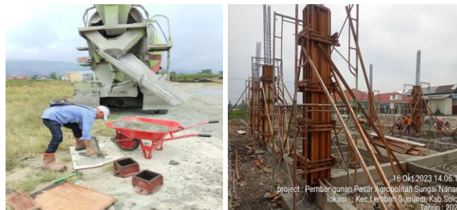
Gambar 3. 19 Pekerjaan kolom K1 (Sumber : Dokumentasi Pribadi, 2023)
