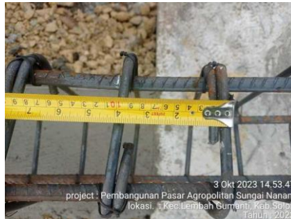
Gambar 3. 21 Pembesian Sloof (Sumber : Dokumentasi Pribadi, 2023 )
