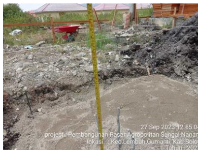
Gambar 3. 10 Pekerjaan Lantai Kerja (Sumber : Dokumentasi Pribadi , 2023)
