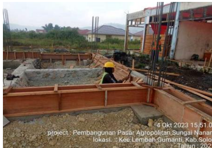
Gambar 3. 22 Pembuatan Bekisting Sloof (Sumber : Dokumentasi Pribadi, 2023 )
