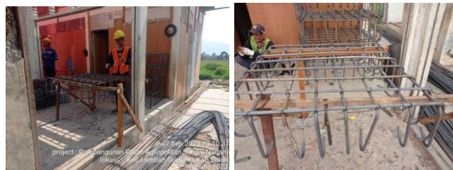
Gambar 3. 16 Pembesian Pondasi Poer (Sumber : Dokumentasi Pribadi, 2023 )
