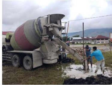
Gambar 3. 15 Pengecoran Bore Pile (Sumber : Dokumentasi Pribadi, 2023 )
