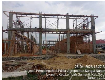
Gambar 3. 25 Pembuatan Bekisting Balok B1 (Sumber : Dokumentasi Pribadi, 2023 )
