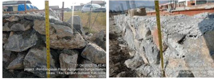
Gambar 3. 12 Pasangan Batu Kali (Sumber : Dokumentasi Pribadi , 2023)
