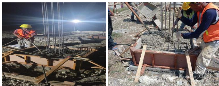
Gambar 3. 18 Pengecoran Pondasi Poer (Sumber : Dokumentasi Pribadi, 2023)
