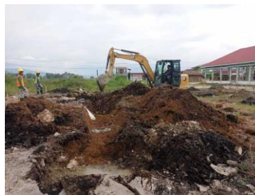
Gambar 3. 9 Penggalian Tanah (Sumber : Dokumentasi Pribadi, 2023 )
