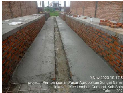
Gambar 3. 31 Pengecoran lantai (Sumber : Dokumentasi Pribadi, 2023 )
