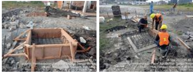
Gambar 3. 17 Pembuatan Bekisting (Sumber : Dokumentasi Pribadi, 2023)
