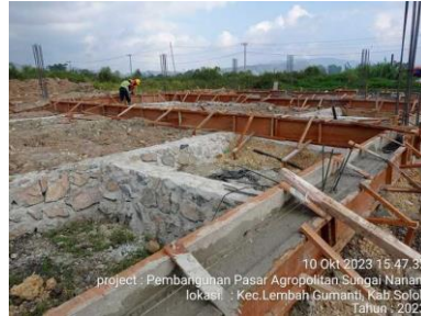
Gambar 3. 23 Pengecoran sloof (Sumber : Dokumentasi Pribadi , 2023)
