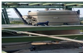
Gambar 3. 26 pengelasan plat ceker pada beam (Sumber : Dokumantasi Proyek, 2023)
