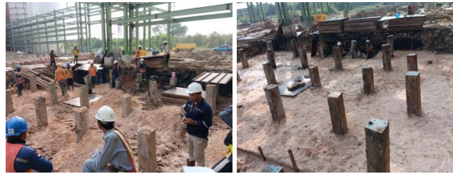
Gambar 3. 37 pekerjaan pasir urug (Sumber : Dokumantasi Proyek, 2023)
