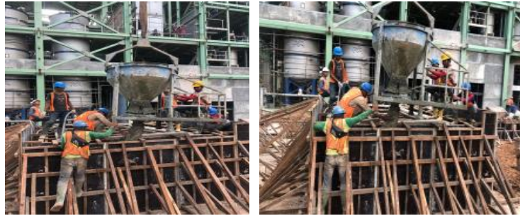
Gambar 3. 53 pekerjaan pengecoran dinding (Sumber : Dokumantasi Proyek, 2023)
