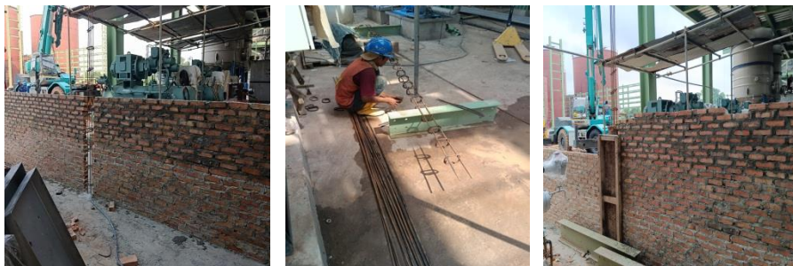
Gambar 3. 19 pekerjaan pemasangan kolom praktis (Sumber : Dokumantasi Proyek, 2023)
