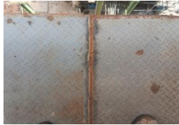
Gambar 3. 27 pengelasan plat ceker pada beam (Sumber : Dokumantasi Proyek, 2023)
