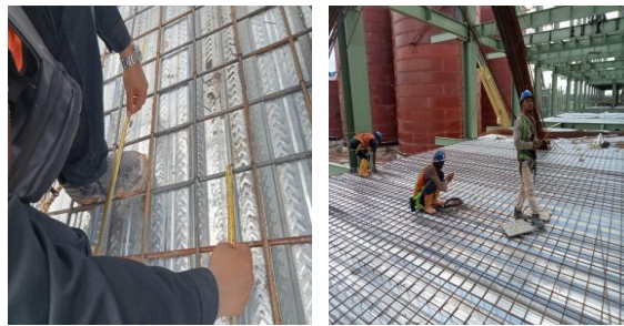
Gambar 3. 12 pekerjaan perakitan tulangan plat lantai (Sumber : Dokumantasi Proyek, 2023)
