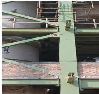
Gambar 3. 30 salam bresing (Sumber : Dokumantasi Proyek, 2023)
