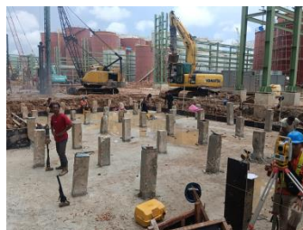
Gambar 3. 39 pekerjaan pemotongan sisa tiang pancang (Sumber : Dokumantasi Proyek, 2023)
