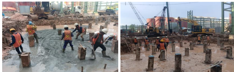
Gambar 3. 38 pekerjaan pengecoran LC ( Lean Concrete ) (Sumber : Dokumantasi Proyek, 2023)
