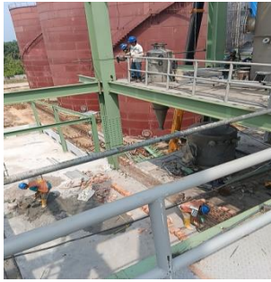
Gambar 3. 33 memastikan kesejajaran handril (Sumber : Dokumantasi Proyek, 2023)
