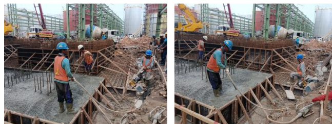
Gambar 3. 49 vibrator (Sumber : Dokumantasi Proyek, 2023)
