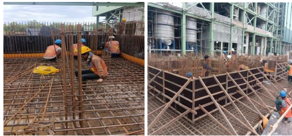
Gambar 3. 45 pekerjaan perakitan tulangan kolom (Sumber : Dokumentasi Proyek, 2023)
