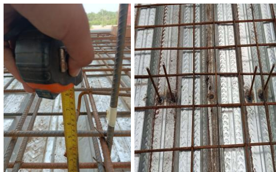
Gambar 3. 15 pekerjaan pemasangan shear connector (Sumber : Dokumantasi Proyek, 2023)
