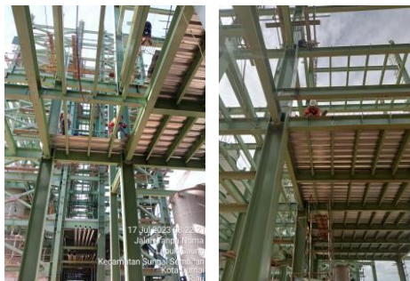
Gambar 3. 11 pekerjaan pemasangan bondex (Sumber : Dokumantasi Proyek, 2023)
