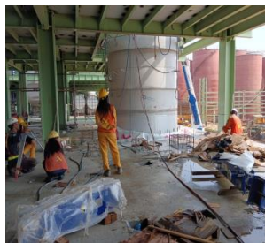
Gambar 3. 23 pekerjaan penentuan top cor oleh surveyor (Sumber : Dokumantasi Proyek, 2023)
