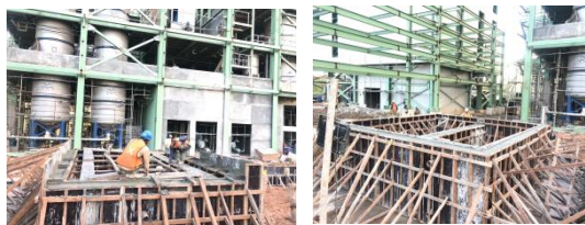
Gambar 3. 55 pekerjaan meratakan cor-an (Sumber : Dokumantasi Proyek, 2023)
