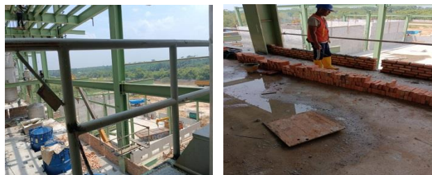
Gambar 3. 18 pekerjaan pasangan bata (Sumber : Dokumantasi Proyek, 2023)
