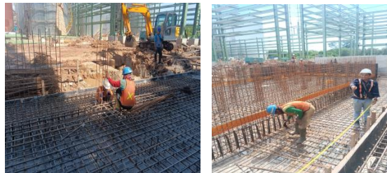
Gambar 3. 43 pekerjaan perakitan tulangan dinding (Sumber : Dokumantasi Proyek, 2023)
