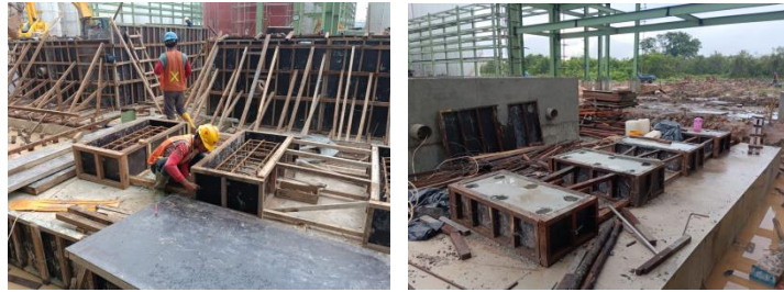
Gambar 3. 24 pekerjaan pengecoran pondasi equipment (Sumber : Dokumantasi Proyek, 2023)
