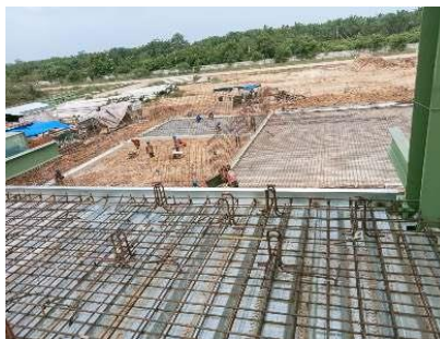
Gambar 3. 13 pekerjaan perakitan tulangan pondasi equipment (Sumber : Dokumantasi Proyek, 2023)
