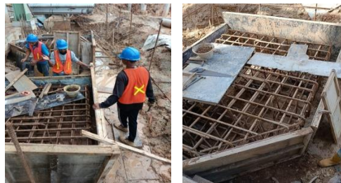
Gambar 3. 22 pekerjaan pemasangan beakisting (Sumber : Dokumantasi Proyek, 2023)
