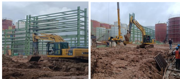
Gambar 3. 36 pekerjaan penggalian pondasi (Sumber : Dokumantasi Proyek, 2023)
