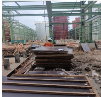
Gambar 3. 40 pekerjaan pemasangan beakisting (Sumber : Dokumantasi Proyek, 2023)
