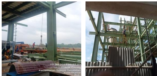
Gambar 3. 10 pekerjaan erection kolom beam (Sumber : Dokumantasi Proyek, 2023)
