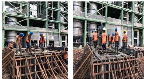
Gambar 3. 54 penggunaan vibrator (Sumber : Dokumantasi Proyek, 2023)
