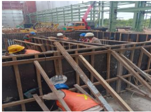
Gambar 3. 51 pekerjaan pemasangan beakisting kolom (Sumber : Dokumantasi Proyek, 2023)
