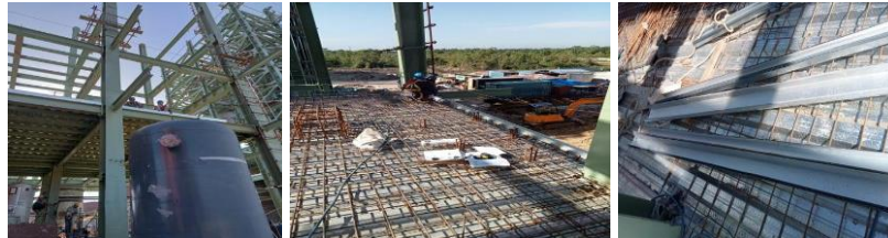
Gambar 3. 14 pekerjaan pemasangan endstop stopper bondek (Sumber : Dokumantasi Proyek, 2023)
