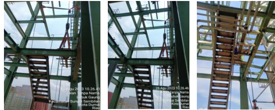
Gambar 3. 29 instal anak tangga (Sumber : Dokumantasi Proyek, 2023)
