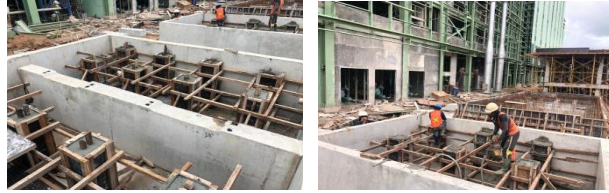
Gambar 3. 56 pekerjaan pengecor-an kolom (Sumber : Dokumantasi Proyek, 2023)
