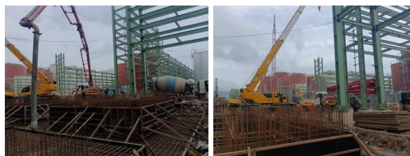
Gambar 3. 44 pekerjaan pemasangan beakisting dinding (Sumber : Dokumantasi Proyek, 2023)
