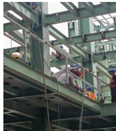
Gambar 3. 34 pekerjaan penelasan kaki handril (Sumber : Dokumantasi Proyek, 2023)
