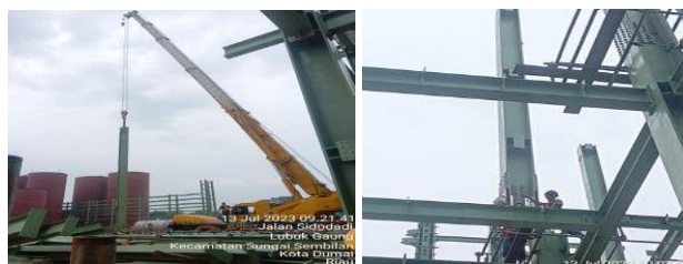
Gambar 3. 9 pekerjaan erection kolom beam (Sumber : Dokumantasi Proyek, 2023)
