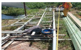
Gambar 3. 32 handril pada pabrikasi (Sumber : Dokumantasi Proyek, 2023)
