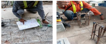
Gambar 3. 21 pekerjaan pekerjaan markingan beakisting (Sumber : Dokumantasi Proyek, 2023)
