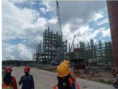
Gambar 3. 6 Inspeksi Area Proyek (Sumber : Dokumantasi Proyek, 2023)
