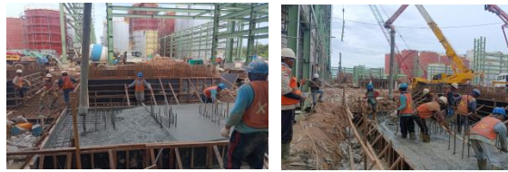
Gambar 3. 48 pekerjaan pengecoran plat lantai (Sumber : Dokumantasi Proyek, 2023)
