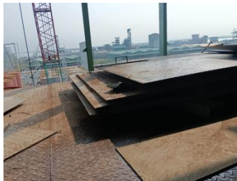
Gambar 3. 25 plat ceker (Sumber : Dokumantasi Proyek, 2023)
