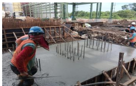
Gambar 3. 50 meratakan cor-an (Sumber : Dokumantasi Proyek, 2023)
