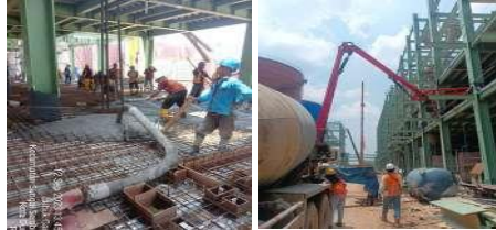
Gambar 3. 16 pekerjaan pengecoran plat lantai (Sumber : Dokumantasi Proyek, 2023)
