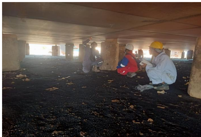
Gambar 2. 51 pengecekan under water yang disandblasting
