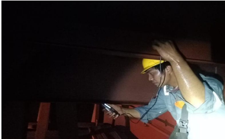
Gambar 2. 45 Mengecek Ketebalan cat pada tanki crane barge
