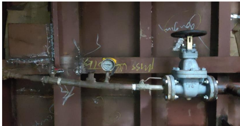
Gambar 2. 16 proses hydrottest pada pipa
