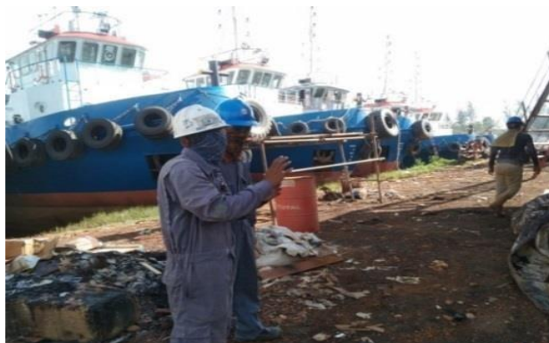
Gambar 2. 49 Membahas tentang proses pengerjaan blasting dan painting
