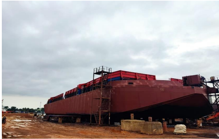
Gambar 2.49 Kapal di painting lapisan pertama
