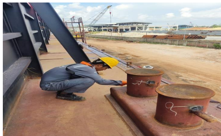
Gambar 2. 4 Inspect welding pada bollard
