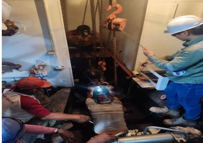
Gambar 2. 43 proses pemasangan copling
