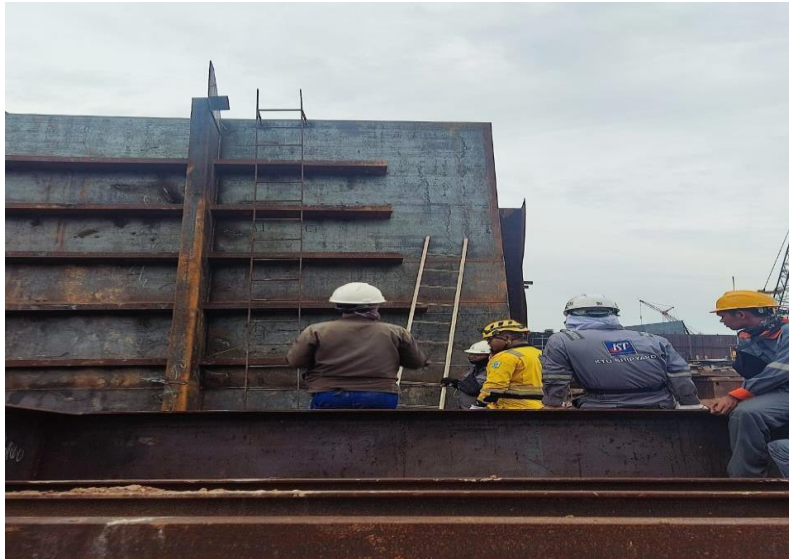
Gambar 2. 23 Proses inspect dan scarling Bersama owner
