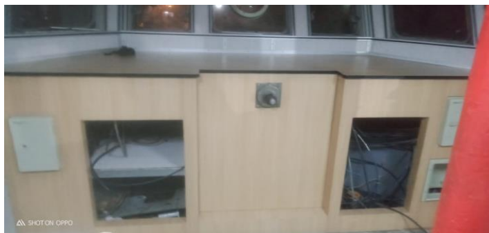
GAMBAR 2. 6 Pemasangan meja anjungan
