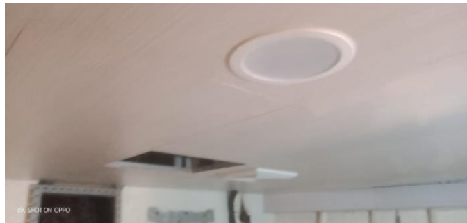
GAMBAR 2. 2 pemasangan bagian cheppenter
