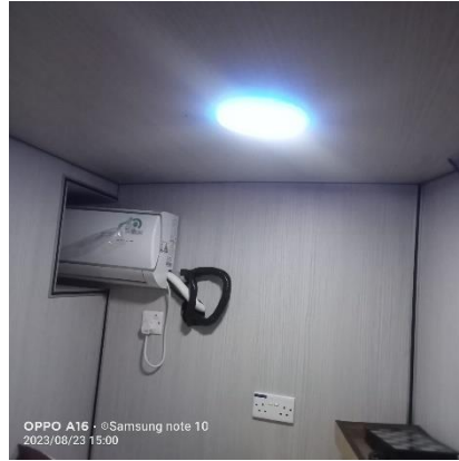
GAMBAR 2. 10 pemasangan chappenter ruangan kapten
