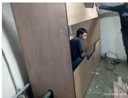
GAMBAR 2. 9 pemasangan tempat tidur abk
