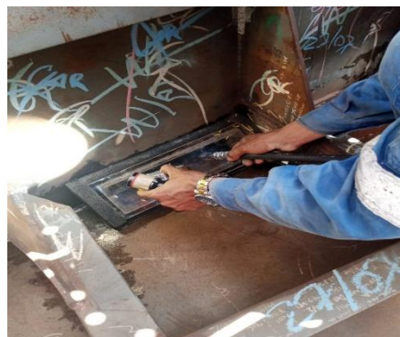
Gambar 2.37. vakun test di M01S
