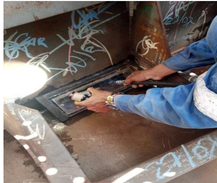
Gambar 2.36. vakum test pada M01S
