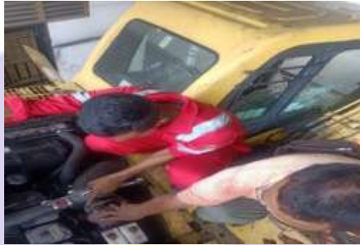
Gambar 4.1 melakukan pengecekan pada mesin excavator (sumber. Dokumentasi pribadi penulis,2020)
