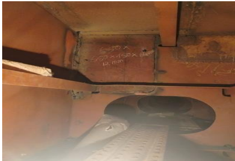
Gambar 2.24 Pengecekan Progress Kontruksi
