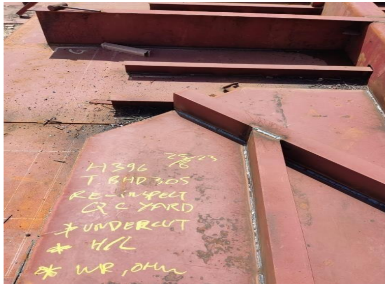
Gambar 2.31 Visual Test
