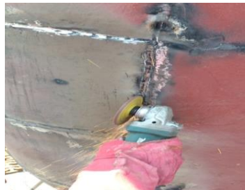
Gambar 3.7 Proses pembentukan bevel ulang Sumber: Dokumentasi
