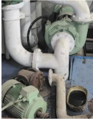
Gambar 3.10 Pompa Hisap Dan Buang Ballast
