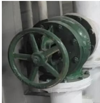
Gambar 3.9 Valve Hisap Dari Water Ballast Tank KM.Dharma Ferry II Sumber :Dokumentasi
