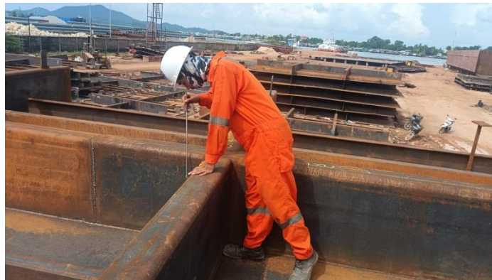
Gambar 2. 57 inspect welding pada panel main deck
