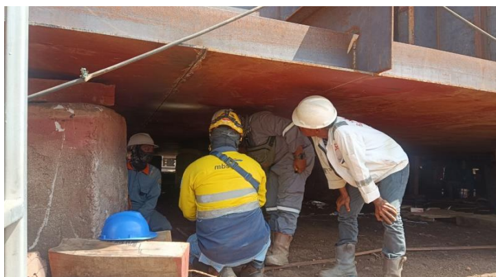
Gambar 2. 54 pengecekan gouging pada bottom
