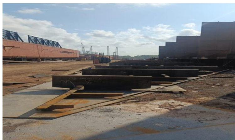
Gambar 2. 28 inspect welding pada bagian side shell
