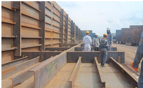
Gambar 2. 39 inspect welding pada Bottom
