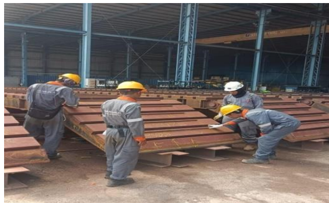
Gambar 2. 22 inspect welding pada ramp door
