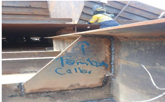
Gambar 2. 53 penambahan collar pada bracket
