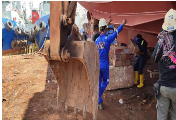
Gambar 3.6 proses pemasangan zinc anode
