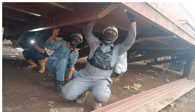
Gambar 2. 59 inspect welding pada bagian side board
