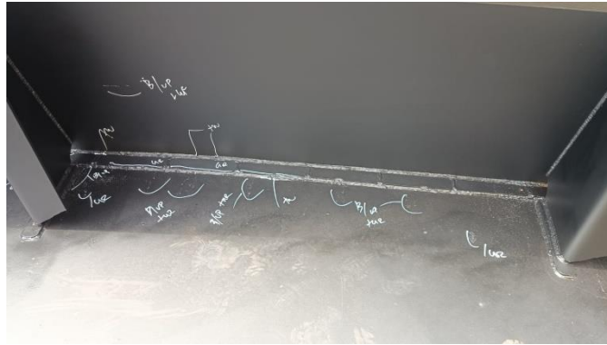
Gambar 2. 58 inspect welding pada bagian bulwark
