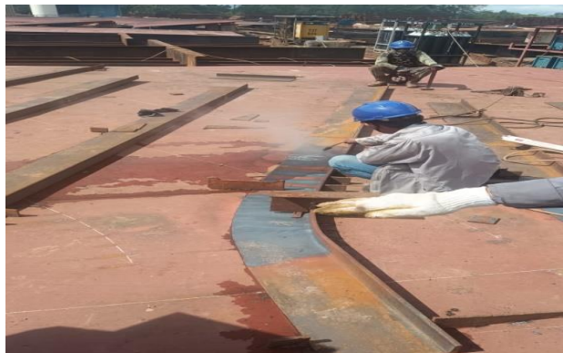
Gambar 2. 12 proses fairing pada plat
