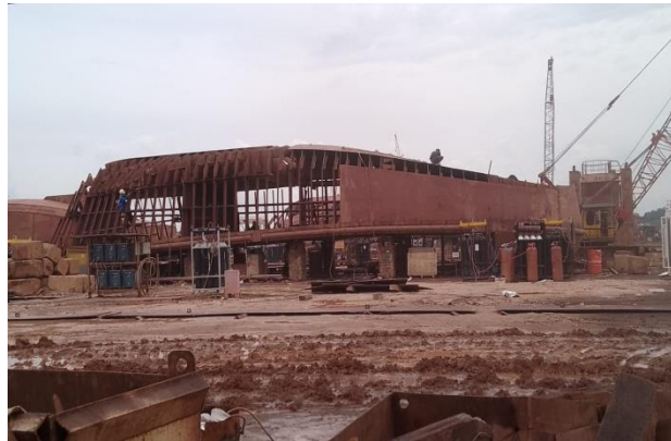
Gambar 2. 2 Proses bangunan baru Tug Boat
