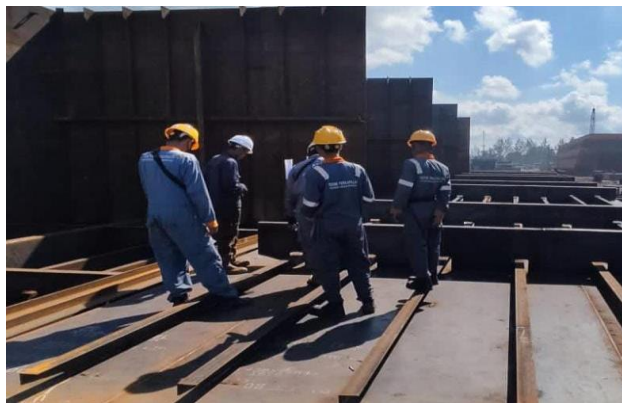
Gambar 2.13 Inspect welding terhadap longitudinal bulkhead dan Bottom .
