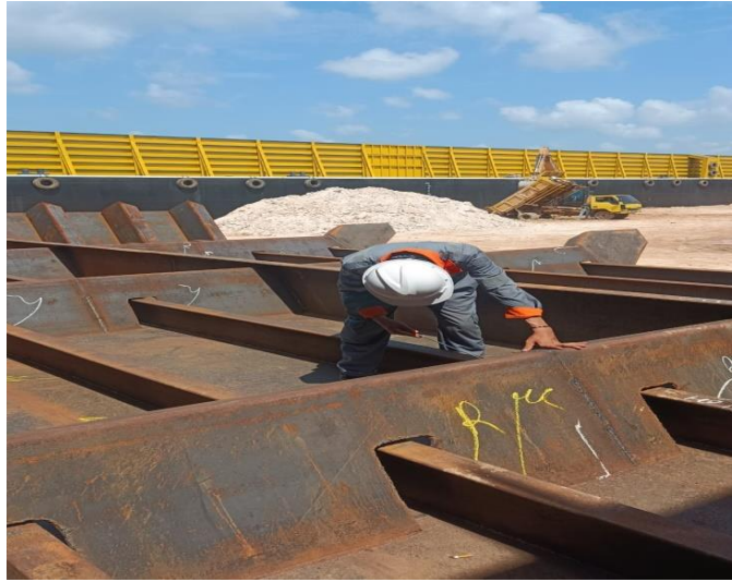
Gambar 2. 40 inspect welding pada bottom
