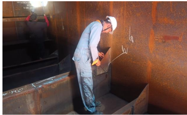
Gambar 2. 51 inspect welding pada tangki
