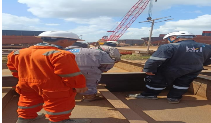
Gambar 2. 36 Inspect welding pada bagian main deck
