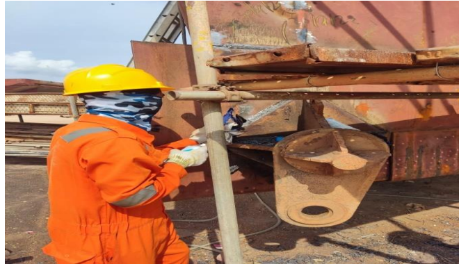
Gambar 2. 38 penetrant test pada bagian kupingan Head Block
