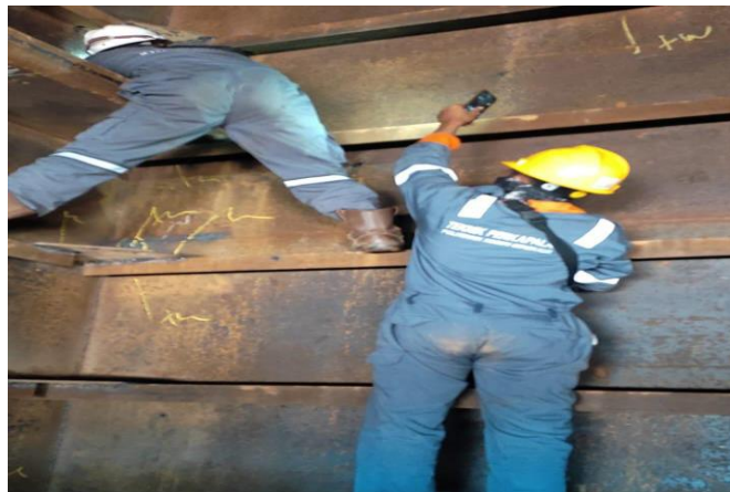
Gambar 2.9 Inspect welding di tangki kapal Tongkang
