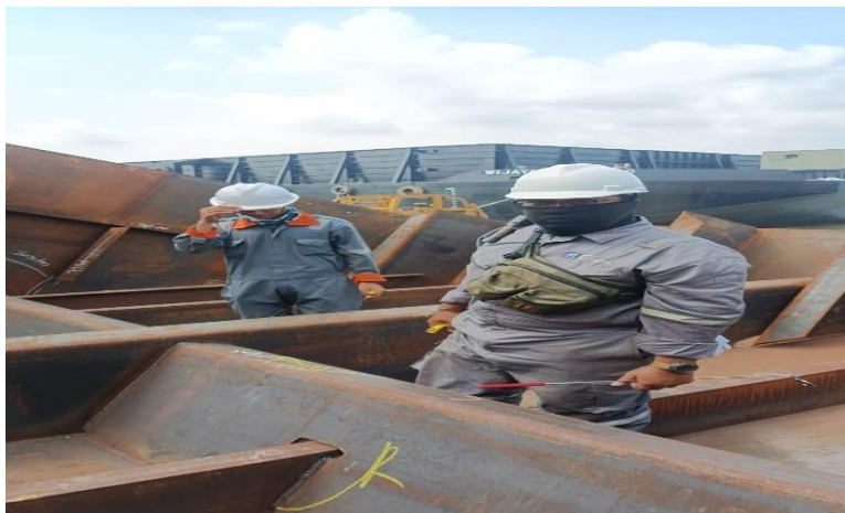
Gambar 2.42 inspect welding pada Bottom
