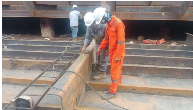
Gambar 2.55 inspect welding pada bottom
