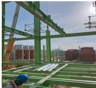
Gambar 3.50 Penempatan Bondek di Atas Gording
