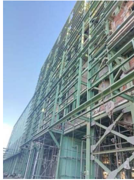
Gambar 3.121 Rangka Clading
