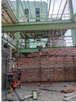
Gambar 3.86 Penyiraman air di pasangan bata
