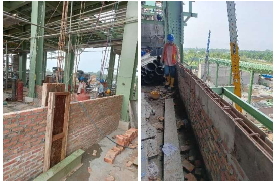
Gambar 3.82 Bekisting kolom dan balok
