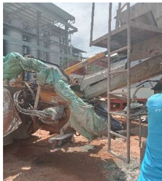
Gambar 3.63 Pengaliran adukan beton
