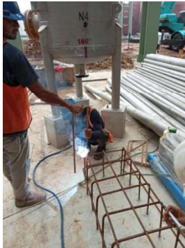
Gambar 3.39 Pengelasan Angkur
