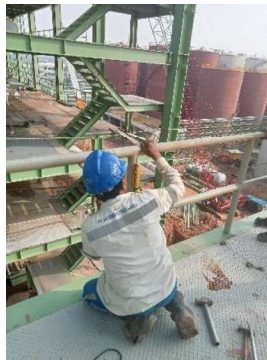
Gambar 3.101 Atur kelurusan menggunakan waterpass
