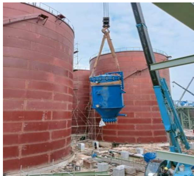
Gambar 3.46 Pengangkatan vessel tank
