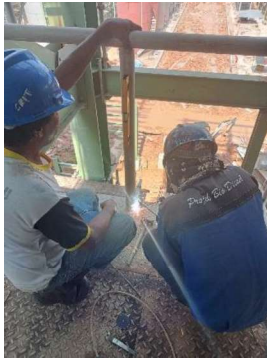
Gambar 3.109 Pengelasan handrail tangga
