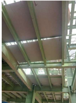
Gambar 3.95 Penempatan checkered plate
