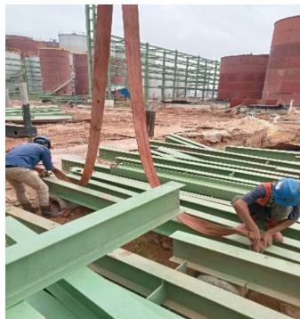
Gambar 3.30 Proses Pengikatan Balok
