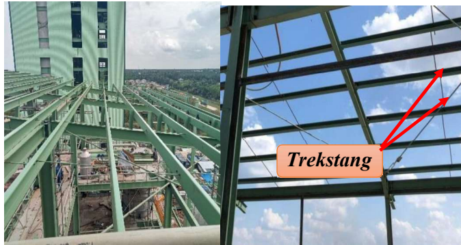
Gambar 3.130 Pemasangan sagrod/trekstang
