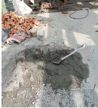
Gambar 3.78 Adukan spesi pasangan bata
