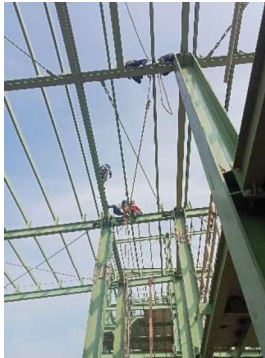
Gambar 3.128 Pemasangan tali angin
