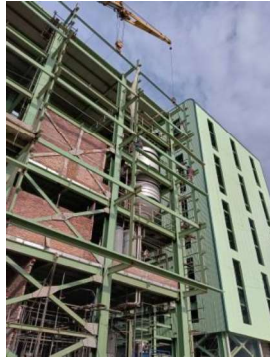
Gambar 3.115 Pegangkatan material clading
