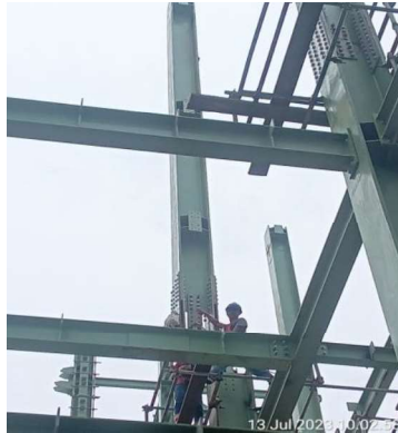
Gambar 3.26 Proses Penyambungan Kolom (Sumber : Dokumentasi Pribadi,2023)
