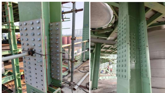
Gambar 3.28 Sambungan Kolom (Sumber : Dokumentasi Pribadi,2023)
