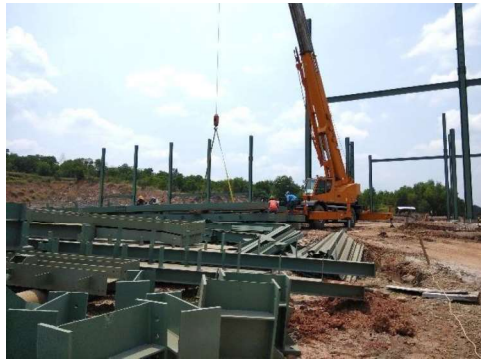
Gambar 3.12 Pengelompokan Material Baja
