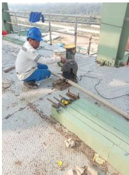
Gambar 3.108 Pengukuran dan pemotongan handrail tangga
