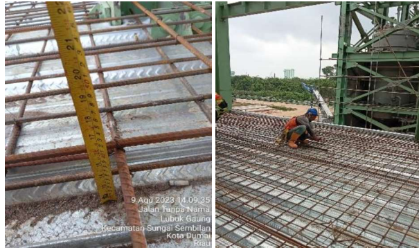
Gambar 3.57 Pembesian lapisan atas
