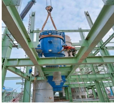
Gambar 3.47 Penempatan dan Penguncian Vessel Tank
