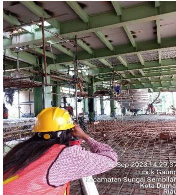
Gambar 3.74 Pengecekan tinggi pengecoran
