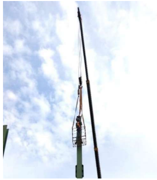
Gambar 3.23 Proses Pelepasan Webbing Sling
