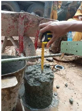
Gambar 3.71 Hasil uji slump
