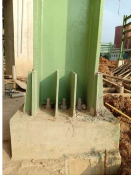
Gambar 3.22 Kolom yang Sudah Terpasang
