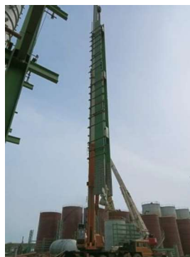
Gambar 3.25 Pengangkatan Kolom Sambungan
