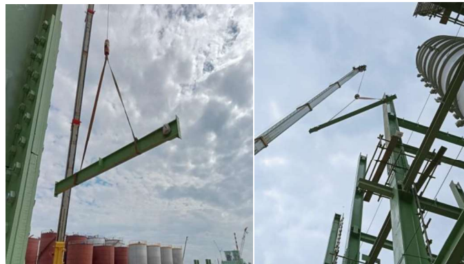
Gambar 3.31 Pengangkatan Material Balok
