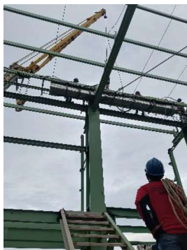
Gambar 3.125 Pengencangan baut
