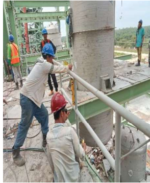
Gambar 3.100 Pemasangan handrail
