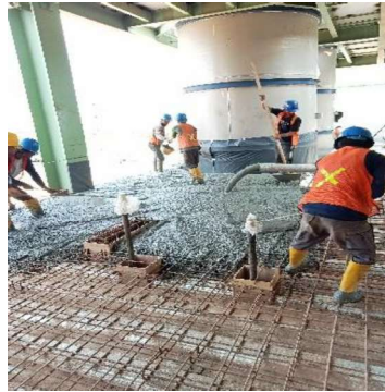
Gambar 3.73 Proses pengecoran plat lantai
