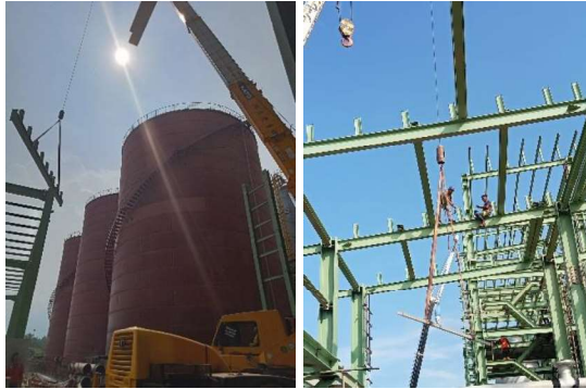
Gambar 3.124 Pengangkatan gording
