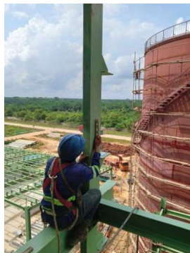
Gambar 3.116 Mengecek kelurusan clading
