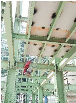
Gambar 3.97 Penyambungan checkered plate
