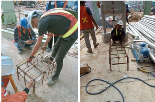
Gambar 3.37 Pemasangan Tulangan Pondasi Equipment
