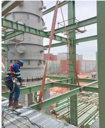
Gambar 3.32 Proses Erection Balok (Sumber : Dokumentasi Pribadi, 2023)
