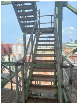
Gambar 3.110 Tangga yang sudah selesai
