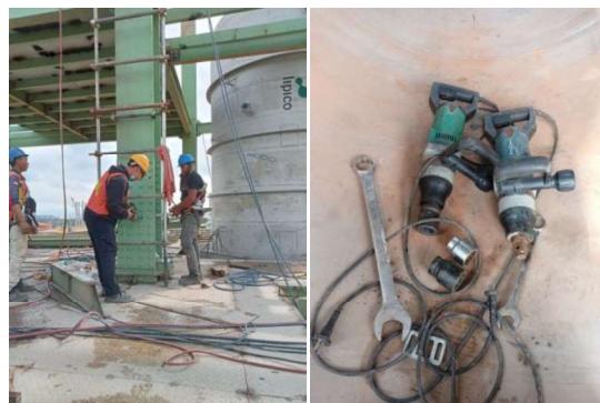
Gambar 3.27 Pengencangan Baut dan Alat Pengunci Baut (Sumber : Dokumentasi Pribadi,2023)
