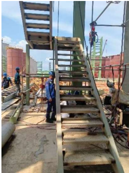
Gambar 3.107 Tangga yang sudah terpasang
