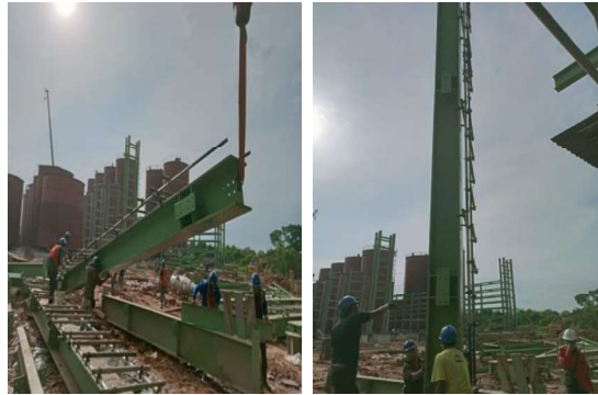
Gambar 3.18 Pengangkatan Kolom
