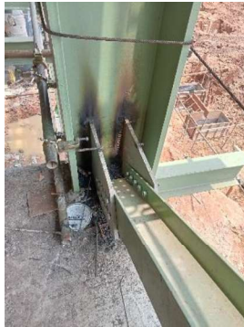
Gambar 3.112 Penguncian baut bracing
