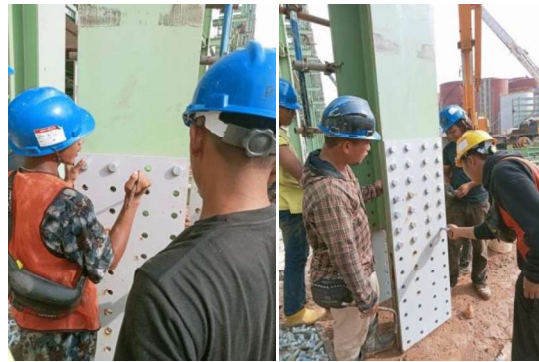
Gambar 3.24 Pemasangan Base Plat dan Baut di Kolom Sambungan
