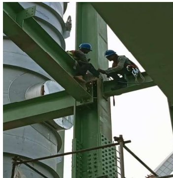
Gambar 3.33 Pengencangan Baut Pada Balok (Sumber : Dokumentasi Pribadi, 2023)
