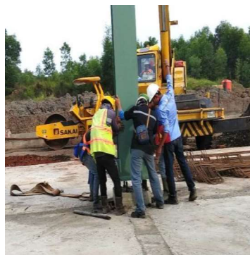
Gambar 3.19 Memposisikan Base Plate ke Angkur
