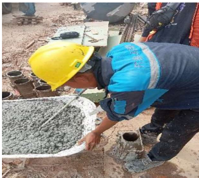
Gambar 3.67 Pemadatan beton uji slump
