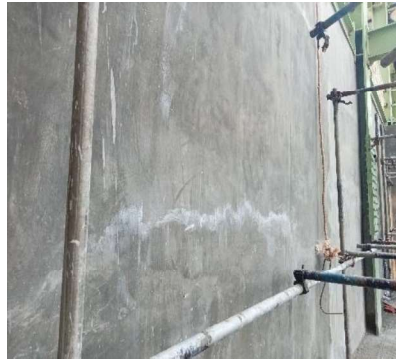
Gambar 3.88 Plasteran yang sudah kering
