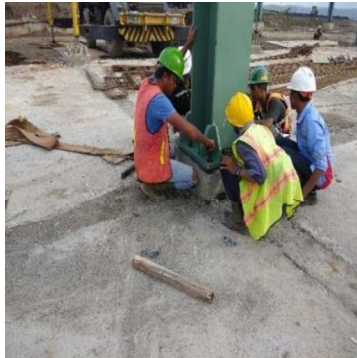
Gambar 3.20 Pengencangan Mur ke Angkur
