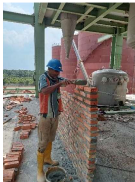
Gambar 3.79 Pemasangan bata merah
