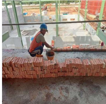
Gambar 3.76 Penyiraman air di bata merah
