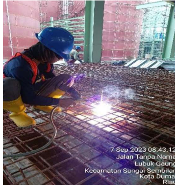
Gambar 3.59 Pemasangan shear conector
