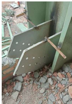
Gambar 3.111 Pengelasan plat bracing
