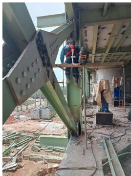
Gambar 3.113 Pemasangan plat di sisi tengah bracing
