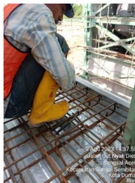
Gambar 3.58 Pembengkokan ujung tulangan
