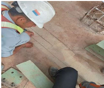
Gambar 3.75 Marking jalur bata merah
