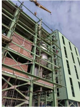
Gambar 3.119 Pengangkatan material clading
