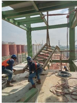
Gambar 3.106 Pengangkatan tangga
