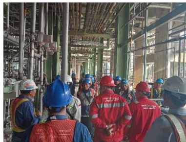
Gambar 3.9 TBM Proyek SCD-CIE
