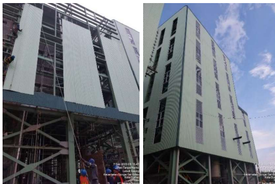
Gambar 3.122 Cladding yang sudah terpasang
