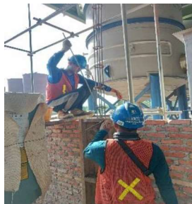
Gambar 3.83 Pengecoran kolom dan balok praktis
