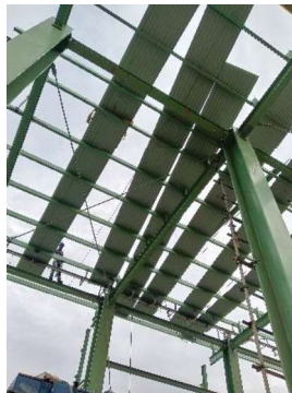
Gambar 3.131 Pemasangan seng
