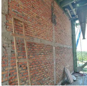
Gambar 3.84 Dinding bata merah
