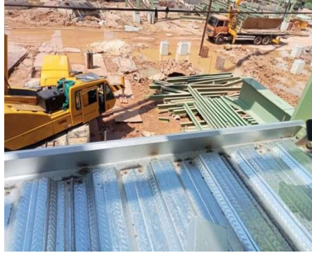
Gambar 3.53 Pemasangan Blassing
