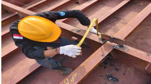
Gambar 2. 3 Melakukan Fit Up Check
