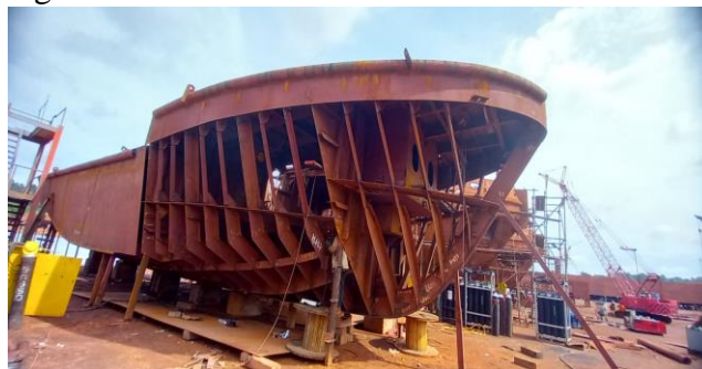
Gambar 2. 4 Mempelajari bangunan konstruksi
