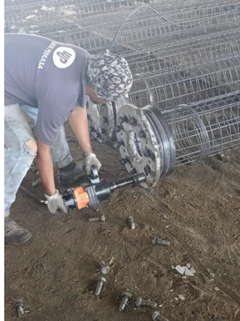
Gambar 3. 16 Pemasangan Joint Sumber: Dokumentasi lapangan KP 2023
