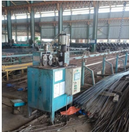
Gambar 3. 13 Pemotongan Tulangan Pokok Sumber: Dokumentasi lapangan KP 2023
