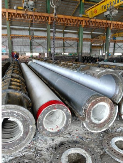
Gambar 3. 22 Pembongkaran Moulding Sumber: Dokumentasi lapangan KP 2023
