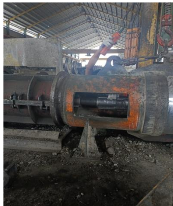
Gambar 3. 19 Penarikan Tulangan ( Stressing )
