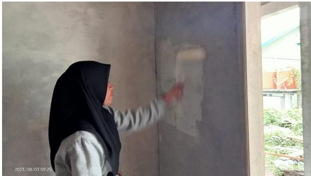
Melaksanakan Pekerjaan Pengecatan
