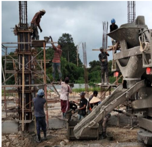
Gambar 3. 34 Pekerjaan pengecoran kolom Sumber :Dokumentasi lapangan, 2023)
