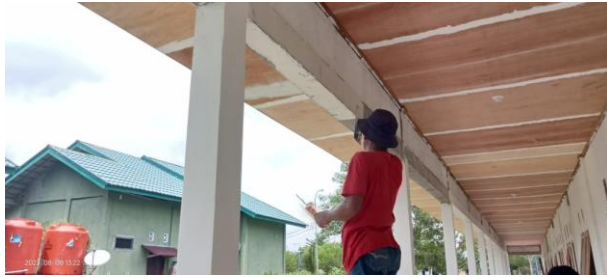
Melaksanakan Pekerjaan Acian Balok
