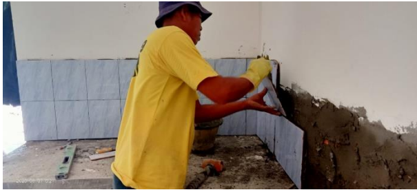
Melaksanakan Pekerjaan Pemasangan Keramik
