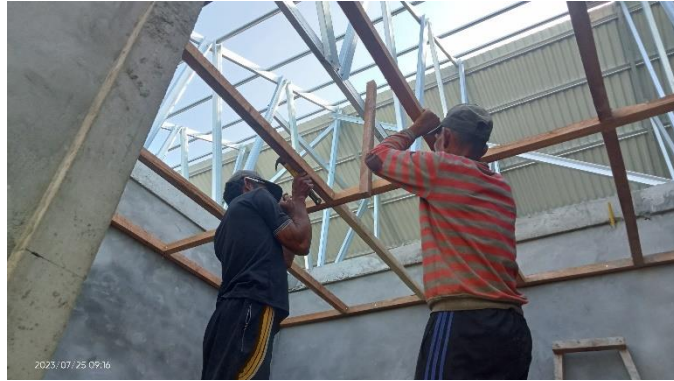
Gambar 3. 13 Pekerjaan pemasangan Plafond Sumber : Dokumentasi lapangan, 2023
