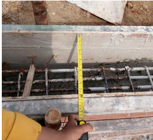
Gambar 3. 26 pengecekan bekisting yang terpasang Sumber :Dokumentasi lapangan, 2023)
