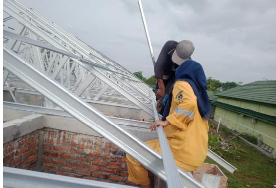
Gambar 3. 10 Pekerjaan pemasangan rangka atap Sumber : Dokumentasi lapangan, 2023
