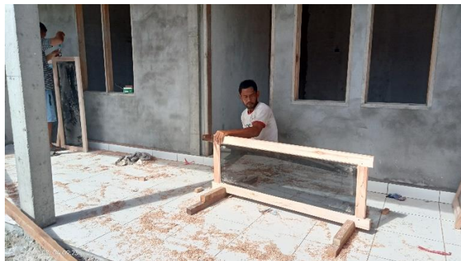
Gambar 3. 15 Pekerjaan pemasangan pintu dan jendela Sumber : Dokumentasi lapangan, 2023
