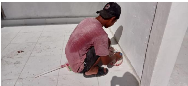
Melaksanakan Pekerjaan Pekerjaan Dempul
