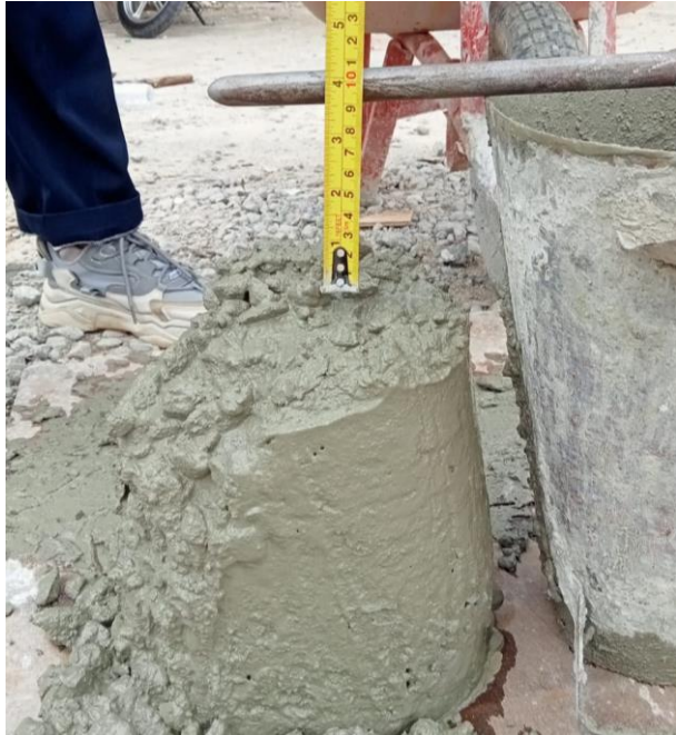
Pekerjaan pengujian slump
