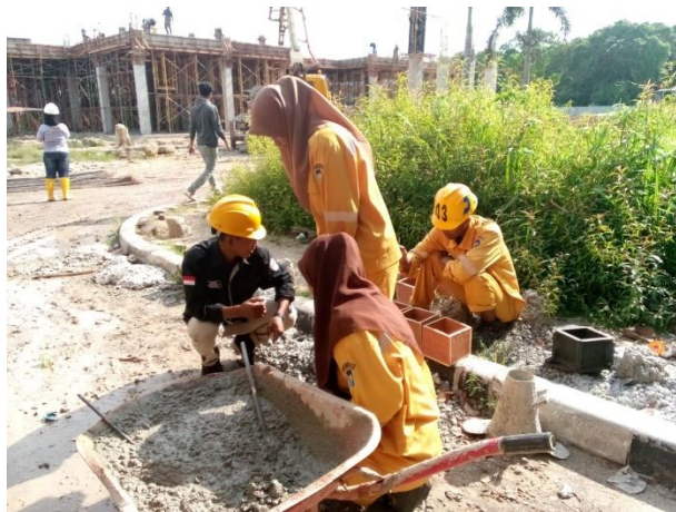
Pekerjaan pembuatan benda uji kubus
