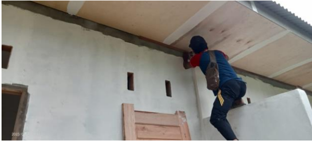
Melaksanakan Pemasangan Profil Plafond
