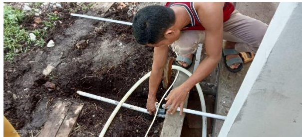
Melaksanakan Pekerjaan Pemasangan Pipa Air Bersih
