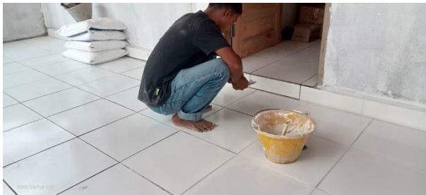
Melaksanakan ,Pekerjaan Dempul Keramik
