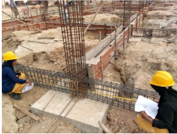
Gambar 3. 25 pengecekan pembesian tulangan ekstra Sumber :Dokumentasi lapangan, 2023)
