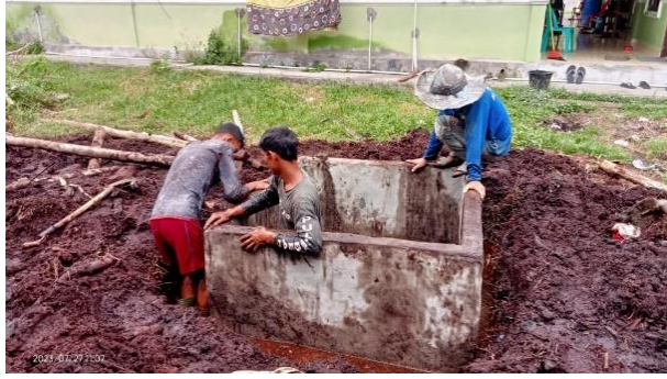
Melaksanakan Pekerjaan Pemasangan Septic Tank
