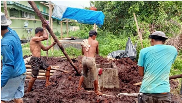
Melaksanakan Pekerjaan Pemasangan Pembuangan Air Septic Tank
