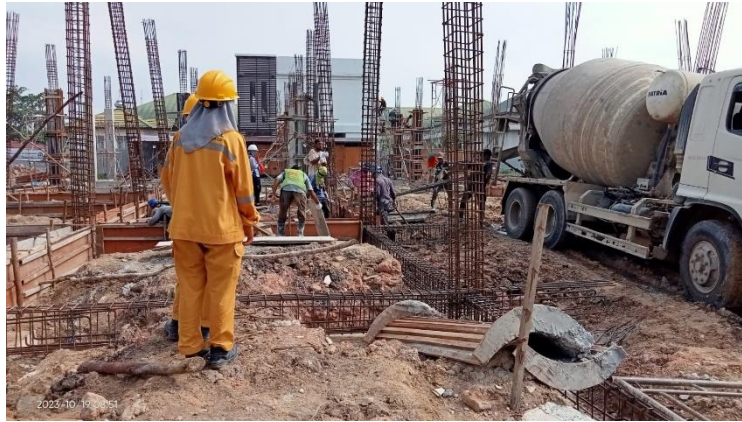
Gambar 3. 27 Pekerjaan pengecoran tie beam Sumber :Dokumentasi lapangan, 2023)
