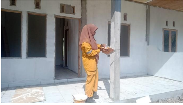
Melaksanakan Pekerjaan Acian Kolom
