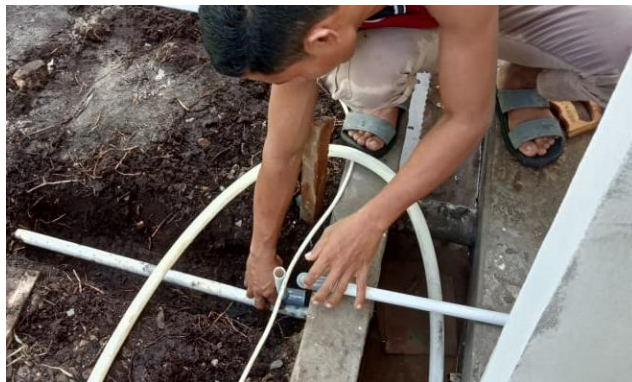
Gambar 3. 16 Pekerjaan pemasangan pipa air bersih Sumber : Dokumentasi lapangan, 2023
