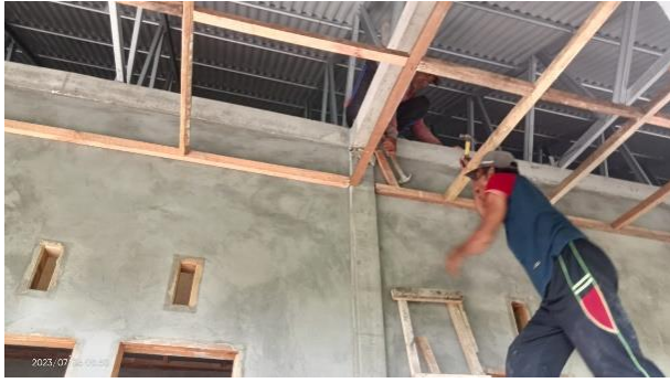
Pekerjaan Pemasangan Kerangka Plafond
