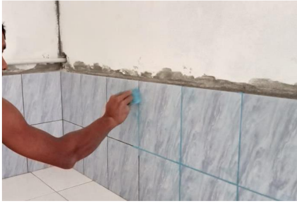
Melaksanakan Pekerjaan Dempul Keramik
