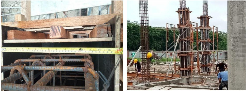
Gambar 3. 33 Pekerjaan Bekisting kolom (Sumber :Dokumentasi lapangan, 2023)
