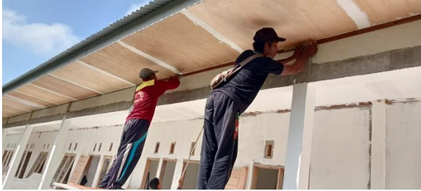
Melaksanakan Pekerjaan Pemasangan Profil Plafond
