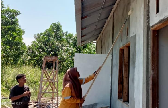
Gambar 3. 17 Pekerjaan Pengecatan Sumber : Dokumentasi lapangan, 2023
