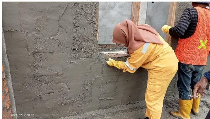
Gambar 3. 9 Pekerjaan plasteran Sumber : Dokumentasi lapangan, 2023
