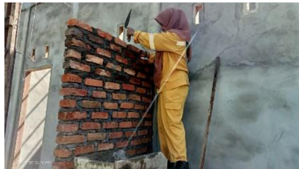
Pasangan Dinding Bata Batas Teras Belakang
