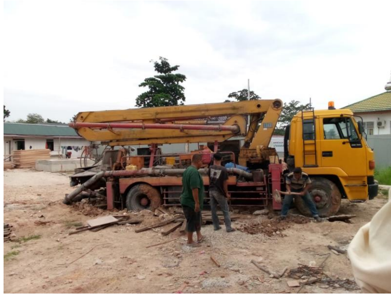
Gambar 3. 21 Concrete pump Sumber : Dokumentasi Lapangan, 2023)
