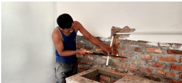
Melaksanakan Pekerjaan Pemasangan Pipa Air Bersih
