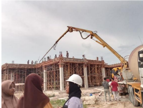
Gambar 3. 39 pengecoran balok dan plat lantai Sumber :Dokumentasi lapangan, 2023)
