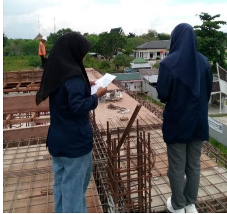
Gambar 3. 38 Pengecekan Pembesian balok Sumber :Dokumentasi lapangan, 2023)
