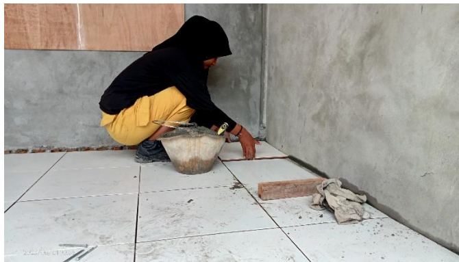
Gambar 3. 12 Pekerjaan pemasangan Keramik Sumber : Dokumentasi lapangan, 2023
