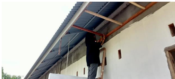
Melaksanakan Pekerjaan Pemasangan Biri-Biri
