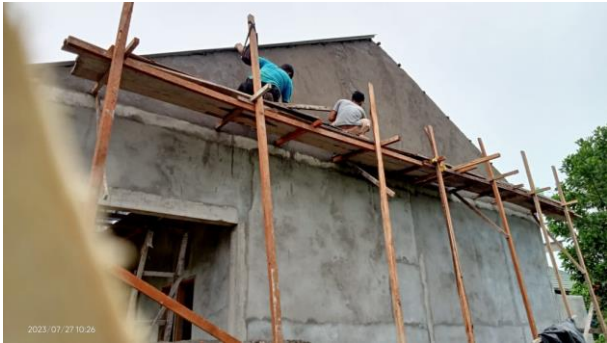
Melaksanakan Pekerjaan Plasteran Dinding
