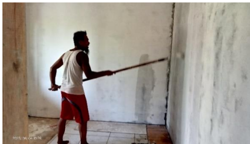
Melaksanakan Pekerjaan Pengecatan
