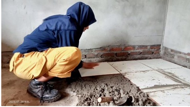
Melaksanakan Pekerjaan Pemasangan Keramik
