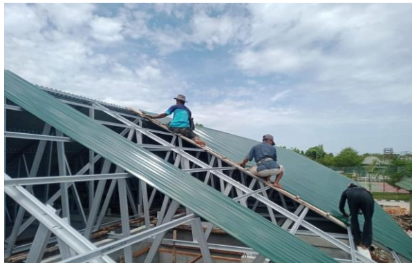
Gambar 3. 11 Pekerjaan pemasangan Penutup atap Sumber : Dokumentasi lapangan, 2023
