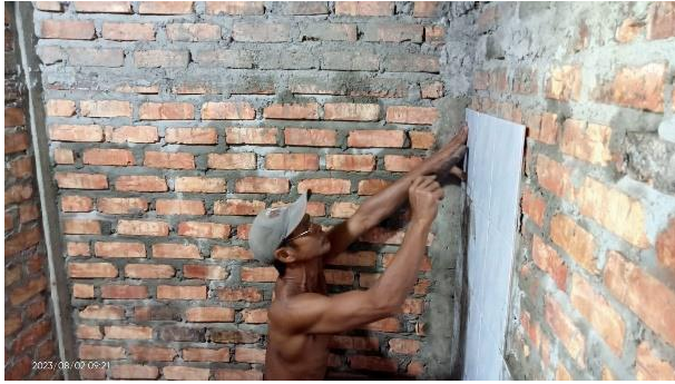
Melaksanakan Pemasangan Keramik
