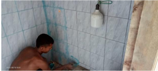
Melaksanakan Pekerjaan Dempul Keramik
