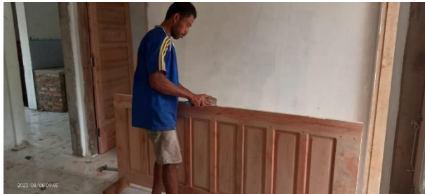
Melaksanakan Pekerjaan Pemasangan Daun Pintu
