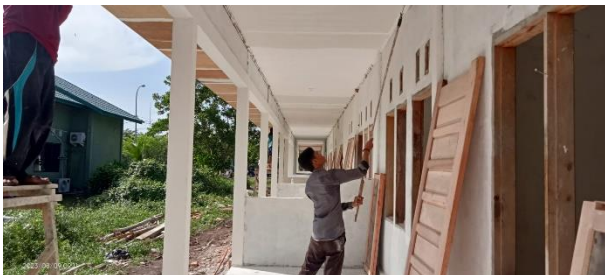
Melaksanakan Pekerjaan Pengecatan
