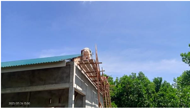
Pekerjaan Pemasangan Dinding Bata
