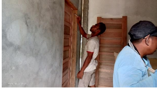
Melaksanakan Pekerjaan Pemasangan Daun Pintu
