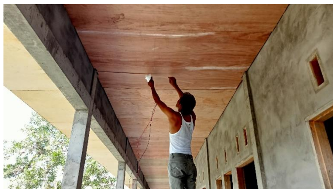
Gambar 3. 14 Pekerjaan pemasangan instalasi listrik Sumber : Dokumentasi lapangan, 2023
