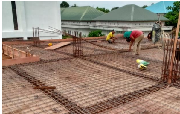
Gambar 3. 35 Bekisting balok dan plat lantai Sumber :Dokumentasi lapangan, 2023)
