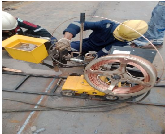
Gambar 2. 15 Proses las saw
