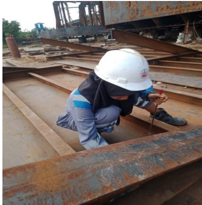
Gambar 2. 64 Inspeksi Cacat Las Side Board
