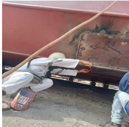
Gambar 2. 19 Pengukuran plate Di ganti
