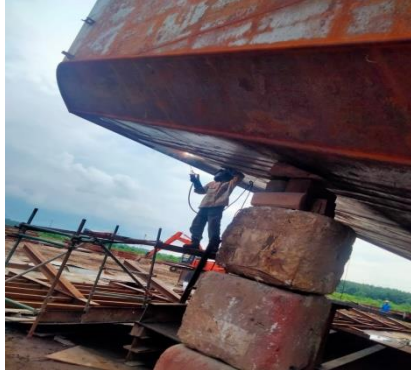
Gambar 2. 69 Welding Bagian Skeq
