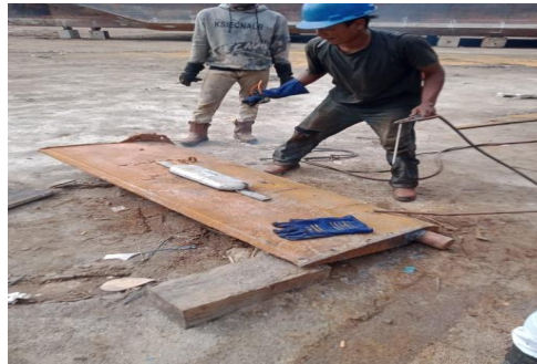
Gambar 2. 49 Pemasangan Zinc Anode
