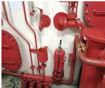
Gambar 3. 13 Pemasangan Fuel Piping
