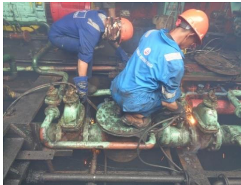
Gambar 3. 2 pembongkaran pipa pendingin
