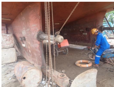
Gambar 3. 3 Pelepasan Poros Propeller
