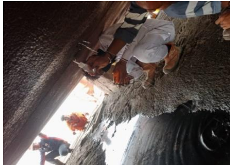
Gambar 2. 29 Pengolesan Gel ke Plate
