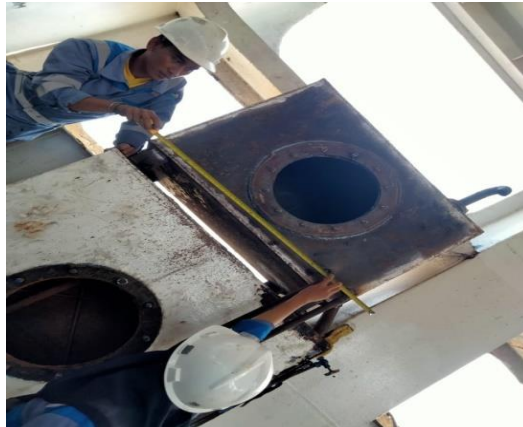
Gambar 2. 32 Pengukuran tangki ekspansi
