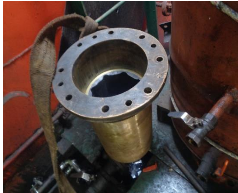
Gambar 3. 14 Pemasangan Bantalan Poros
