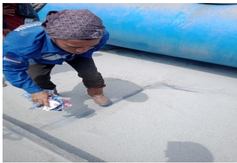
Gambar 2. 24 Pembersihan permukaan plate
