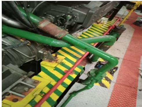
Gambar 3. 12 Pemasangan Instalasi Pipa Pendingin
