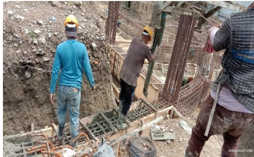
Gambar 3.4 pengecoran pondasi Sumber : Dokumentasi lapangan
