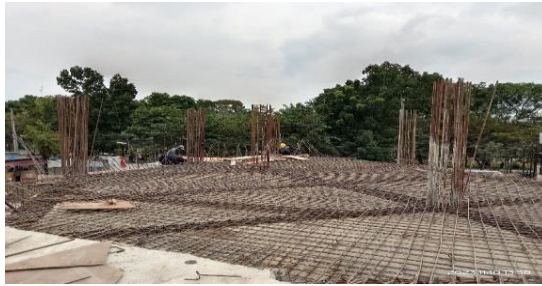
Gambar 3.8 Penulangan plat lantai dan balok Sumber : Dokumentasi lapangan
