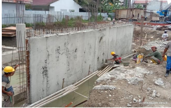
Gambar 3.10 Pekerjaan shear wall Sumber : Dokumentasi lapangan
