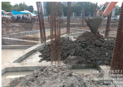
Gambar 3.5 Pekerjaan penimbunan Sumber : Dokumentasi lapangan
