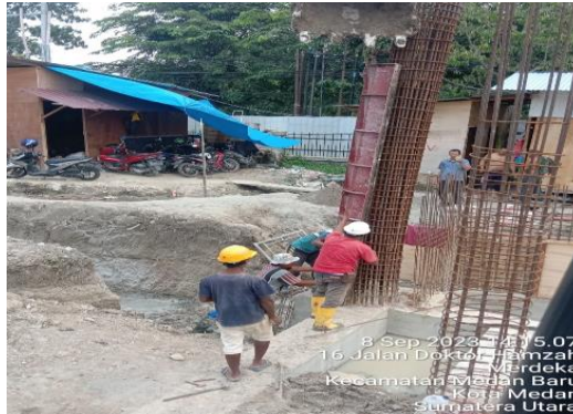
Gambar 3.6 Pemasangan column mould Sumber : Dokumentasi lapangan
