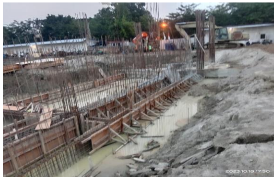
Gambar 3.11 Pekerjaan tulangan shear wall Sumber : Dokumentasi lapangan
