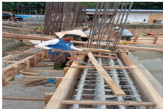
Gambar 3.3 Pekerjaan pembesian Sumber : Dokumentasi lapangan
