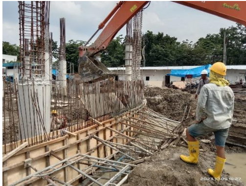
Gambar 3. 12 Pengecoran tulangan shear wall Sumber : Dokumentasi lapangan
