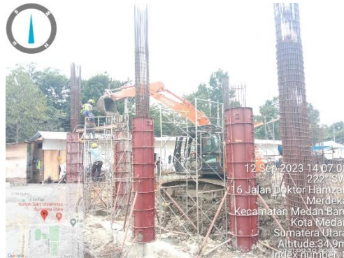
Gambar 3.7 Pengecoran kolom Sumber : Dokumentasi lapangan
