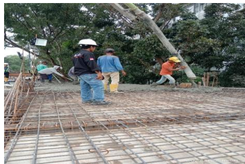
Gambar 3.9 Pengecoran plat lantai dan balok Sumber : Dokumentasi lapangan
