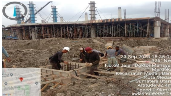
Gambar 3.2 Pekerjaan pembesian Sumber : Dokumentasi lapangan
