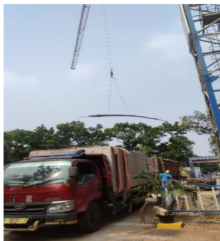
Gambar 3. 14 Pengangkatan Besi (Sumber: Dokumentasi pribadi)
