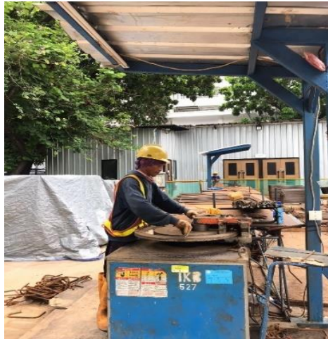
Gambar 3. 13 Pembengkokan Tulangan (Sumber Dokumentasi Pribadi, 2023)
