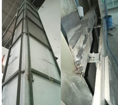
Gambar 3. 21 Pemasangan Kerangka Baja (Sumber Dokumentasi Pribadi 2023)
