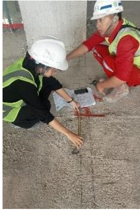
Gambar 3. 3 Sebar as Grid (Sumber: Dokumentasi Pribadi Lapangan 2023)
