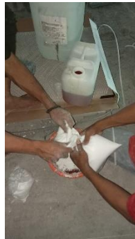
Gambar 3. 22 Pencampuran Resin & Kalak (Sumber Dokumentasi Pribadi 2023)
