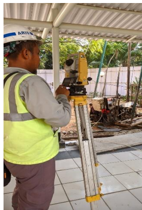
Gambar 3. 1 Pekerjaan Penentuan as Kolom oleh Surveyor (Sumber: Dokumentasi Pribadi Lapangan 2023)
