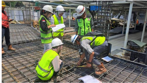
Gambar 3. 16 Pengecekan tulangan plat dan balok (Sumber: Dokumentasi pribadi)
