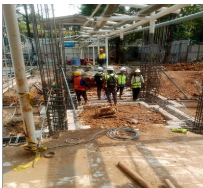
Gambar 3. 29 Lean Concrete (Sumber: Dokumentasi Pribadi 2023)
