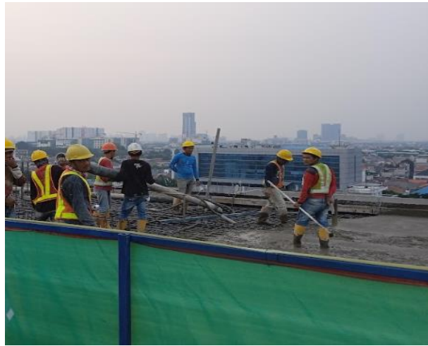
Gambar 3. 17 Pengecoran (Sumber: Dokumentasi pribadi)
