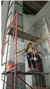
Gambar 3. 23 Pemasangan Keramik atau le marbel (Sumber Dokumentasi Pribadi 2023)
