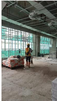
Gambar 3. 19 Pembersihan Area Kerja (Sumber Dokumentasi Pribadi 2023)
