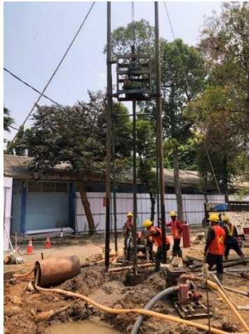
Gambar 3. 28 Pondasi Bore Pile (Sumber: Dokumentasi Pribadi 2023)
