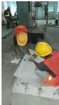
Gambar 3. 20 Pengukuran & Pemotongan (Sumber Dokumentasi Pribadi 2023)
