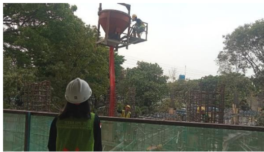
Gambar 3. 31 Pengecoran pondasi Bore Pile (Sumber: Dokumentasi Pribadi 2023)
