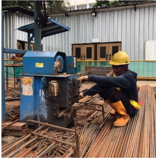
Gambar 3. 12 Pemotongan Besi tulangan (Sumber: Dokumentasi pribadi,2023)
