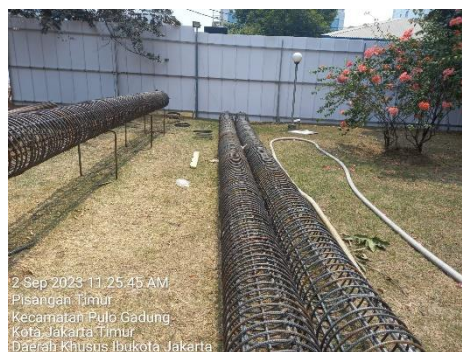
Gambar 3.30 Perakitan Besi Tulangan (Sumber: Dokumentasi Pribadi 2023)
