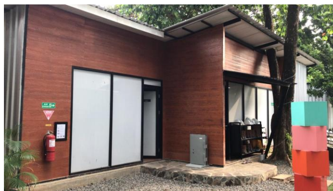
Gambar 2. 9 Ruang PMSC & Owner (Sumber: Dokumentasi Pribadi 2023)
