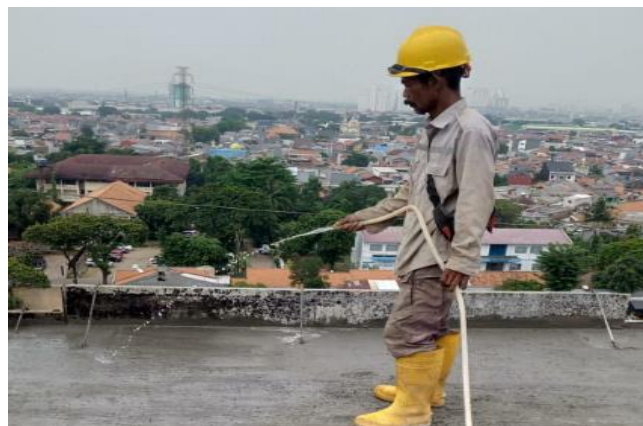
Gambar 3. 18 Perawatan Beton (Sumber Dokumentasi Pribadi 2023)
