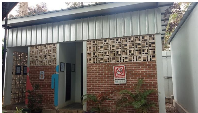
Gambar 2. 15 Toilet (sumber: Dokumentasi Pribadi 2023)
