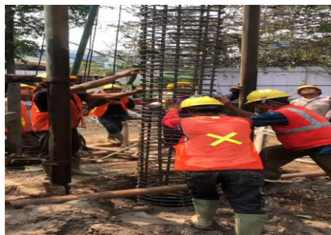
Gambar 3.1 Pemasangan Besi (Sumber: Dokumentasi Pribadi 2023)
