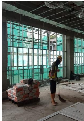
Gambar 3. 2 Pembersihan Area Kerja (Sumber: Dokumentasi Pribadi Lapangan 2023)
