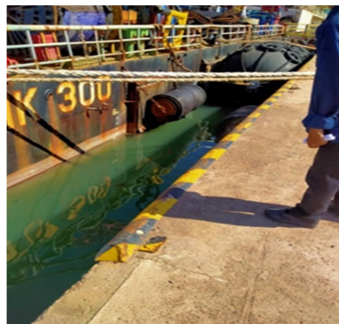
Gambar 2.13 Aktivitas Pengecekan Jetty PT. MEB
