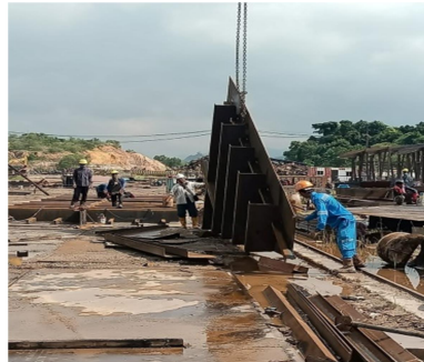
Gambar 2.13 Aktifitas pemasangan side shell
