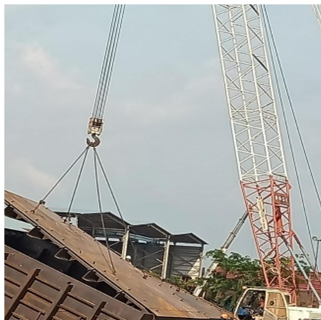
Gambar 3.9 Aktifitas pemasangan deck
