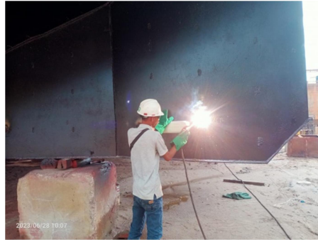
Gambar 2.8 Aktifitas monitor pemasangan zinc anode
