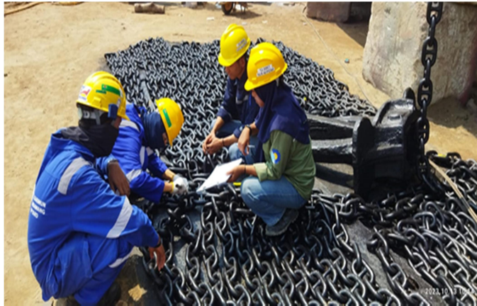
Gambar 2.4 Aktifitas kalibrasi rantai jangkar
