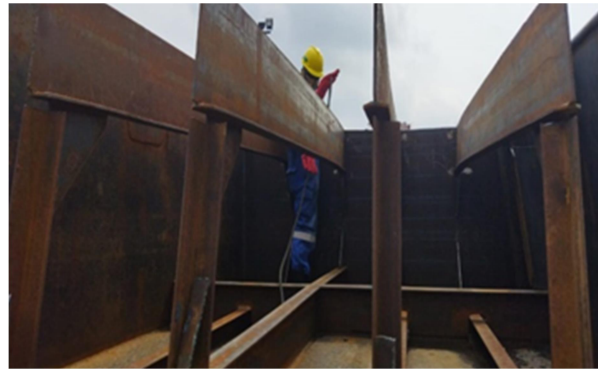
Gambar 2.15 Aktifitas pemasangan frame
