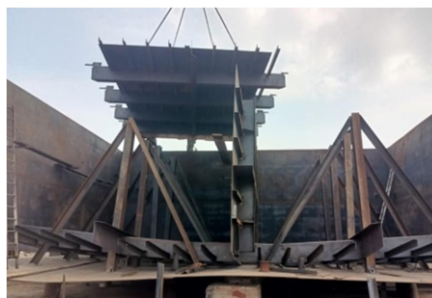
Gambar 2.7 Aktifitas pemasangan deck kapal tongkang
