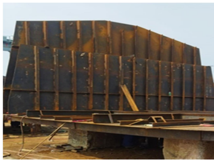
Gambar 2.19 Aktifitas pengecekan frame kapal TB
