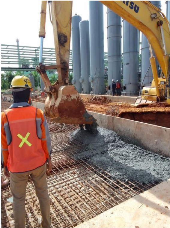
Proses Pengecoran Plat Lantai dan Kolom
