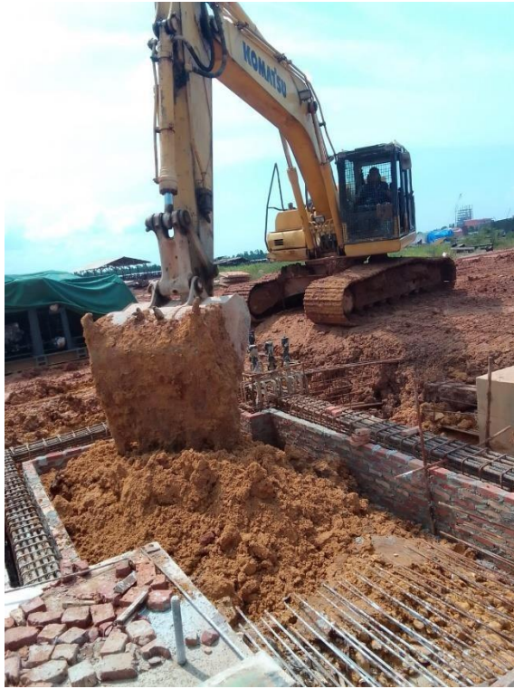
Pemerataan tanah untuk erection equipment area compressor
