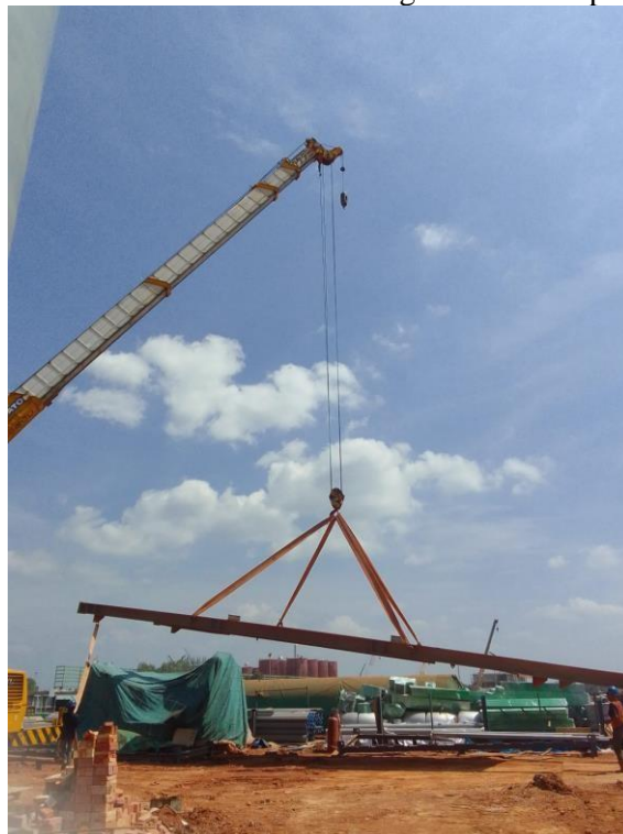
Pemindahan material konstruksi kesite yang akan diseting
