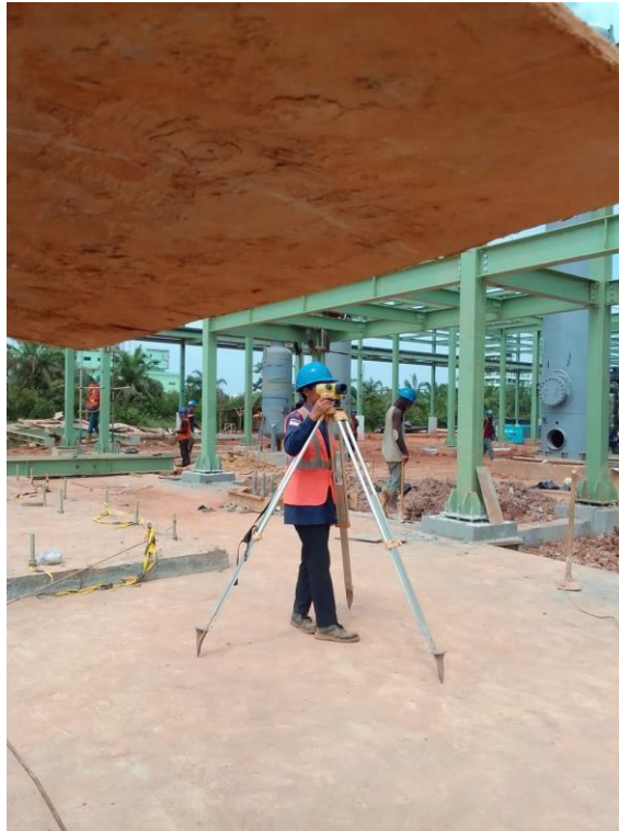
Pengecekan vertikalitas
