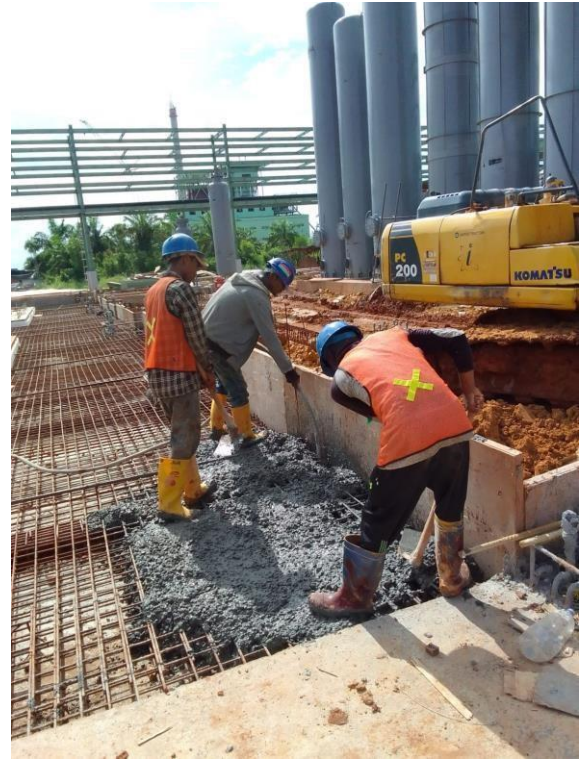
Proses Pengecoran Plat Lantai dan Kolom
