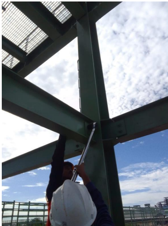
Pengecekan kekuatan baut pada sambungan struktur area reformer
