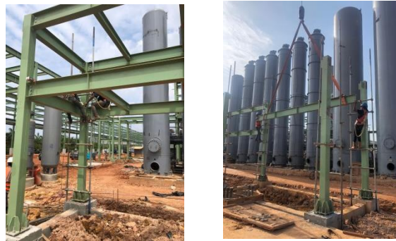
Gambar 3. 23 pekerjaan erection balok Beam (Sumber : Dokumentasi Pribadi, 2023)
