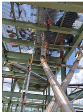
PEMASANGAN PIPA PISEL EL. 8500
