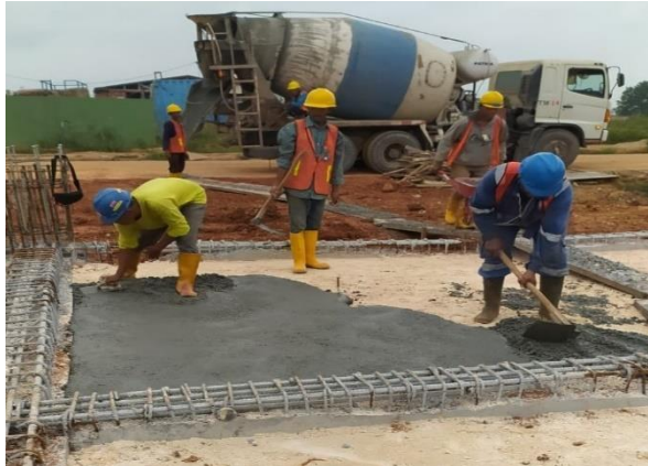
Gambar 3. 14 Lean Concrete (Sumber : Dokumentasi Pribadi, 2023 )
