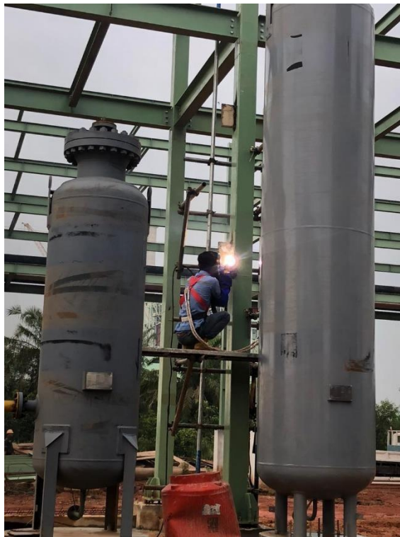
Pengelasan penyanggah balok el..3000 area piperack
