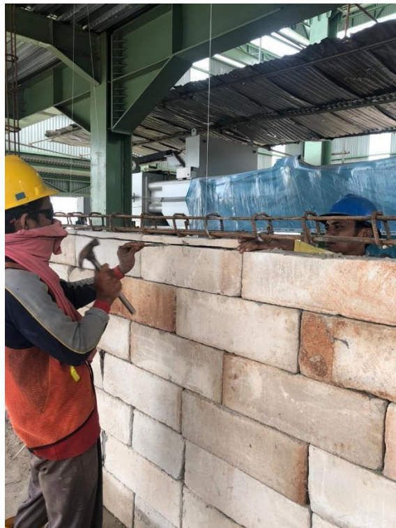
Instal dinding menggunakan batu ebel
