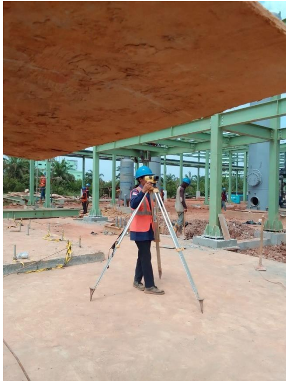
Menentukan level pada pedestal area compressor
