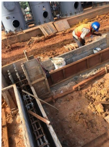
Gambar 3. 20 Pemasangan Bekisting Pedestal (Sumber : Dokumentasi Pribadi, 2023 )
