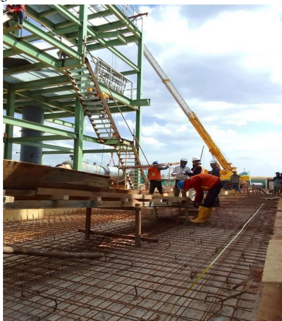
Install talang untuk jalur beton
