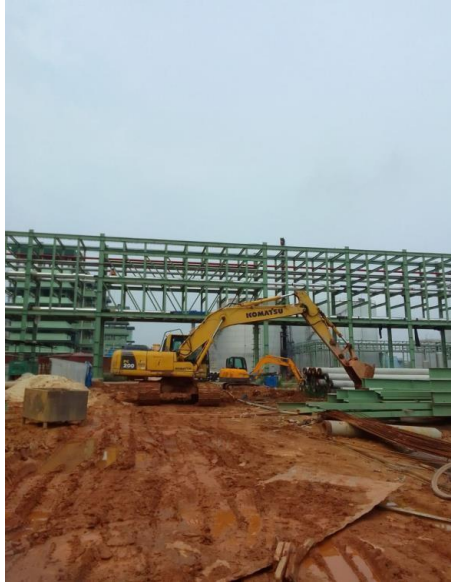
Penggalian Area Piperack E
