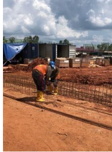
PERAKITAN TULANGAN GUTTER
