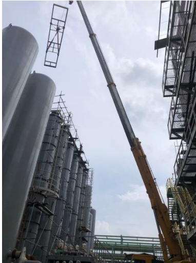
ERECTION PLAT LANTAI AREA PLANTH2 ALIGAS TABUNG
