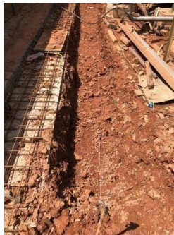
PENGGALIAN TANAH GUTTER 30X30 AREA REFORMER
