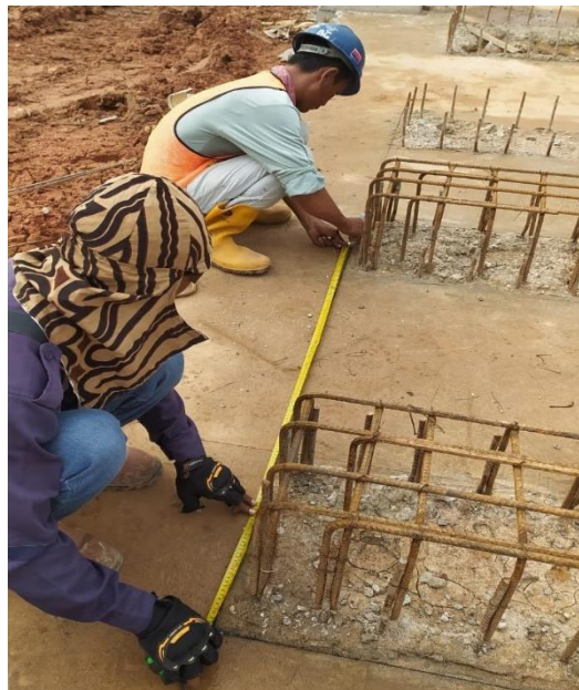
Gambar 3. 17 Pemasangan Besi Equipment (Sumber : Dokumentasi Pribadi, 2023 )
