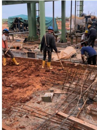
Pengawasan Install Gater
