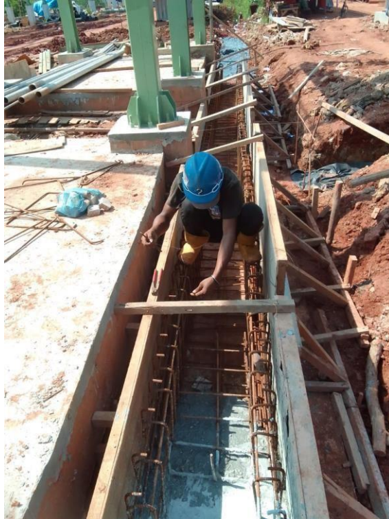
Pengawasan instal tulangan gater 30x30 area absorber
