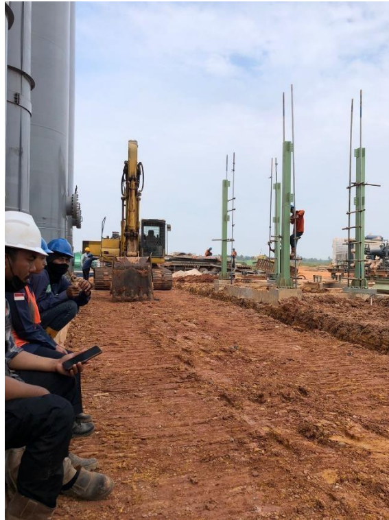
Pemadatan tanah untuk jalur crane
