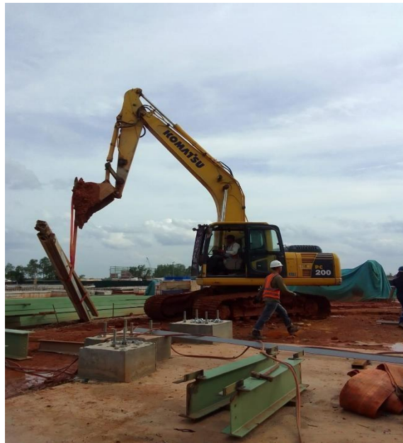
Pemindahan material kontruksi ke site yang mau di-setting
