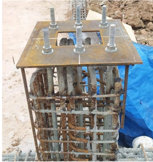
Gambar 3. 19 Pemasangan Anchor Bolt (Sumber : Dokumentasi Pribadi, 2023 )
