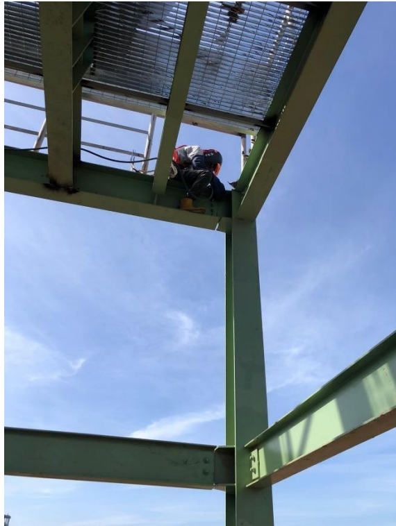
Penyambungan beam menggunakan las el. 11.000
