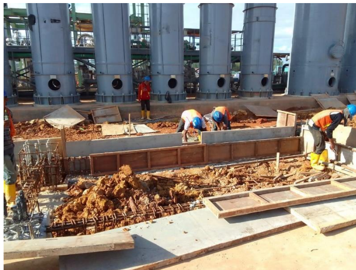
Gambar 3. 11 Pemasangan Bekisting Tie Beam (Sumber : Dokumentasi Pribadi, 2023 )
