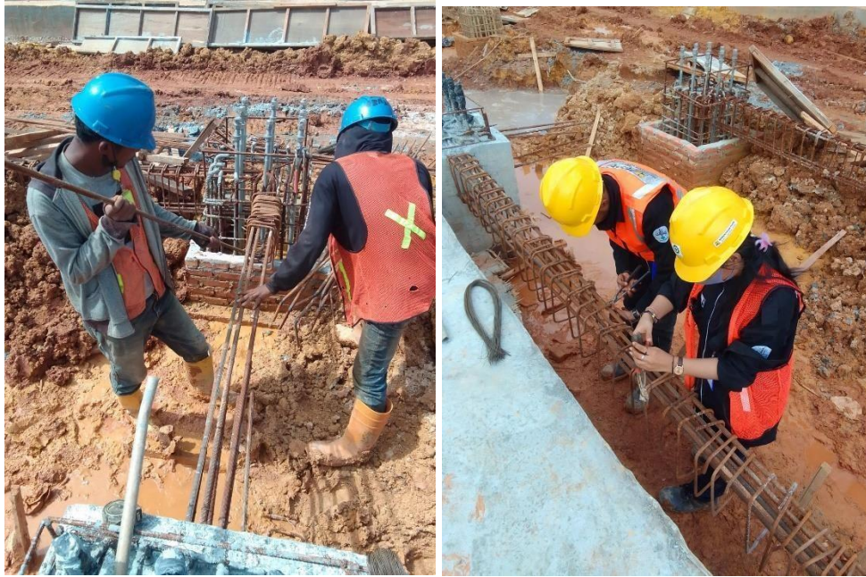
Instal Tulangan Utama dan Pinggang
