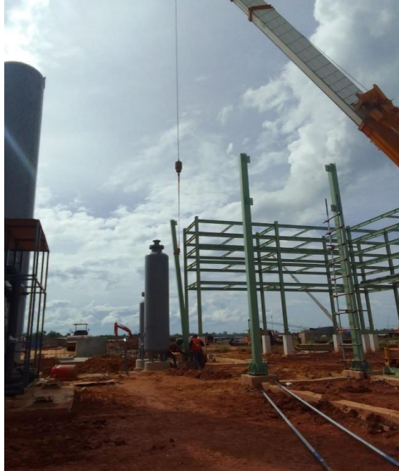
INSTAL KOLOM BAJA
