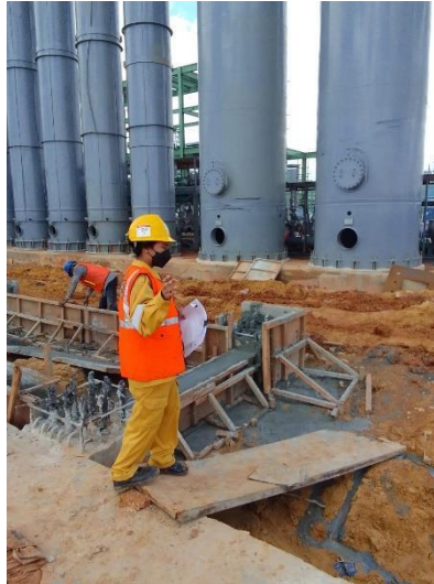
Gambar 3. 12 Pengecoran Tie Bea (Sumber : Dokumentasi Pribadi, 2023 )
