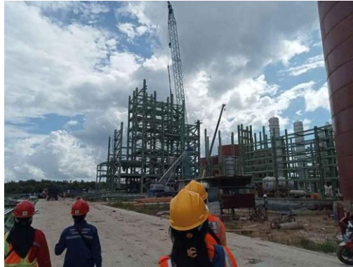
Gambar 3. 8 Inspeksi Area Proyek (Sumber : Dokumentasi pribadi, 2023)
