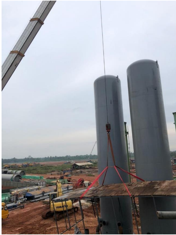
Erection struktur penutup area reformer
