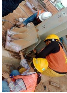
Pemberihan kolom instan menggunakan tinerr
