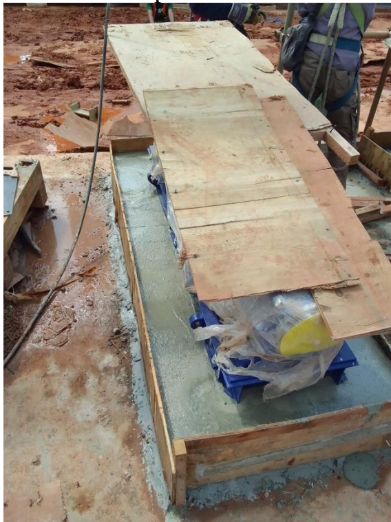
Pembuatan grouting diarea reformen
