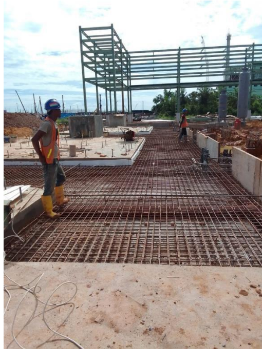
Gambar 3. 15 Pembesian Lantai (Sumber : Dokumentasi Pribadi, 2023 )
