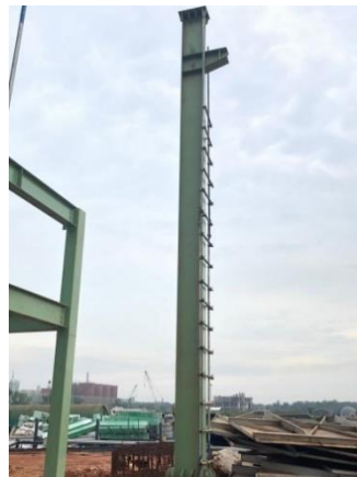
Gambar 3. 22 pekerjaan Erection kolom (Sumber : Dokumantasi Pribadi, 2023)
