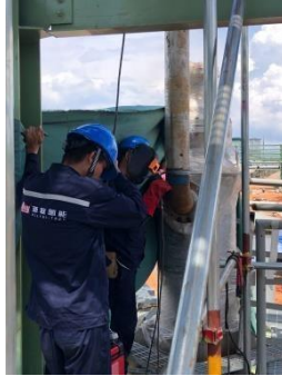
PENGELASAAN PIPA PISEL MENGGUNAAKAN LAS ARGON
