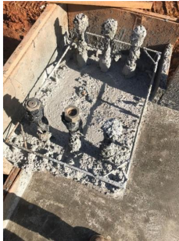
Gambar 3. 18 Pemasangan Bekisting Equipment (Sumber : Dokumentasi Pribadi, 2023 )
