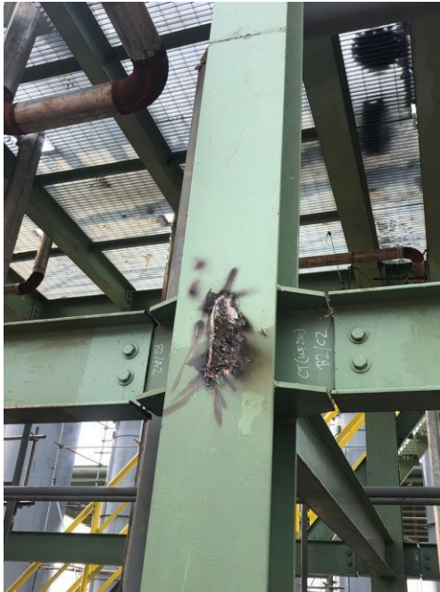
PENGECEKAN SAMBUNGAN KOLOM AREA PLANT H2 ALIGAS
