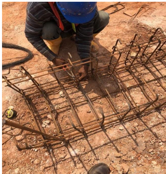
Install tulangan untuk gater
