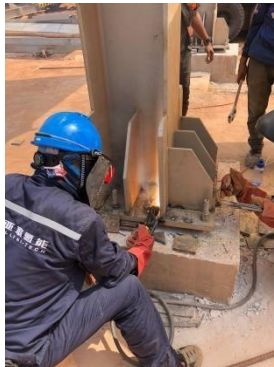
PENGELASAAN KOLOM INSTAN AREA REFORMRR 3 LAYER
