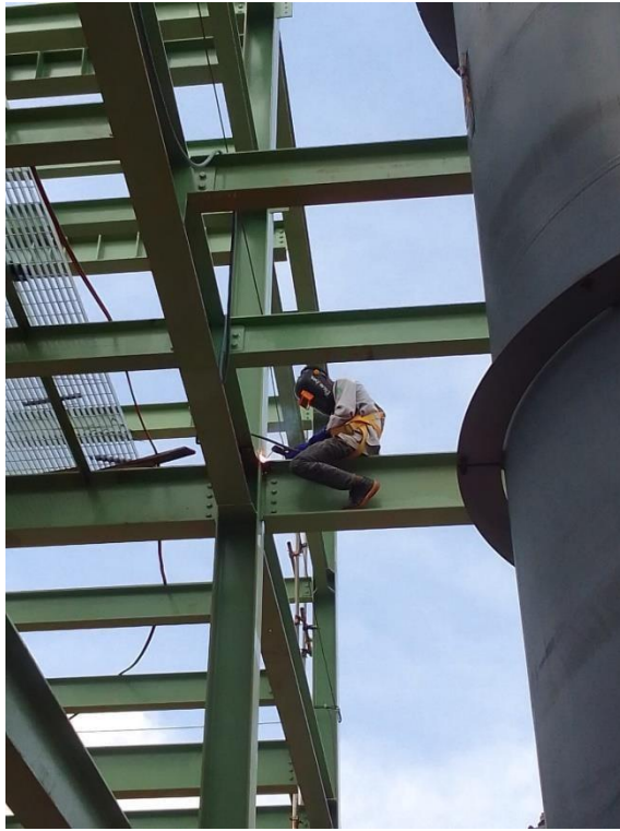
Pengelasan gab beam untuk coloum area reformen
