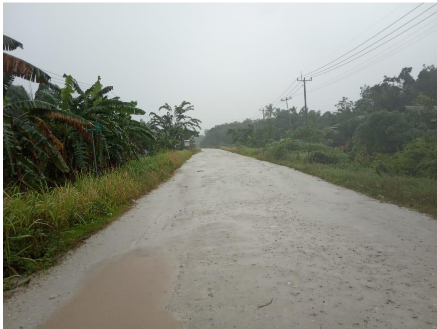
Gambar 1.1 Kondisi existing jalan Subrantas, desa Sukardjo Mesim, Rupa Sumber: Dokumentasi lapangan
