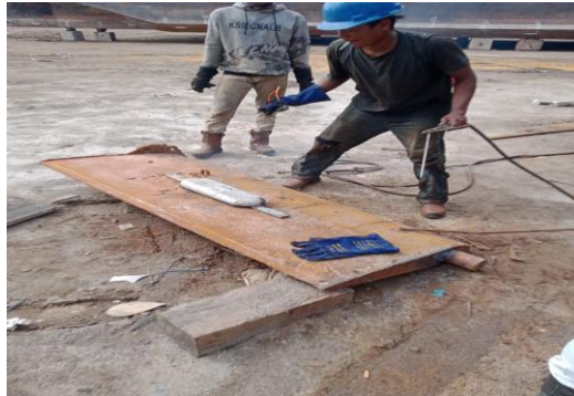
Gambar 2. 30 Pemasangan Zine Anode
