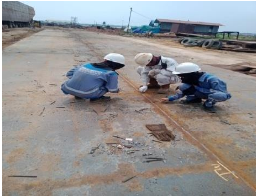
Gambar 2. 15 cacat las menggunakan alat SAW
