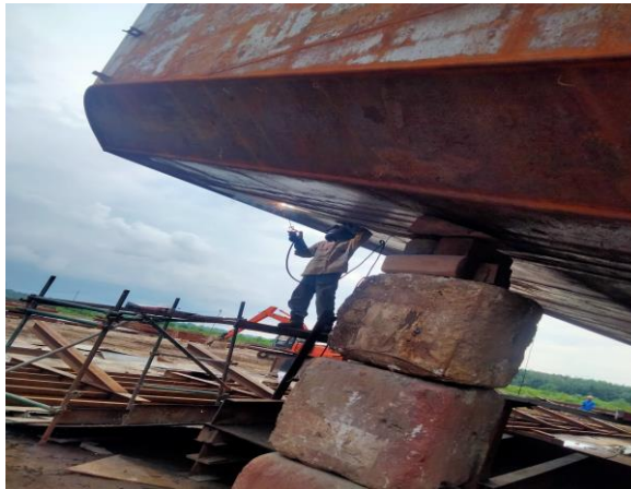
Gambar 2. 51 Welding dibagian tongkang
