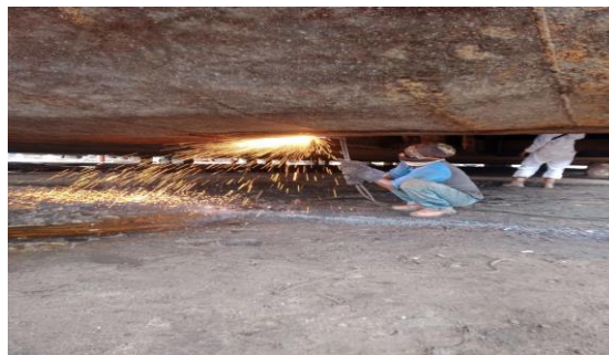
Gambar 2. 31 Pemotongan Plate
