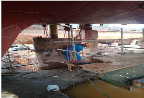
Gambar 2. 28 Pemasangan Daun kemudi
