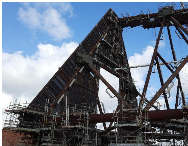
Gambar 2.32 Posisi Mudmad setelah dilakukan Lifting menggunakan Crane
