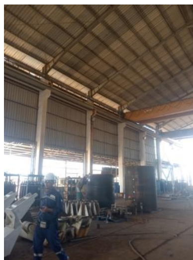
Gambar 2.8 Proses Fabrikasi Jacket
