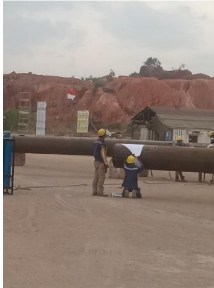
Gambar 2.22 Marking Pada Pipa sebelum dilakukan Cutting
