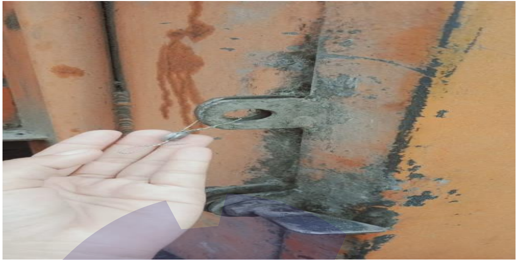
Gambar 3.24 Pengecekan Segel Sumber: PT. KLK Dumai
