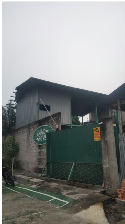
Gambar 3. 38 CV.Safana kontruksi Sumber : (Dokumentasi KP 2023)
