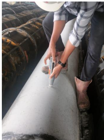
Gambar 3. 36 Hammer test Sumber : (Dokumentasi KP 2023)
