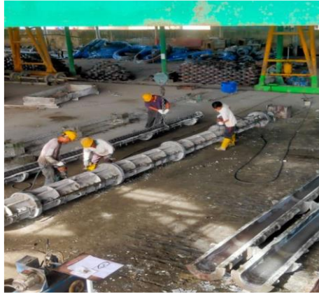
Gambar 3. 21 Pemasangan tutup cetakan/moulding (Sumber : Dokumentasi KP 2023)
