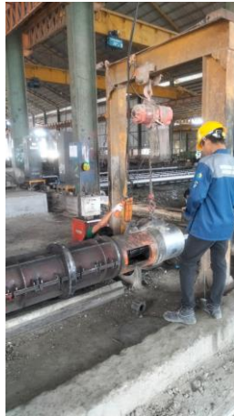
Gambar 3. 10 Proses stressing (Sumber : Dokumentasi KP 2023)
