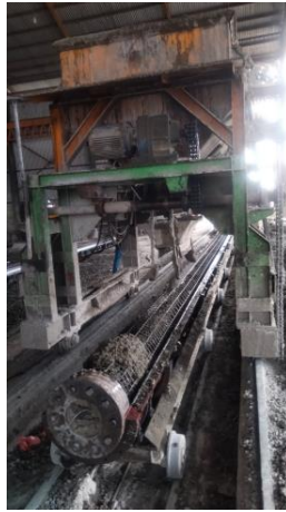
Gambar 3. 8 Pengisian moulding/pengecoran (Sumber : Dokumentasi KP 2023)
