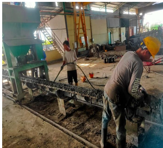
Gambar 3. 20 Pengisian moulding/pengecoran (Sumber : Dokumentasi KP 2023)
