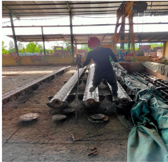
Gambar 3. 25 Pembongkaran cetakan/remoulding (Sumber : Dokumentasi KP 2023)
