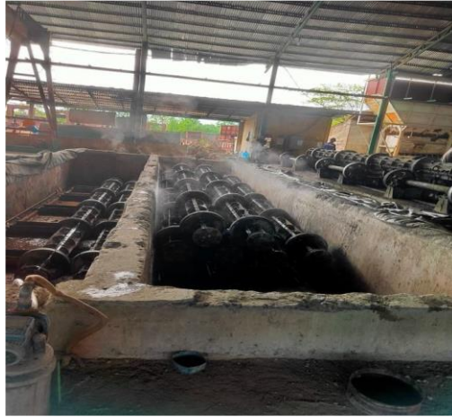
Gambar 3. 24 Proses steam curing/penguapan atau pengerasan (Sumber : Dokumentasi KP 2023)
