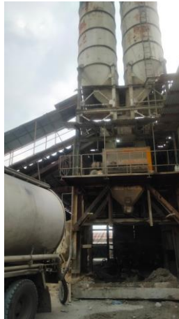
Gambar 3. 6 Pengadukan beton pada mesin beating plant (Sumber : Dokumentasi KP 2023)
