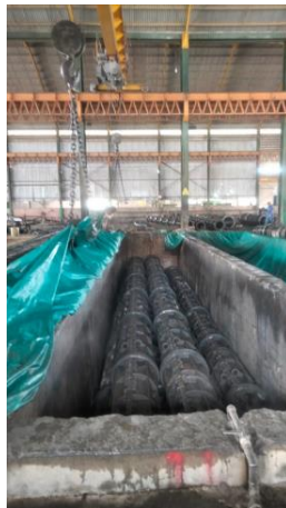
Gambar 3. 12 Proses steam curing/penguapan atau pengerasan (Sumber : Dokumentasi KP 2023)
