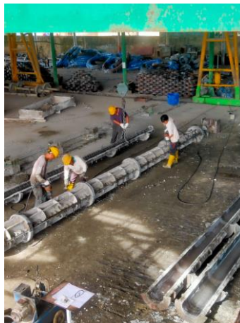
Gambar 3. 9 Pemasangan tutup cetakan/moulding (Sumber : Dokumentasi KP 2023)
