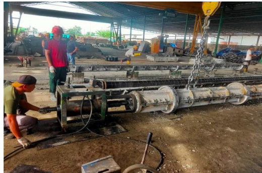
Gambar 3. 22 Proses stressing (Sumber : Dokumentasi KP 2023)
