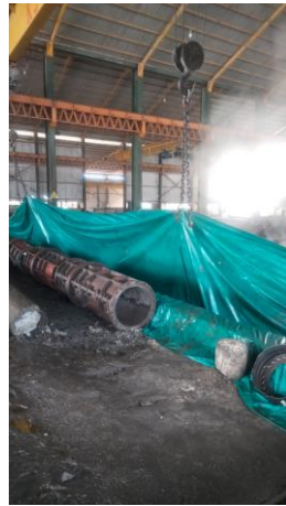
Gambar 3. 13 Pembongkaran cetakan/remoulding. (Sumber : Dokumentasi KP 2023)
