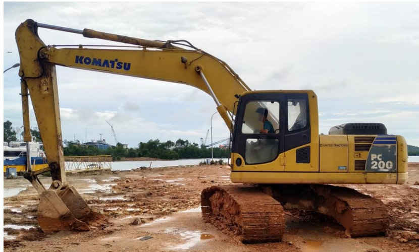
Gambar 1.13 Exavator di PT. Lestari Osean Indonesia. Sumber : Dokumentasi penulis
