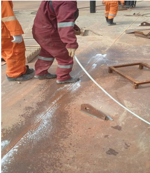
Gambar 2.6 Pengecekan kebocoran
