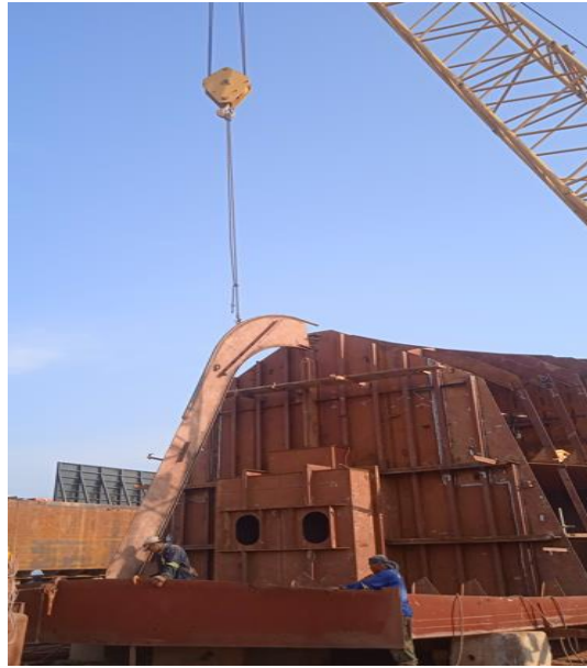
Gambar 5.13 Erection Girder keel
