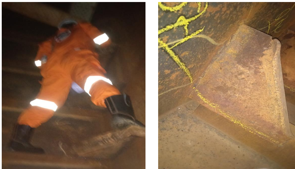
Gambar 6.4 Visual inspeks pada tanki
