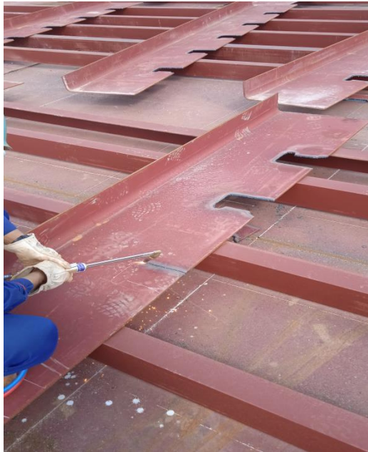
Gambar 3.12 Proses pemotongan lubang Noces
