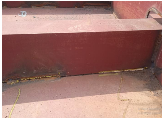
Gambar 3.37 Cacat pengelasan pada bagian Bottom
