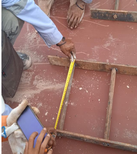
Gambar 4.11 Proses pembuatan tangga
