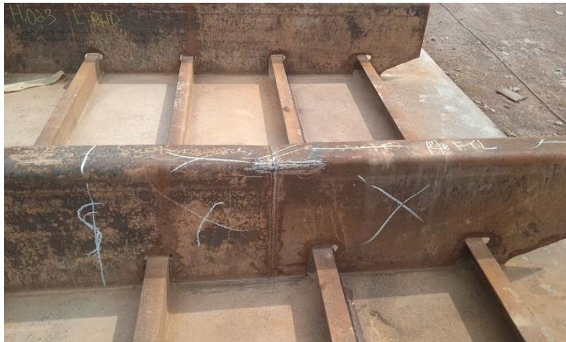
Gambar 4.3 Visual inspeks pada bagian T.bhd Hull 023
