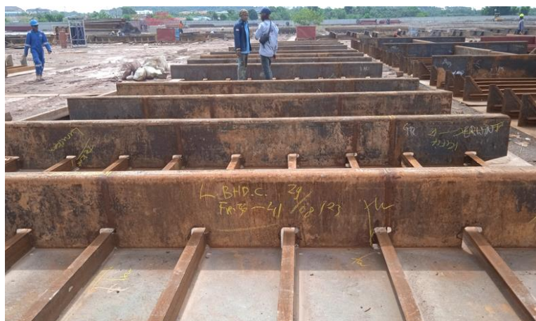
Gambar 3.31 Visual inspeks pada bagian L.bhd Hull 026 Sumber : Dokumentasi penulis
