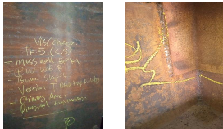
Gambar 2.1 Visual inspeks pada tanki
