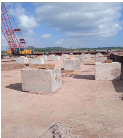
Gambar 3.7 Pemasangan batu tahu
