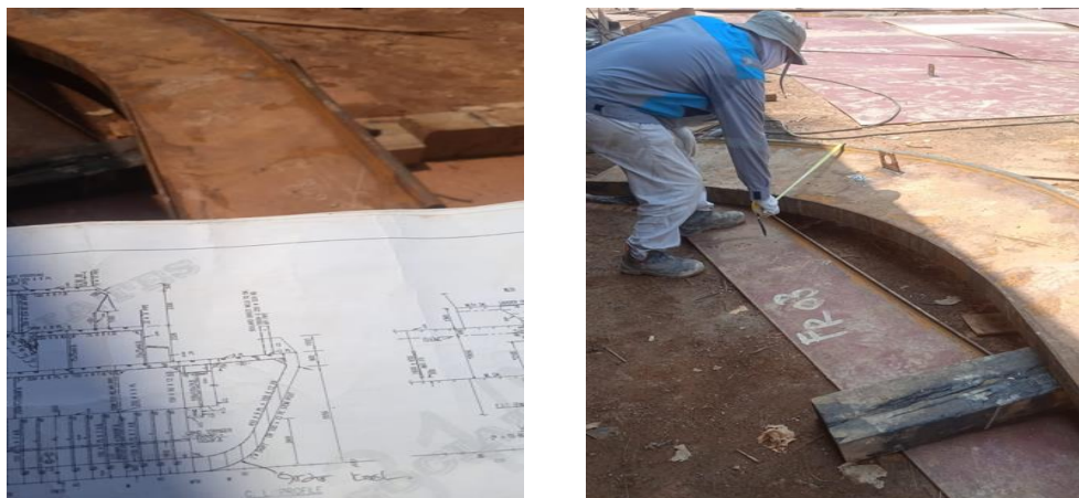
Gambar 5.10 Pengecekan Girder Keel
