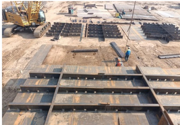
Gambar 2.62 Fabrikasi Bottom
