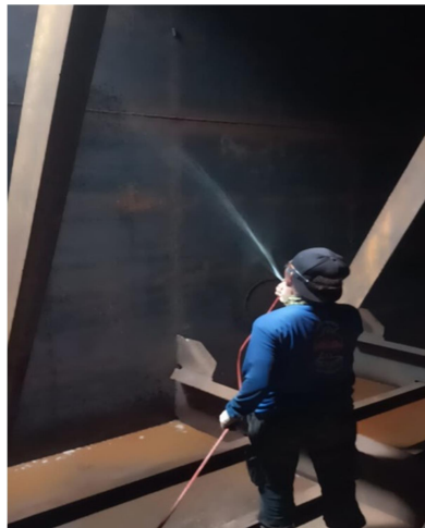
Gambar 3.23 Penyiraman area dalam tangki
