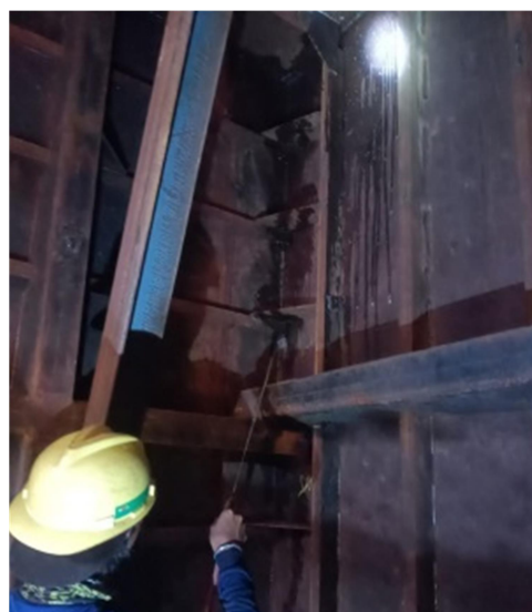
Gambar 3.17 Penyiraman area dalam tangki
