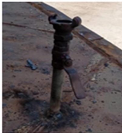
Gambar 3.11 Pipa sambungan tanki
