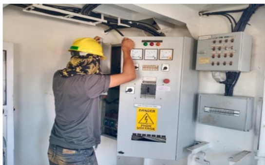
Gambar 2.9 Inspect Instalasi Listrik
