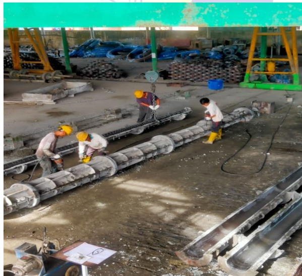
Gambar 3.22 Pemasangan tutup moulding
