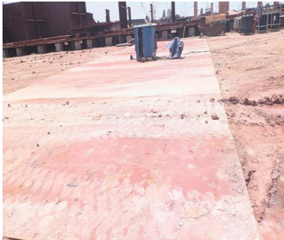
Gambar 2.114 Gambar joinan plat yang akan dijoin
