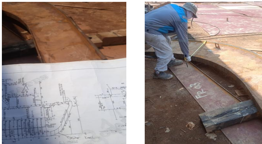
Gambar 2.136 Pengecekan Girder Keel
