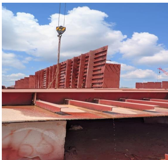
Gambar 2.99 Gambar proses pada saat erection L.bhd
