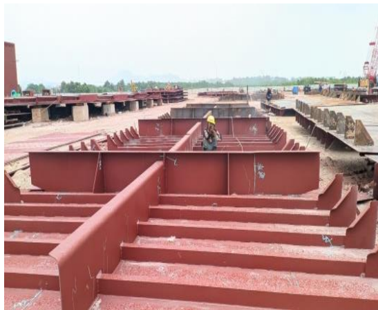
Gambar 2.66 Gambar T.bhd yang sudah di cleaning
