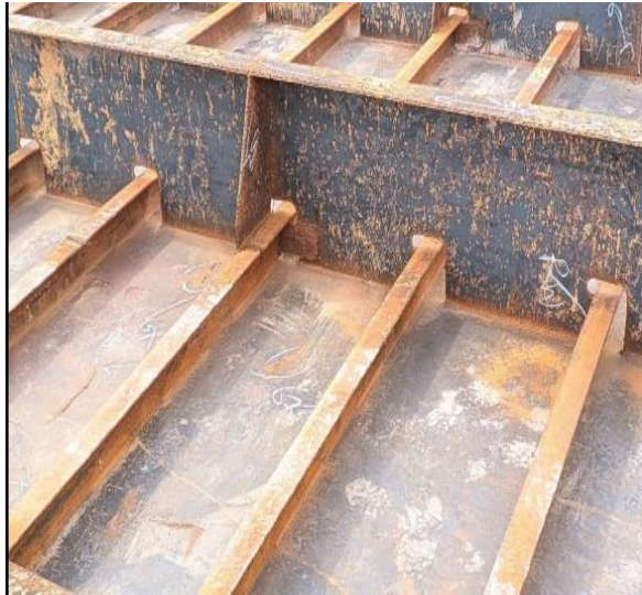
Gambar 2.70 Gambar bagian T.bhd yang sudah di cleaning
