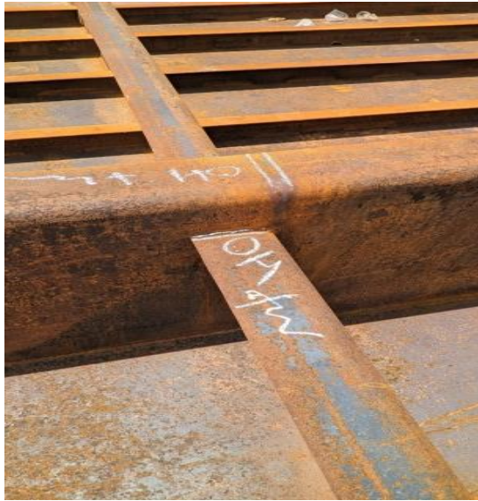
Gambar 2.68 Gambar overhear yang belum di welding Sumber : Dokumentasi Penulis
