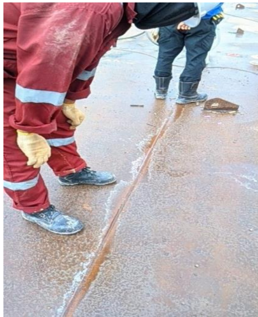
Gambar 2.10 Gambar pada saat melakukan pengecekan kebocoran
