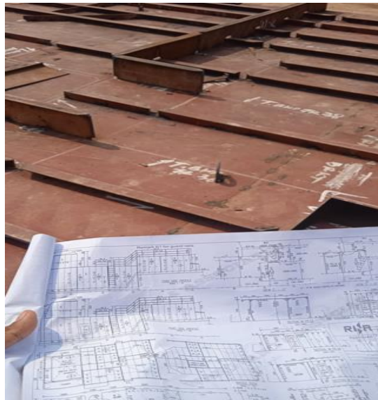
Gambar 2.130 Fitup Bridge House Sumber : Dokumentasi penulis
