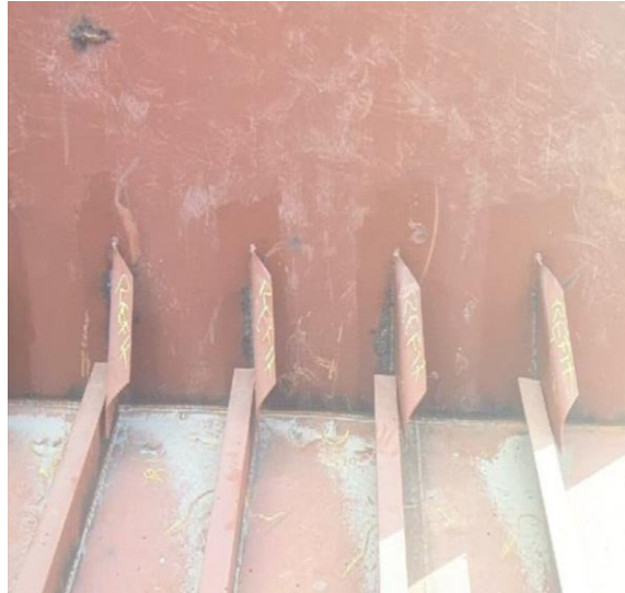
Gambar 2.105 Gambar refit pada braket
