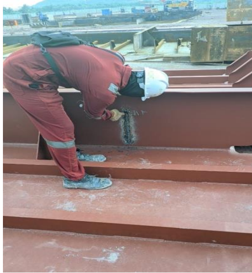
Gambar 2.41 Gambar pada saat menemukan cacatlas spatter
