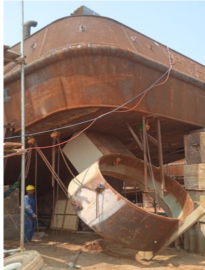
Gambar 2.133 Pemasangan Kort Nozzle
