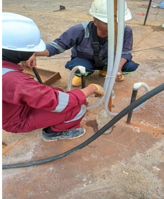
Gambar 2.15 Gambar pengisian angin pada cargo dack barge
