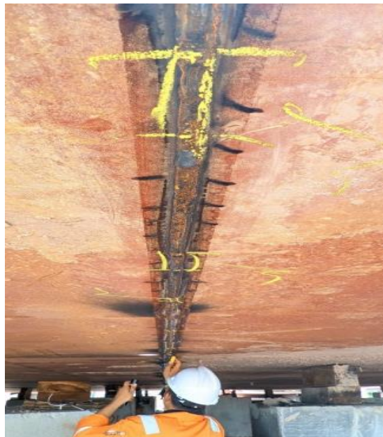
Gambar 2.82 Gambar pada saat pengecekan beking cramic
