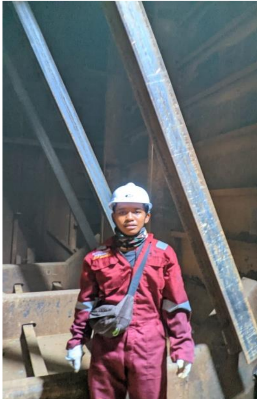
Gambar 2.1 Gambar visual inspek didalam tangki huul 011 Sumber : Dokumentasi Penulis
