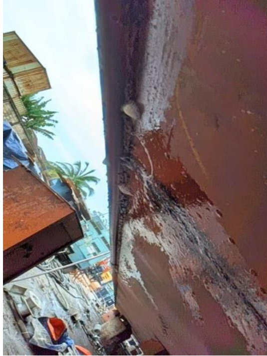
Gambar 2.8 Gambar pada saat mencari titik kebocoran pada joinan welding
