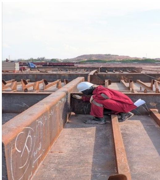
Gambar 2.43 Gambar pada saat melakukan visual inspek
