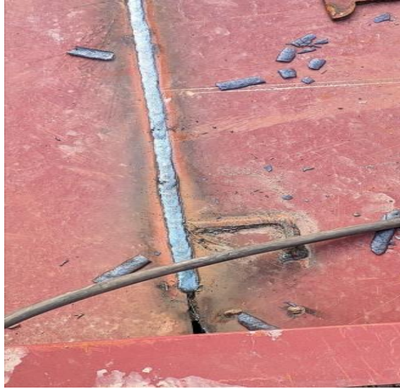
Gambar 2.81 Gambar joinan auto matic pada bottom plat
