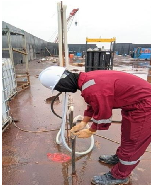
Gambar 2.9 Gambar melakukan pengisian angin pada tanki kapal
