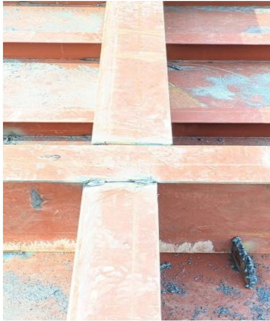
Gambar 2.84 Gambar girder yang refit
