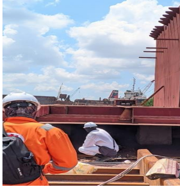
Gambar 2.101 Gambar pada saat owner melakukan pengecekan bottom
