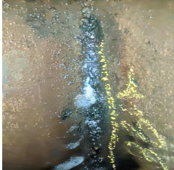
Gambar 2.29 Gambar salah satu titik kebocoran pada vertical T.bhd
