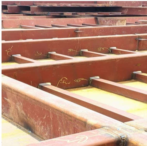
Gambar 2.88 Gambar pengecekan pada bottom di bagian hull 024
