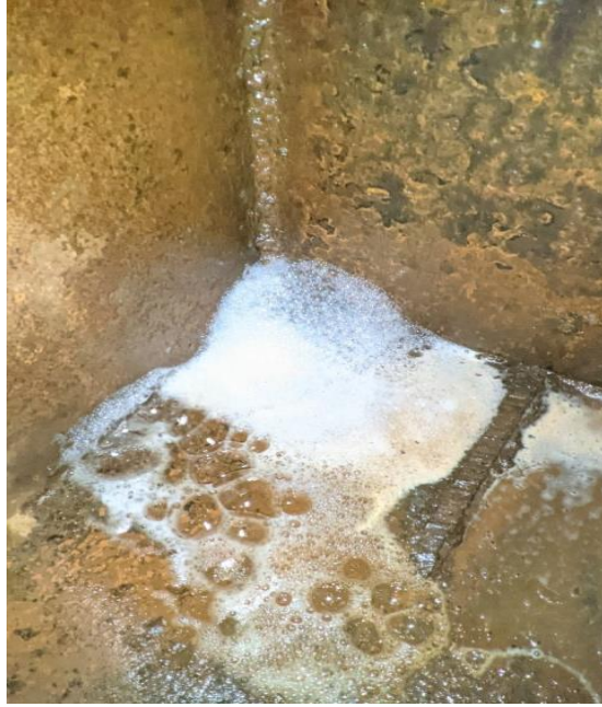
Gambar 2.27 Gambar salah satu titik bocor yang lumayan besar
