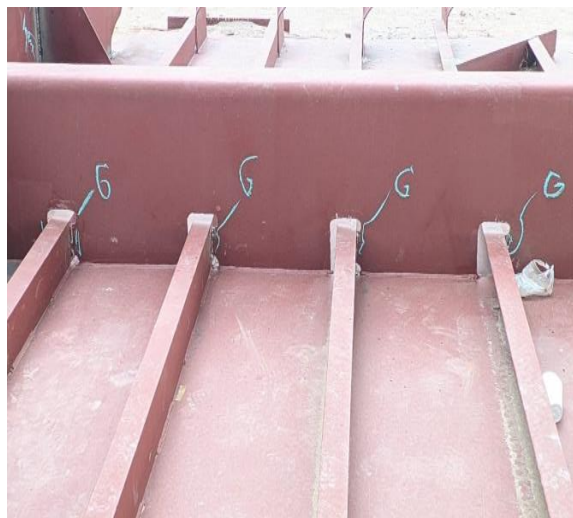
Gambar 2.62 Gambar bagian noces stifener
