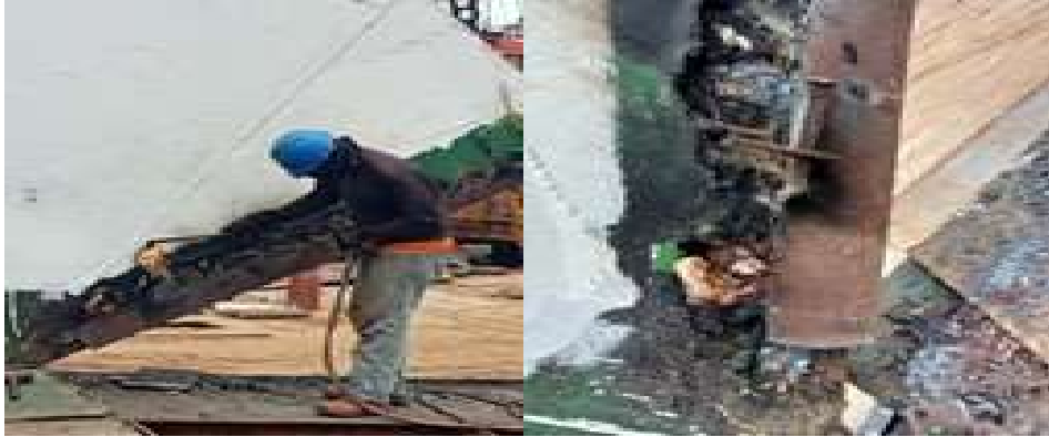
Gambar 2.94 Proses Pemotongan Plate Karet Kedap Ramp Door
