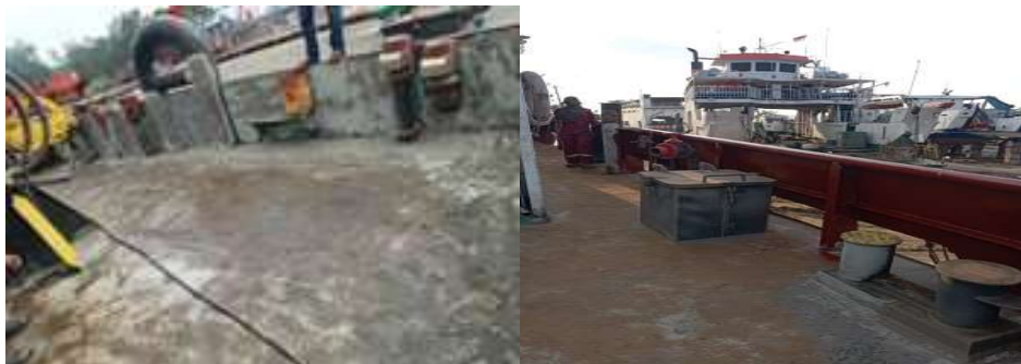
Gambar 3.18 Setelah di Sanblasting Area Main Deck-Internal Bulwark
