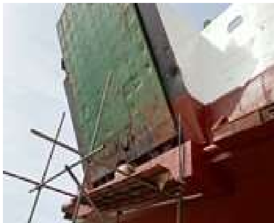
Gambar 2.131 Pemasangan Plat Ramp Door Buritan
