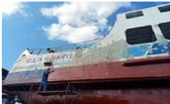
Gambar 2.126 Pengecatan Primer Coat
