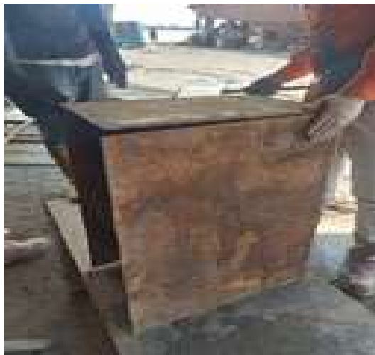
Gambar 2.76 Proses Pembuatan Box Expansi Baru
