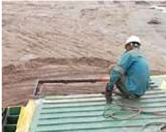
Gambar 2.134 Pemotongan Plat Ramp Door
