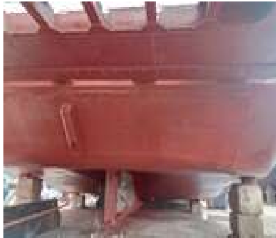
Gambar 2.83 Pengecatan Primer Coat Bottom
