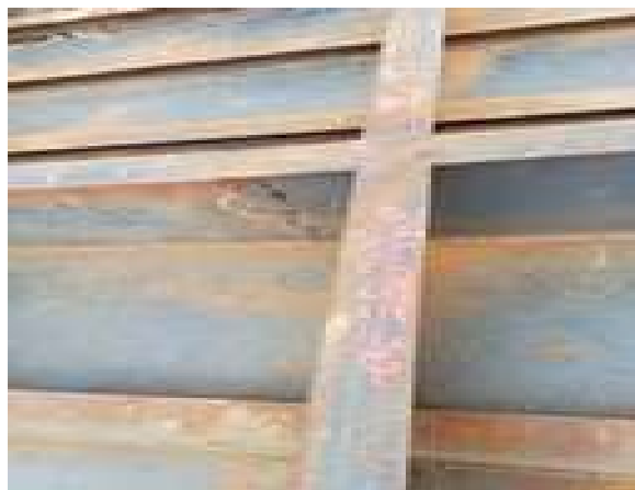
Gambar 2.8 Plat Yang Di Survey
