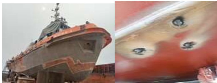
Gambar 2.47 Sandblasting Bottom Keel Ke Atas & Kebocoran
