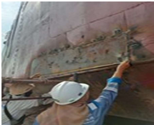
Gambar 2.10 Pengukuran Plat Yang Di Replating
