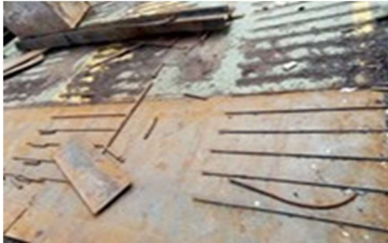
Gambar 2.105 Pemasangan Anti Slip
