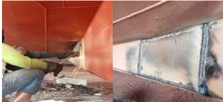
Gambar 2.89 Proses Pemasangan Plat Skeg
