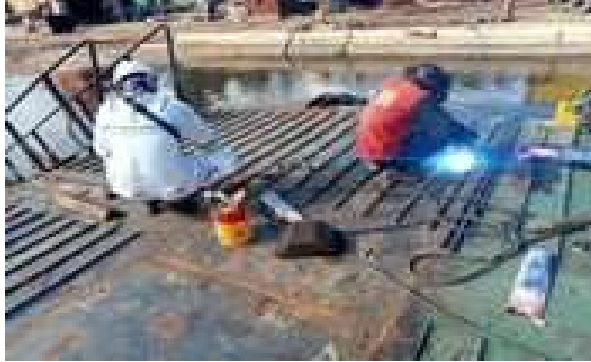
Gambar 2.147 Pemasangan Anti Slip
