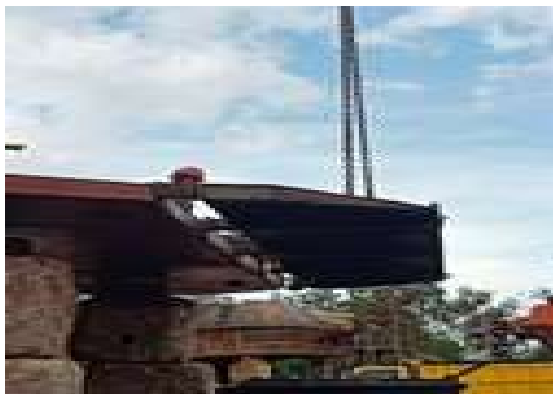
Gambar 2.104 Pemasangan Lidah Ramp Door
