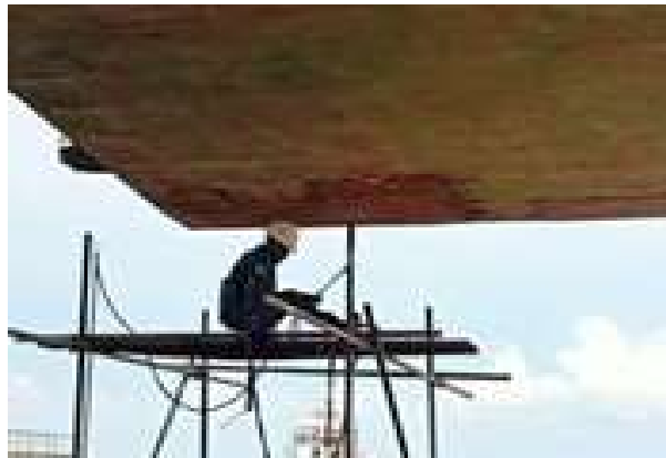
Gambar 2.141 Pemasangan Plat Bawah Ramp Door
