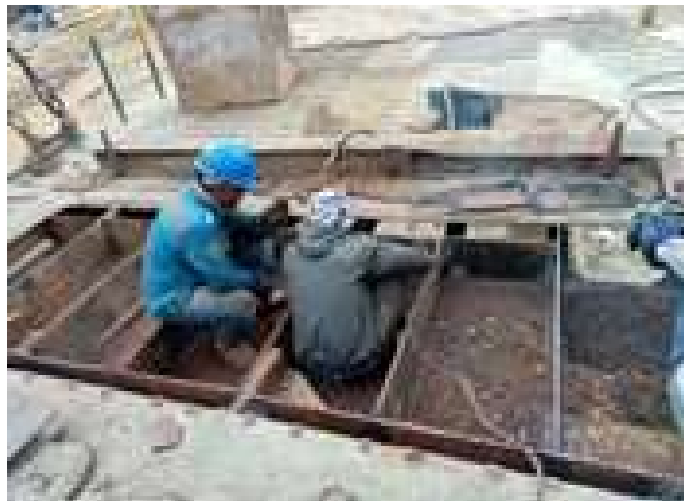
Gambar 2.86 Pemasangan Tulangan Ramp Door
