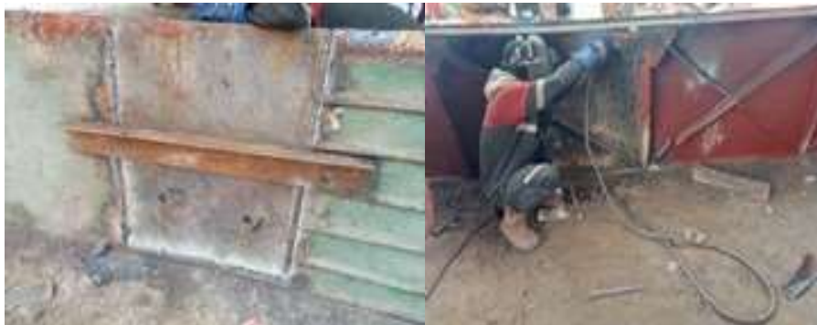
Gambar 2.99 Proses Pemasangan Plat Lidah Ramp Door
