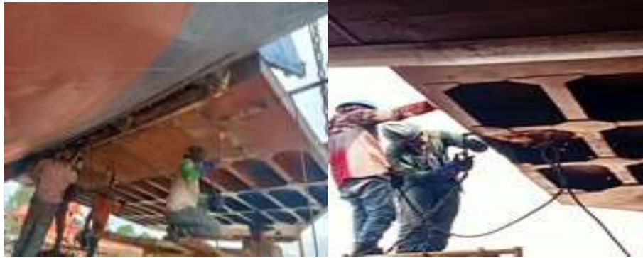
Gambar 2.107 Proses Pemasangan Plat TOP
