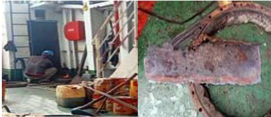
Gambar 2.119 Proses Pemotongan Sekat Pintu Store
