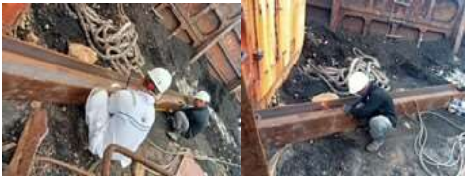
Gambar 2.142 Proses pengukuran dan pemotongan H Beam
